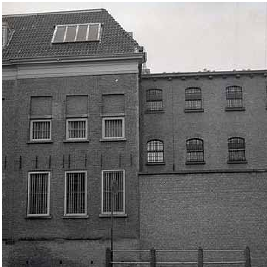
Afbeelding 16. De voorgevel van BdA kort voor de verbouwing in 1959. Foto: Collectie Beeldbank Leeuwarden, documentnr.: HCL001041198.
