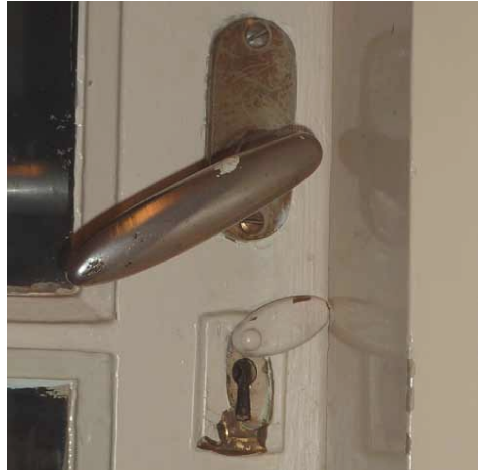
Afbeelding 99. Detail van het vernikkelde hang- en sluitwerk (1959).
