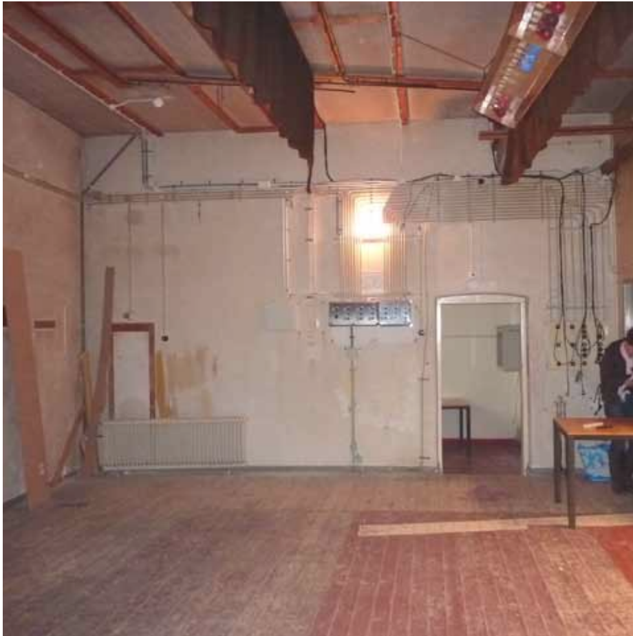
Afbeelding 111. Overzicht van de zuidwand van het podium met de doorgang naar het aangrenzende bouwdeel E.
