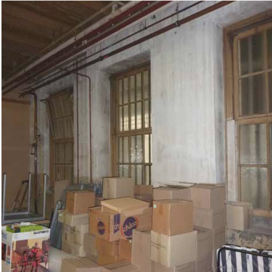
Afbeelding 49. Overzicht van ruimte F0.17 gezien richting het zuidoosten (binnenplaatszijde). De oostwand (geheel links) is voorzien van gipsplaat, de overige wanden zijn gepleisterd
