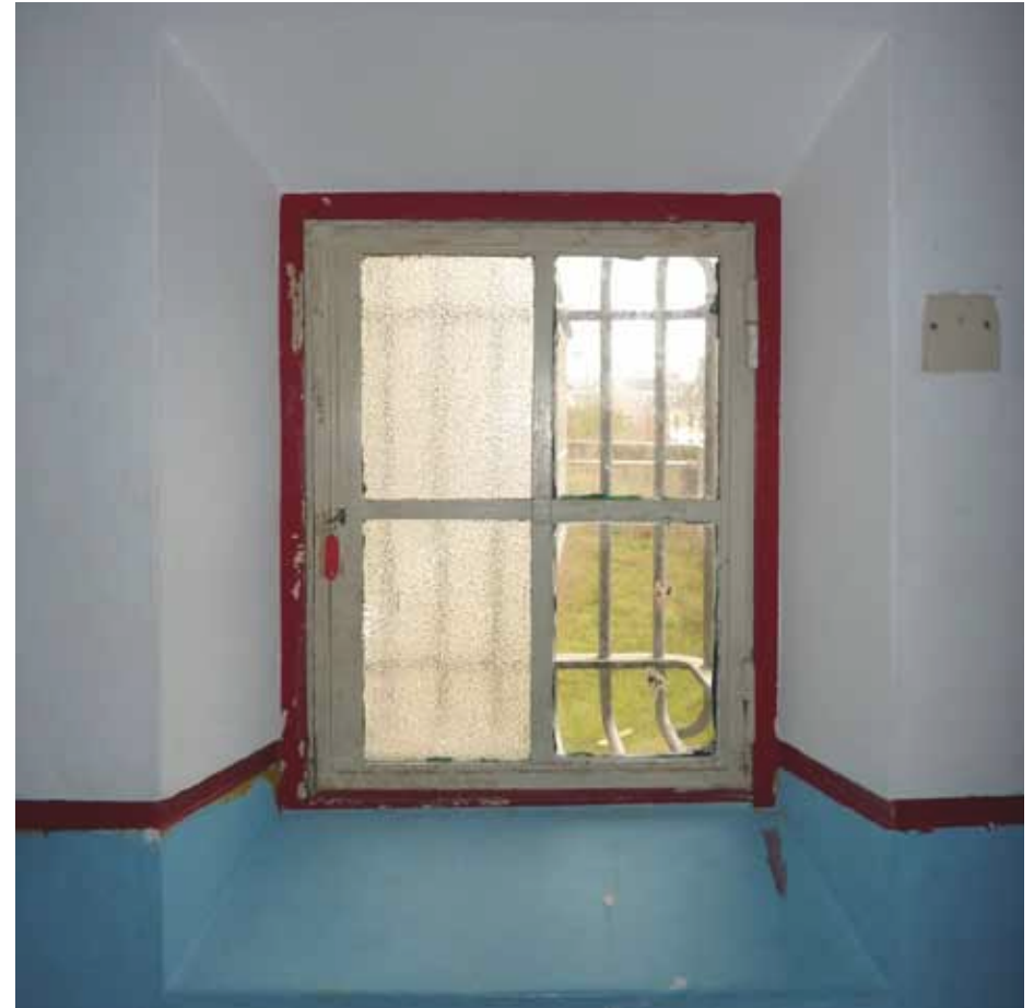
Afbeelding 81. Detail van een vierruits ijzeren raam in de westgevel (1959). De gestucte lambrisering werd hier in de dagkanten doorgezet.
