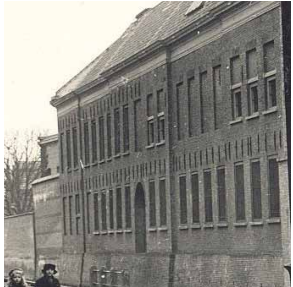
Afbeelding 15. Detail van de voorgaande afbeelding. In het linker gedeelte van de gevel waren de gevelankers van de zoldervloer nog aanwezig, in het rechter gedeelte waren deze reeds verwijderd in verband met het realiseren van de kerk. Een deel van de vensters was blind, een deel had getraliede openingen over de volledige hoogte en een aantal bezat openingen over de halve hoogte voorzien van lateien. Foto: Collectie Beeldbank Leeuwarden, documentnr.: FDKEIZGRA016.
