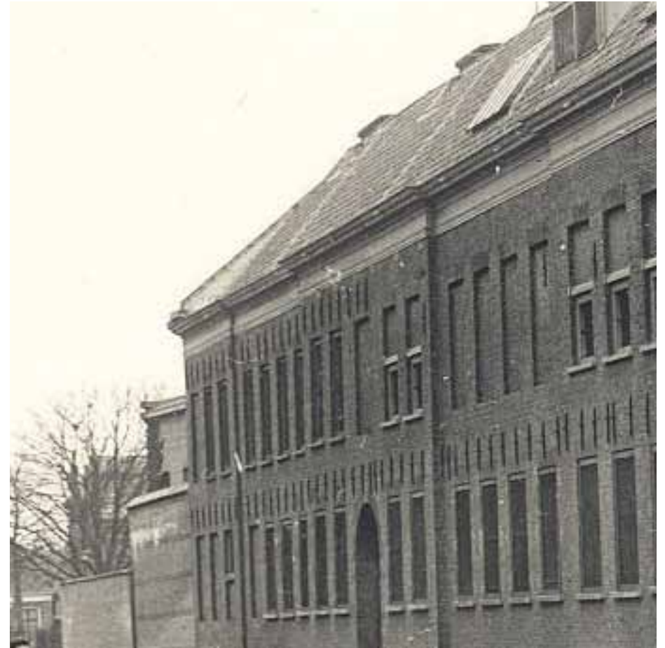
Afbeelding 39. Detail van een foto van de voorgevel BdA uit 1929. Links steekt de kopgevel iets boven het dakvlak uit. Bij de renovatie van de zolderverdieping in 1959 werd ook deze hoek aangepast en werden de dakhellingen via één hoekkeper goed op elkaar aangesloten. Foto: Collectie Beeldbank Leeuwarden, documentnr.: FDKEIZGRA016.
