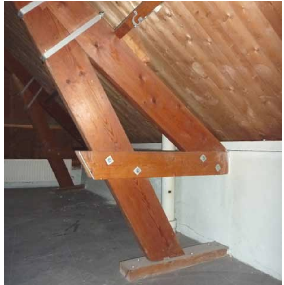
Afbeelding 116. Detail van de kappantten aan de oostzijde van de zolderruimte. Deze spanten werden tijdens de verbouwing van 1959 eveneens gewijzigd ten einde de dakvalken van de gevels van de bouwdelen A en E goed op elkaar te laten sluiten.
