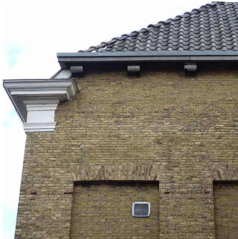
Afbeelding 21. Bovenste deel van de rechter zijgevel. De borstwering werd opgehoogd ten behoeve van een goede aansluiting op de goot van Bouwdeel I (1896). De grijs gecementeerde kop betreft de dichtzetting van een voormalig balkanker.
