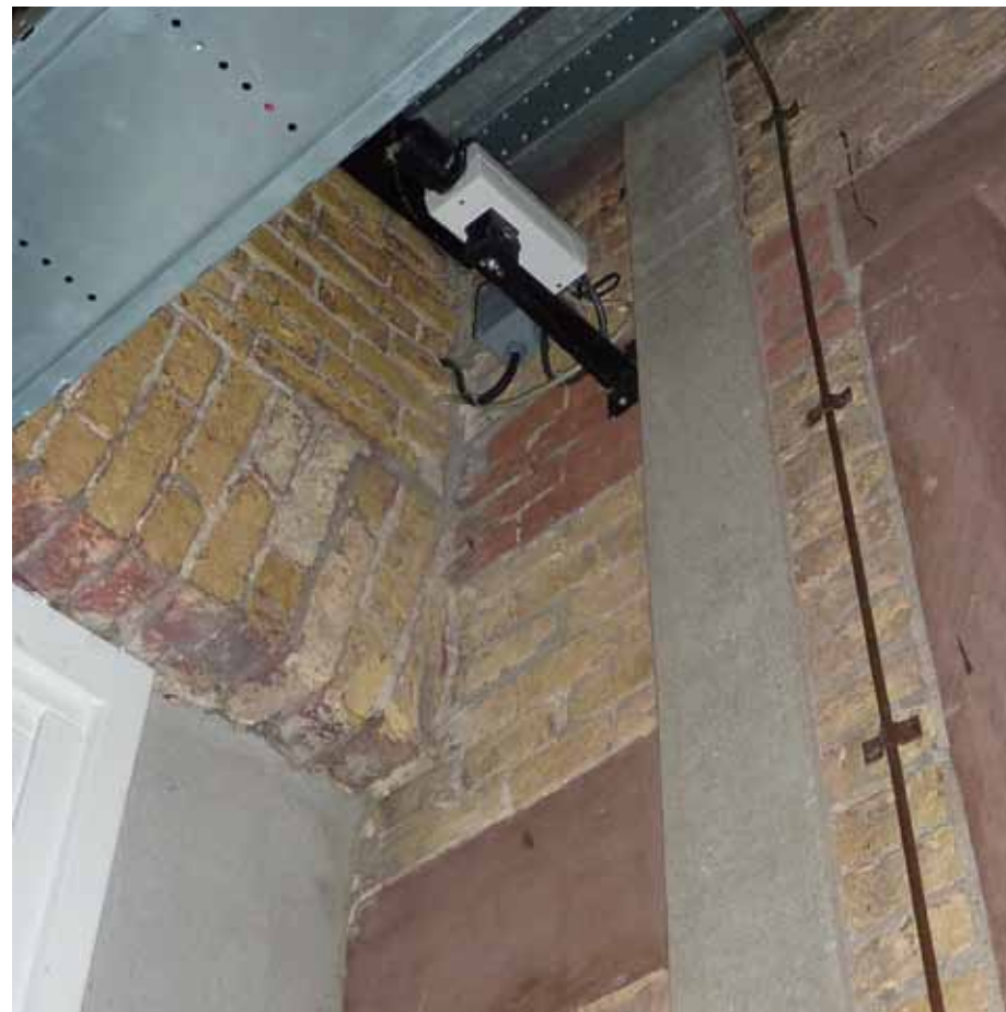
Afbeelding 31. Detail van de voorgaande afbeelding met de aansluiting tussen de binnenplaatsgevel en de traptoren van bouwdeel E (1875). Het deurkozijn links is secundair (1988), evenals de cementvulling. Op de onderzijde van de hanekam bevinden zich rode verfsporen, behorende bij de oorspronkelijke geschilderde speklagen en hanekammen uit de eerste bouwfase (1822).
