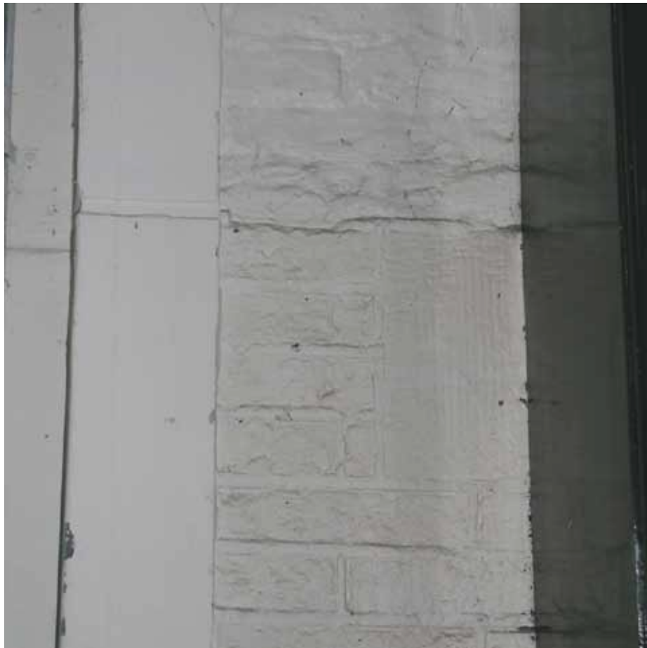
Afbeelding 60. Detail van de toog boven de poortdeuren naar de binnenplaats in ruimte F0.13. Deze toog betreft secundair metselwerk (1877). De duimblokken bestaan uit gefrijnd hardstenen blokken. De poortdeuren bevonden zich oorspronkelijk aan de binnenzijde van de gevel.
