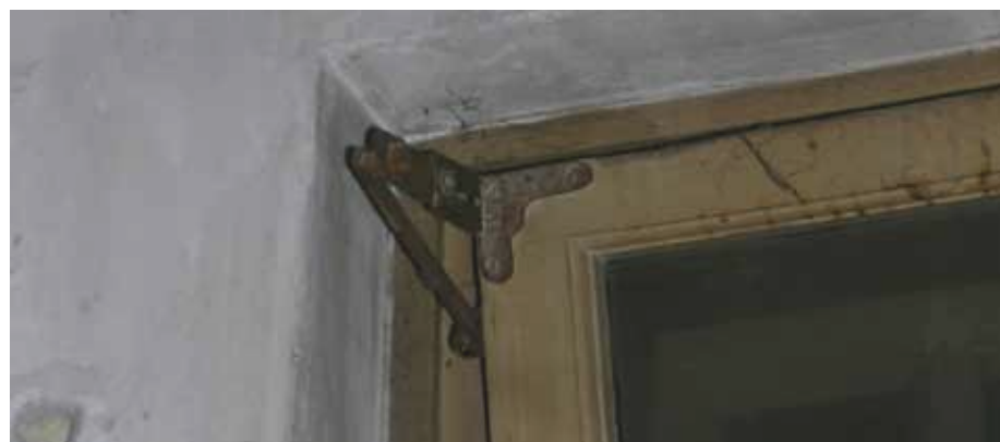
Afbeelding 56. Detail van één van de vensters in de achtergevel (zuidzijde) van ruimte F0.17 met het scharniermechanisme van het valraam.
