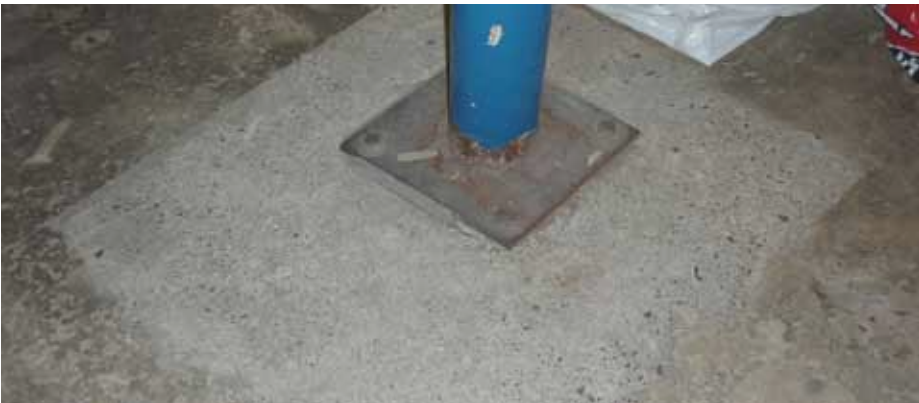
Afbeelding 52. Onderzijde van één van de kolommen in ruimte F0.17. De instorting rond de voet van de kolom geeft aan dat deze secundair is ten opzichte van de vloer (1988).
