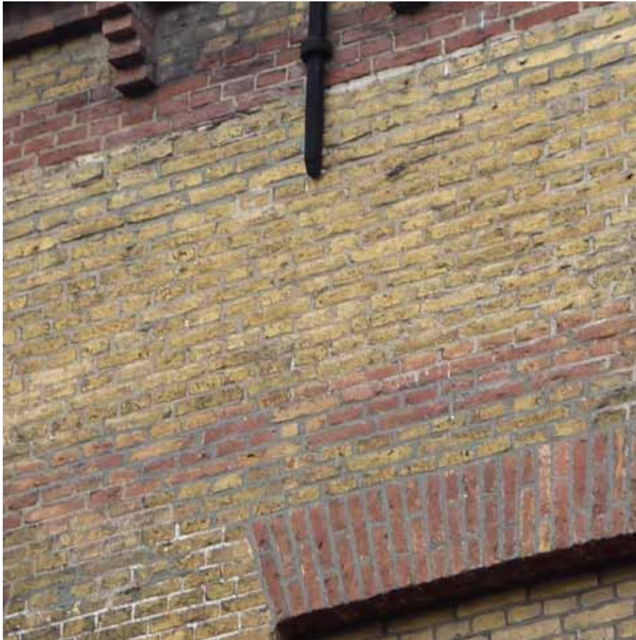
Afbeelding 34. Detail van de achtergevel ter hoogte van de goot. De bovenste speklaag is uitgevoerd in helderrode baksteen, voorzien van cementvoegen en hoort bij de modernisering van de kap (1877). De onderste speklaag is in licht oranjebruine bakstenen uitgevoerd en behoort tot de eerste bouwfase (1822). Deze speklagen, alsmede de hanekammen waren oorspronkelijk vermoedelijk geschilderd.
