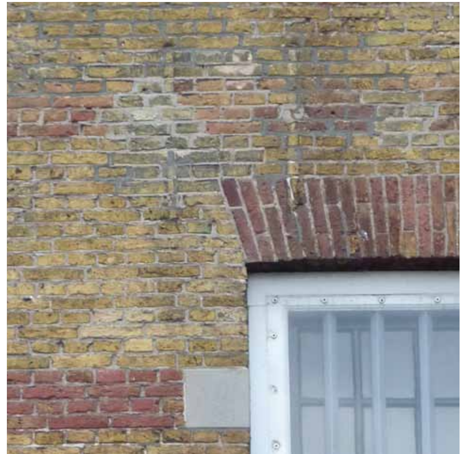
Afbeelding 35. Detail van de achtergevel ter hoogte van de zoldervloer. Op de gevel tekenen zich voormalige balkankers van de zoldervloer af, die in 1959 vervangen werd door een betonvloer. De twee ankers markeren waarschijnlijk de strijk balken langs een tussenliggende voormalige brandmuur.
