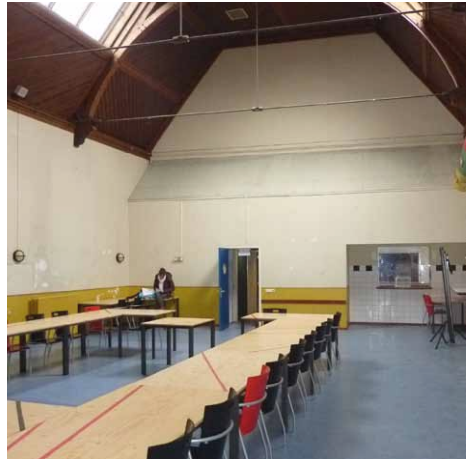
Afbeelding 125. Zicht op de in 1988 uitgebouwde toiletgroep in de oostwand van de kerkruimte. Verwijdering van deze toiletgroep maakt het herstel van de oorspronkelijke ruimte weer mogelijk.
