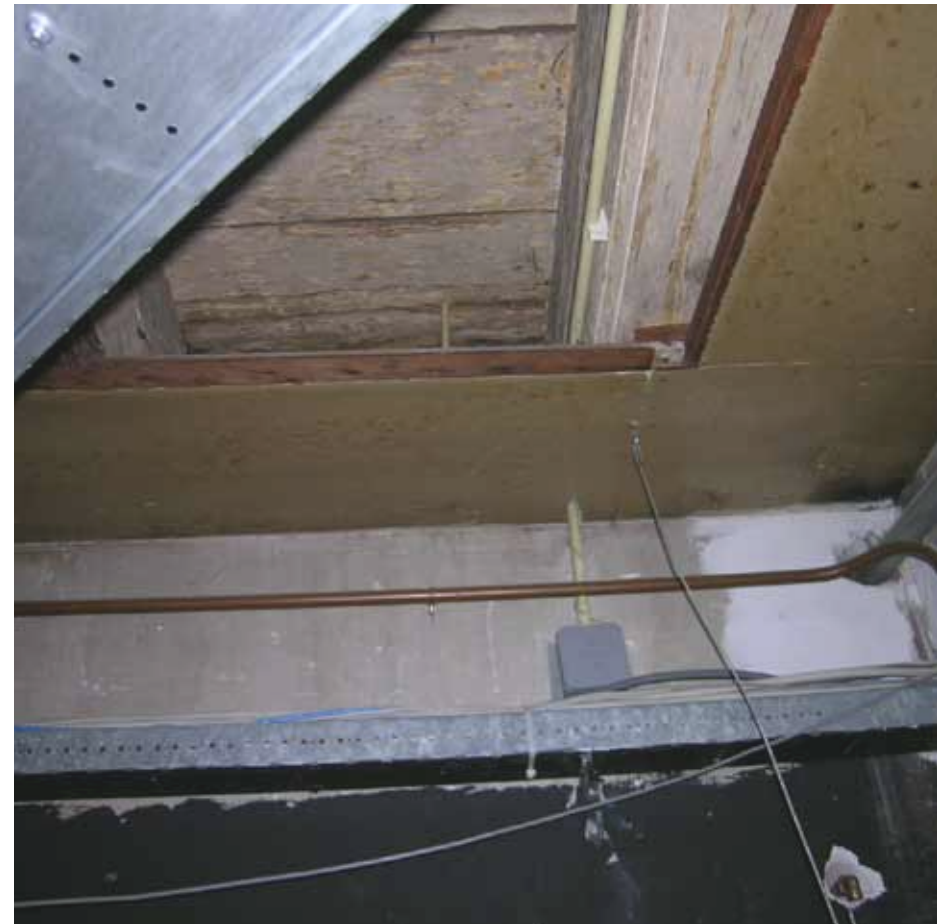
Afbeelding 61. Zicht op de balklaag en resten van het plafond boven ruimte F0.13, gezien richting het zuiden (achtergevel). De 19 de -eeuwse balklaag werd vermoedelijk tijdens de verbouwing van 1959 van een verlaagd triplex plafond voorzien, waarvan het middenpaneel ontbreekt.
