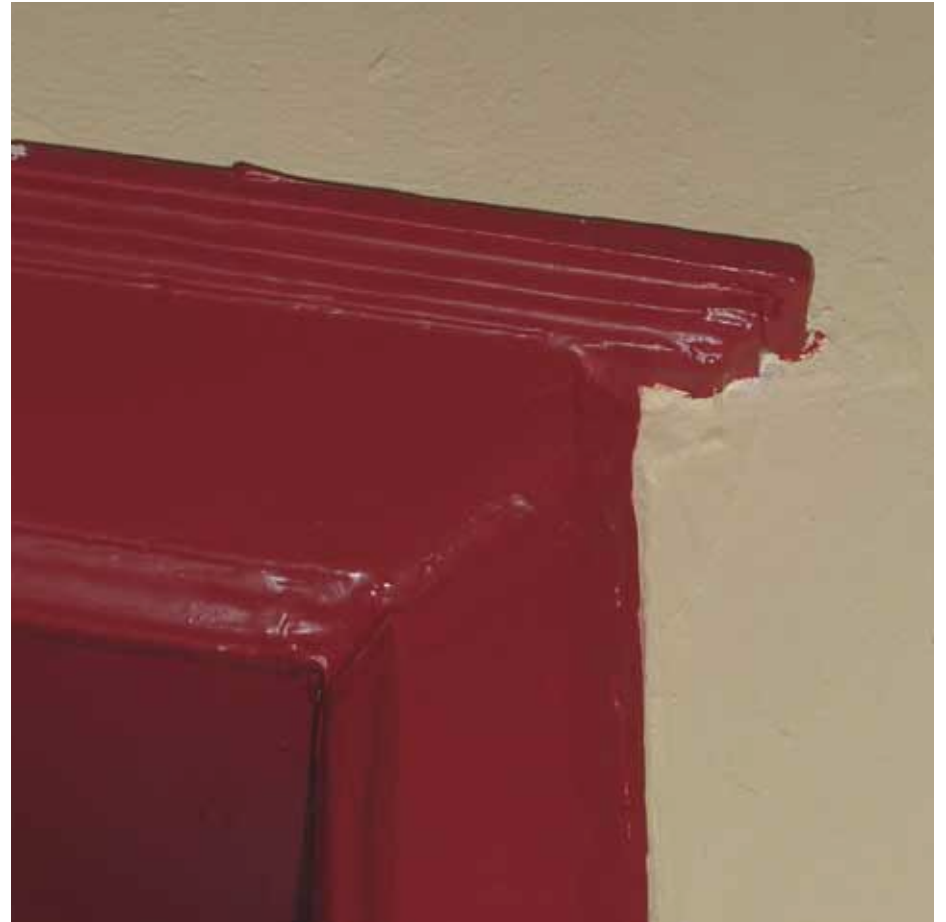
Afbeelding 97. Detail van de vorige afbeelding met de aftimmerlijsten uit 1875 en de erboven geplaatste geprofileerde sierlijst uit 1959.
