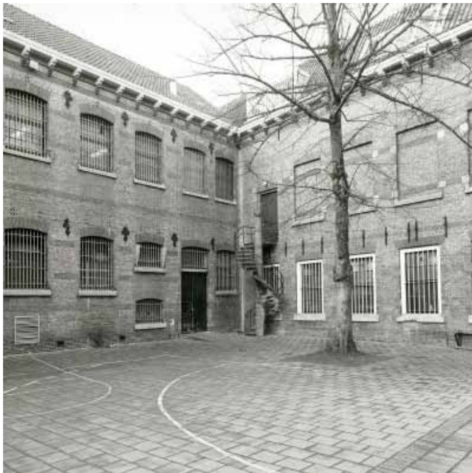
Afbeelding 36. De binnenplaatsgevel van BdA kort na de verbouwing uit 1959. De betonnen wenteltrap naar de kerk is reeds aanwezig. Foto: Collectie Beeldbank Leeuwarden, documentnr.: HCL001041198.
