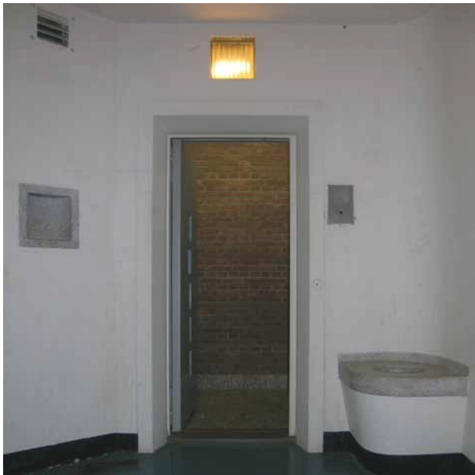
Afbeelding 74. Zicht in één van de twee isoleercellen, gezien naar het oosten (1951). Rechts een closet voorzien van een terrazzo vaste wc-bril.
