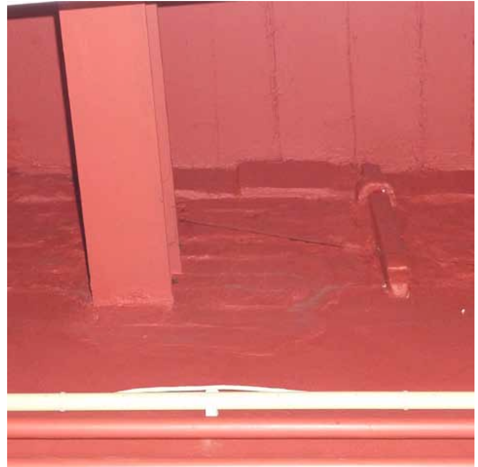
Afbeelding 48. Metselwerk wand tussen het linker en rechter gedeelte van ruimte F0.02 gezien richting het oosten. De HE-liggers werden recentelijk secundair in de wand ingebroken. Het muuranker rechts behoort bij de in 1875 aangebrachte balklaag boven de bibliotheek, die tijdens de bouw van bouwdeel E geheel vernieuwd werd.
