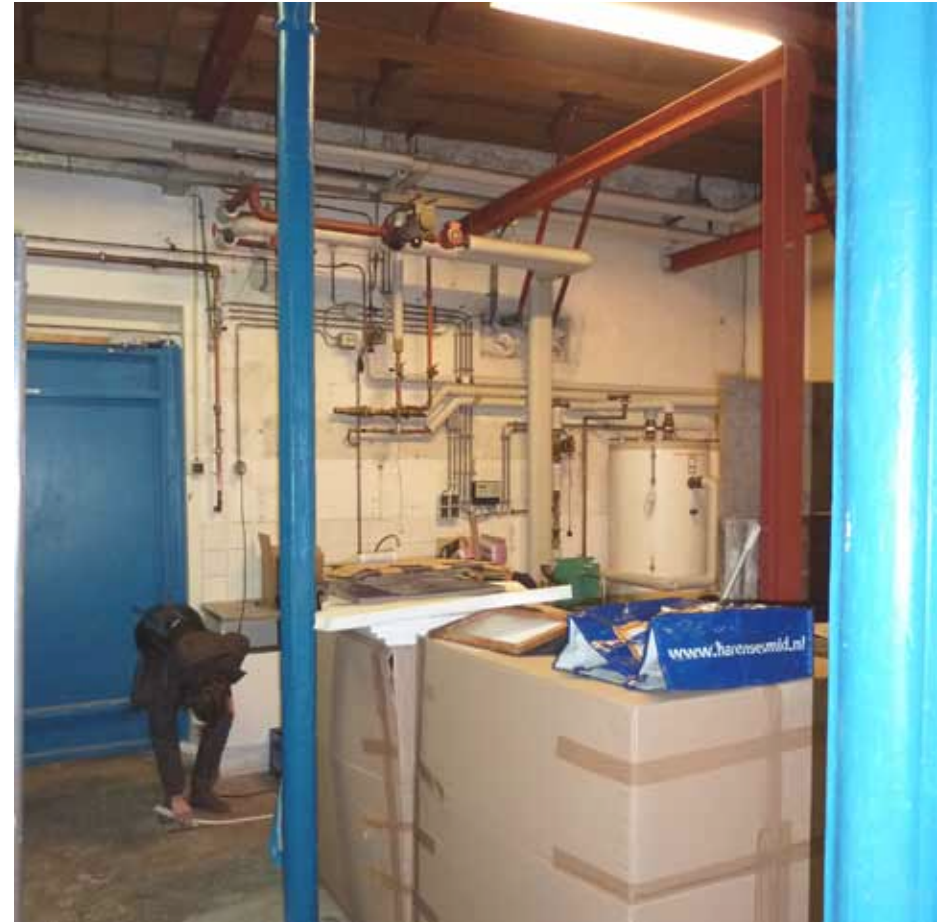
Afbeelding 50. Overzicht van ruimte F0.17 gezien richting het westen. De enkelvoudige balklaag wordt ondersteund door een stalen onderslagbalk en een drietal gietijzeren kolommen. Links van de deuren naar de entree zijn recent verschillende installatievoorzieningen aangebracht, waaronder twee boilers.
