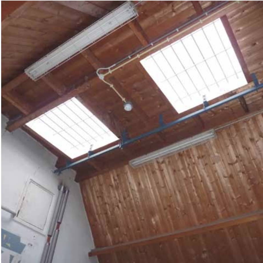
Afbeelding 115. Zicht in de kapconstructie van de zolderruimte met vuren dakbeschot en een tweetal daklichten (1959).
