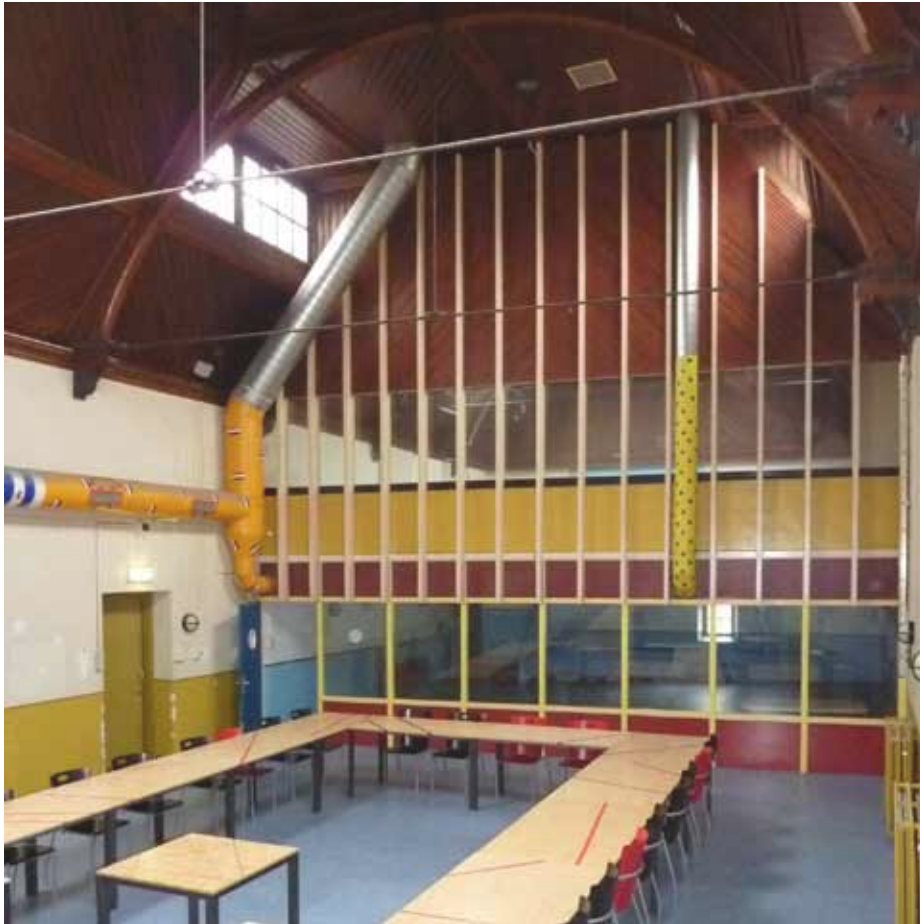
Afbeelding 76. Overzicht van de recreatieruimte, de voormalige kerk, naar het westen met de recente scheidingswand (1988) en daarachter de entresol.
