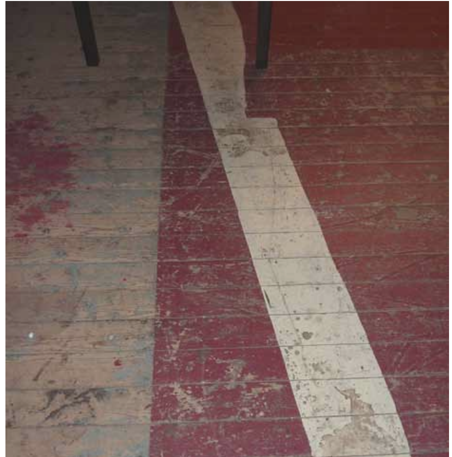
Afbeelding 112. Detail van de podiumvloer met de sporen van de trapeziumvormige opgestelde coulissen.
