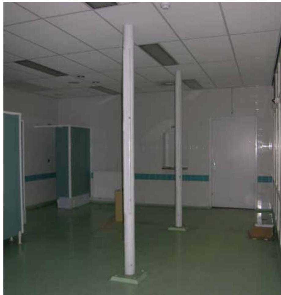
Afbeelding 129. Zicht in één van de ruimten op de begane grond. De ruimten bezitten een indifferente monumentwaarde en kunnen redelijk vrij opnieuw ingedeeld en aangepast worden. De 19de-eeuwse gietijzeren kolommen zijn hier hergebruikt (1959) en kunnen desgewenst gewijzigd of verwijderd en elders hergebruikt worden.
