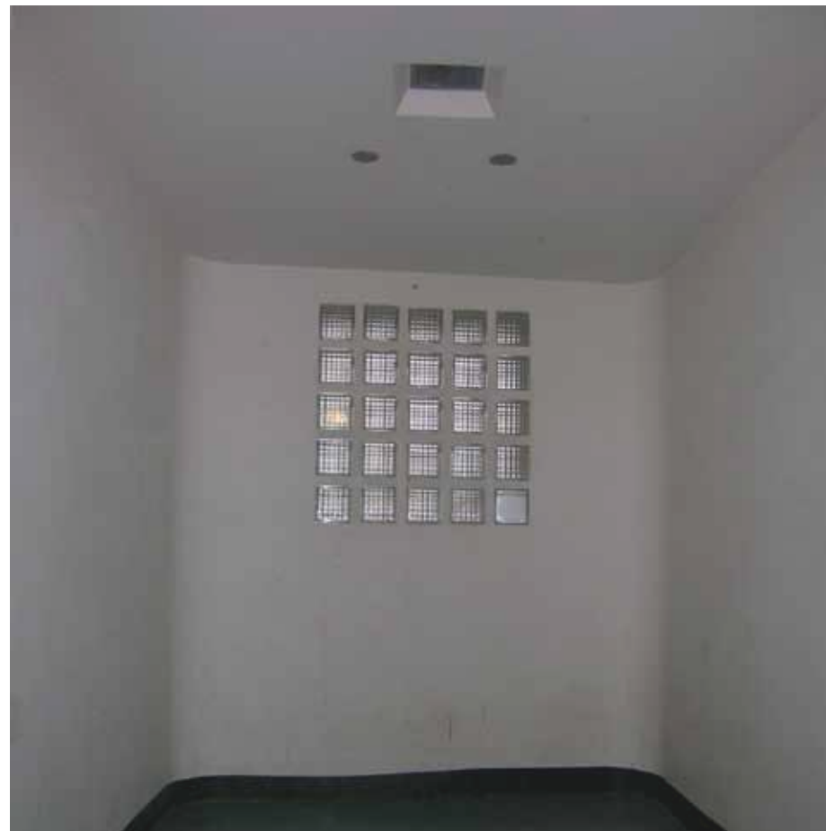
Afbeelding 75. Zicht in in één van de twee isoleercellen naar het westen. De ruimte is voorzien van een venster uit glazen bouwstenen (1951).
