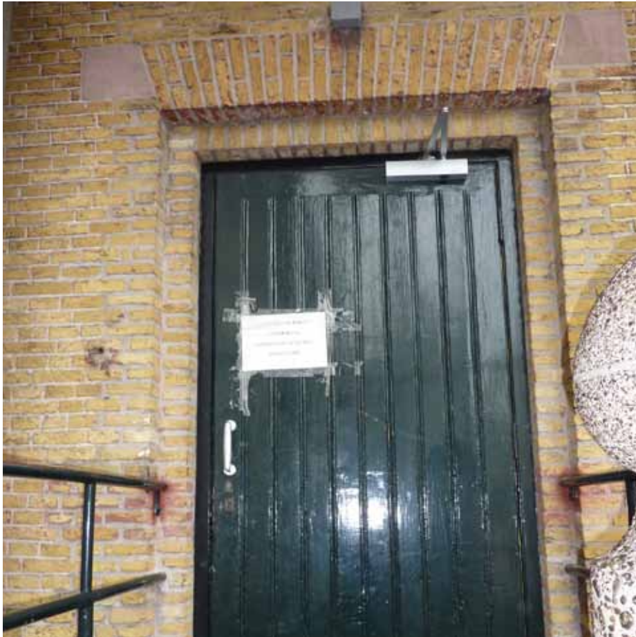
Afbeelding 32. Detail van de achtergevel ter hoogte van eerste verdieping met de toegangsdeur naar de kerk. De deur werd secundair ingebroken en behoort tot de verbouwing van 1959.
