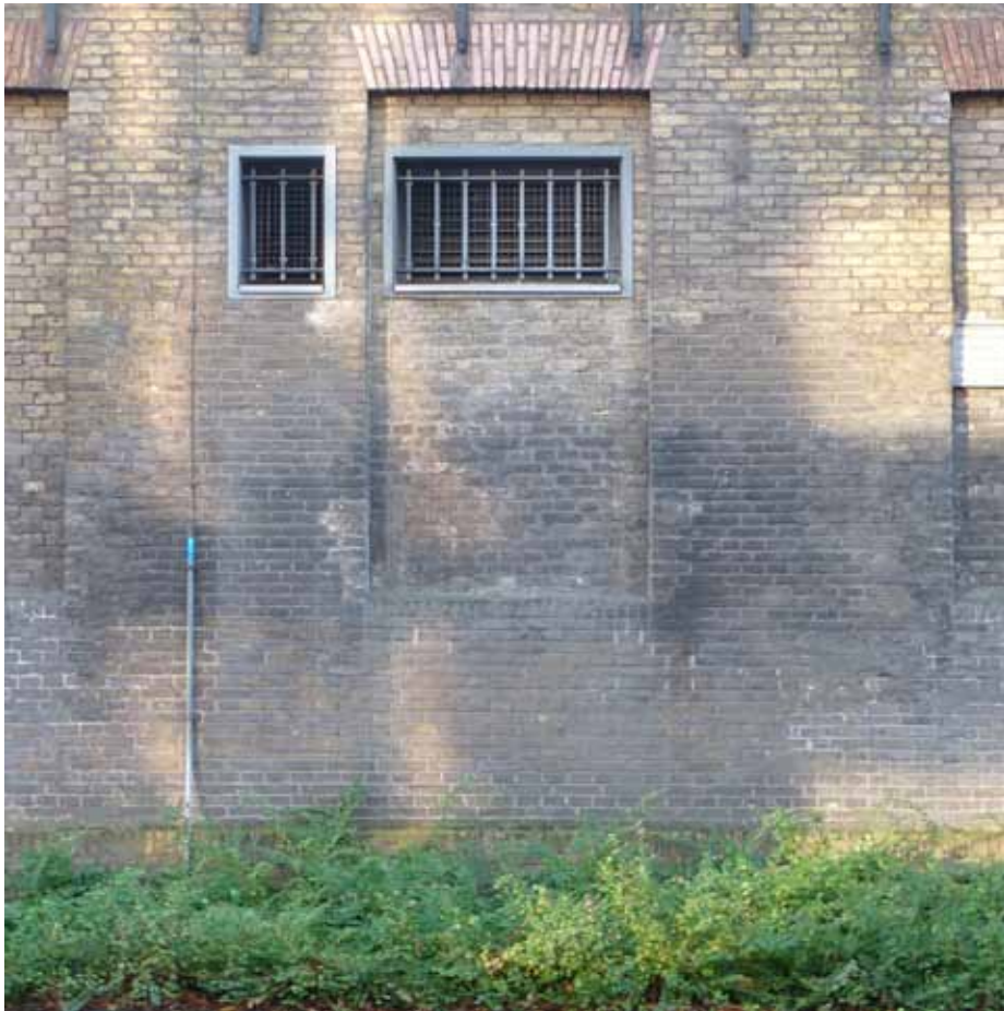
Afbeelding 8. Middenrisaliet ter plaatse van de voormalige poort. Bij het dempen van de Keizersgracht in 1959 is de poort ingevuld en vervangen door een venster. Het venster is vermoedelijk tijdens de verbouwing van 1988-1991 dichtgezet en vervangen door een ventilatieopening.
