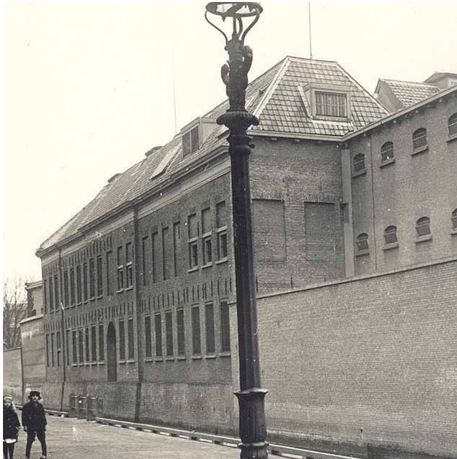
Afbeelding 14. De voorgevel van BdA in 1929. De Keizersgracht werd in 1959 gedempt, waarbij tevens de poort werd dichtgezet en de ommuring verhoogd. In 1929 werd het schilddak nog gedekt door vlakke Friese blauw geglazuurde pannen, deze werden later vervangen door Romaanse pannen (1959). Foto: Collectie Beeldbank Leeuwarden, documentnr.: FDKEIZGRA016.
