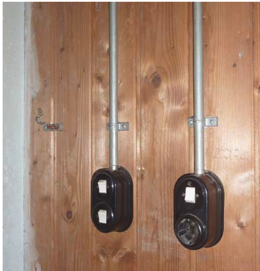
Afbeelding 120. Detail van het electrawerk met opbouw wandcontactdozen en schakelaars (1959).
