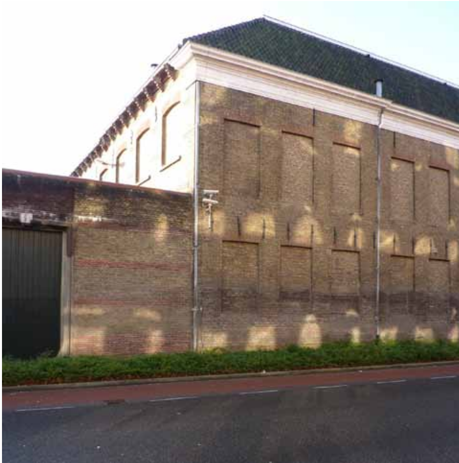
Afbeelding 38. Overzicht van de linker zijgevel van Bouwdeel A. De gevel werd bij de bouw van bouwdeel E in 1875 vernieuwd.
