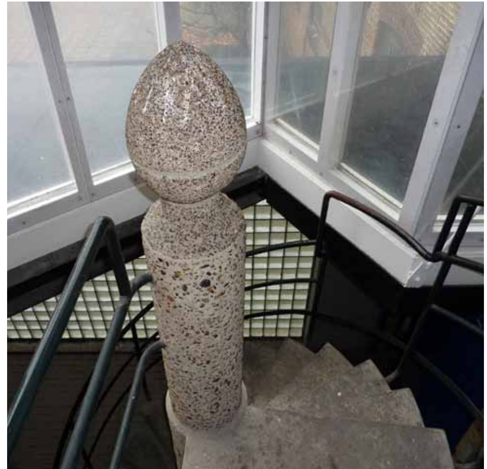
Afbeelding 25. Detail van de trap aan de achtergevel ter hoogte van de eerste verdieping. De betonnen trap (1959) stond tot 1991 buiten waardoor de knop een ververing aan de bovenzijde kent.
