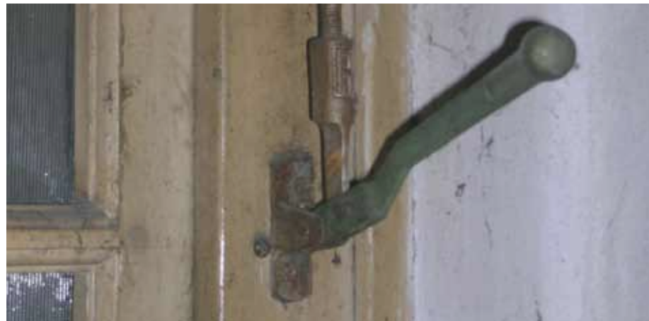
Afbeelding 55. Detail van één van de vensters in de achtergevel (zuidzijde) van ruimte F0.17. Op de beleglat, afkomstig van de detaillering van het schuifraam, is eenvoudig maar zorgvuldig uitgevoerd beslag aangebracht (vermoedelijk 1906), waarmee het valraam te openen is.
