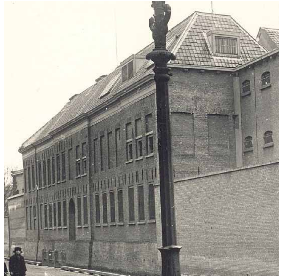
Afbeelding 19. Detail van foto van voorgevel en rechter zijgevel van Bouwdeel A uit 1929. Hier is de ophoging van het metselwerk in de rechter zijgevel (1894) onder de goot, i.v.m. het realiseren van het aangrenzende Bouwdeel I, goed te zien. Rechts in deze gevel is een klein venstertje nog open. Tevens zijn de oude pannen vlakke Friese pannen goed zichtbaar. Foto: Collectie Beeldbank Leeuwarden, documentnr.: FDKEIZGRA016.
