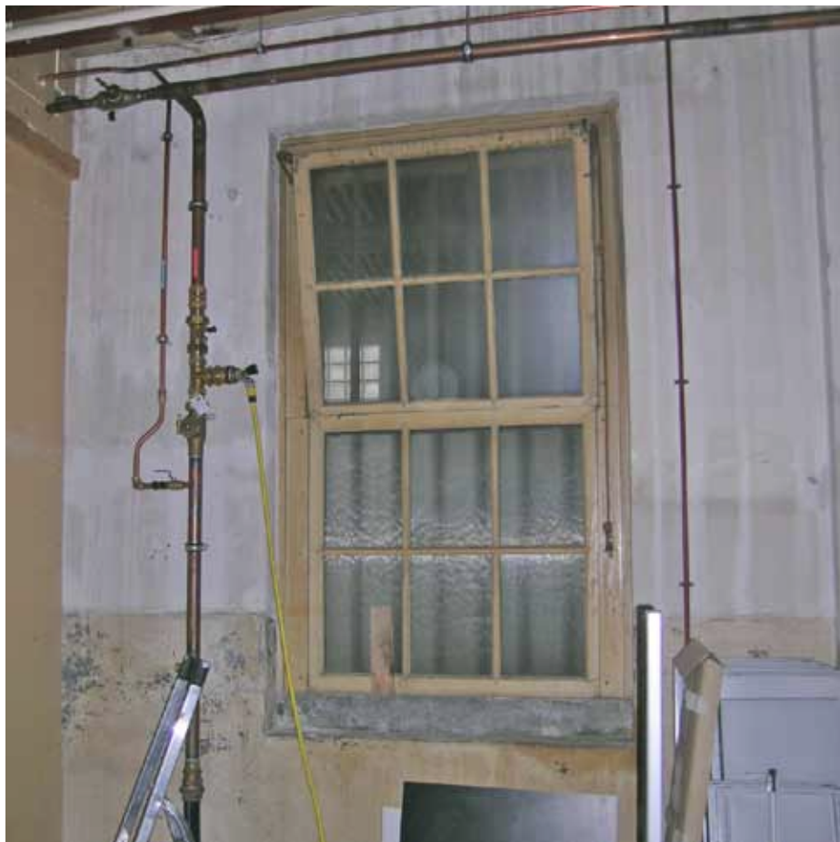
Afbeelding 54. Eén van de vensters in de achtergevel (zuidzijde) van ruimte F0.17. De mogelijk uit de bouwtijd stammende (1822) schuiframen werden gewijzigd in kleppende boven- en vaste onderramen (vermoedelijk 1906) en bezitten een gecementeerde onderdorpel.
