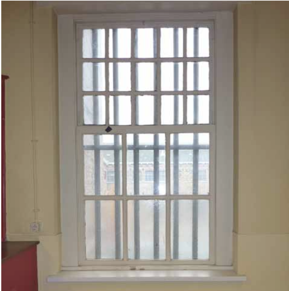
Afbeelding 100. Detail van het meest oostelijke venster. Het onderraam werd later vervangen.
