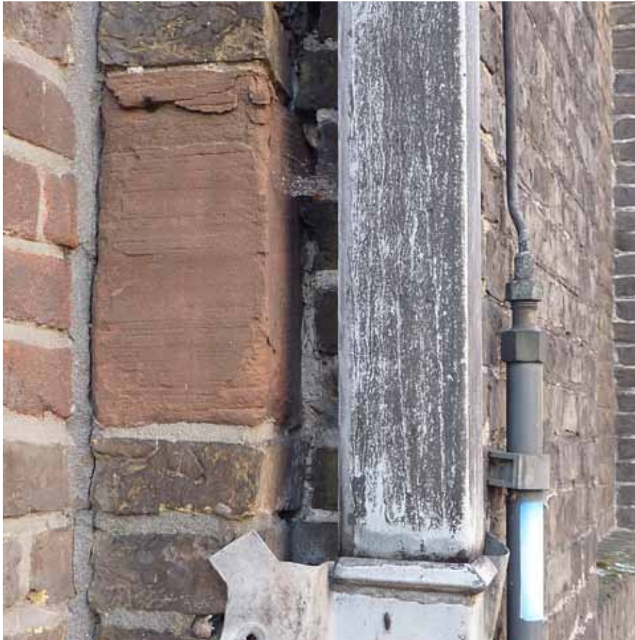
Afbeelding 40. Detail van de aansluiting van de linker zijgevel op de voorgevel. De zijgevel van bouwdeel E werd in 1875 in de gehandhaafde voorgevel van Bouwdeel A ingekast.
