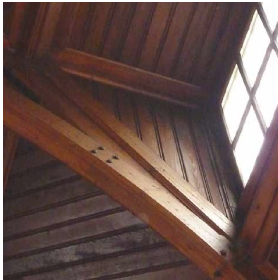
Afbeelding 85. Detail van één van de twee middelste dakkapellen met verzorgd gedetailleerd houtwerk en kraaldelen (1906).
