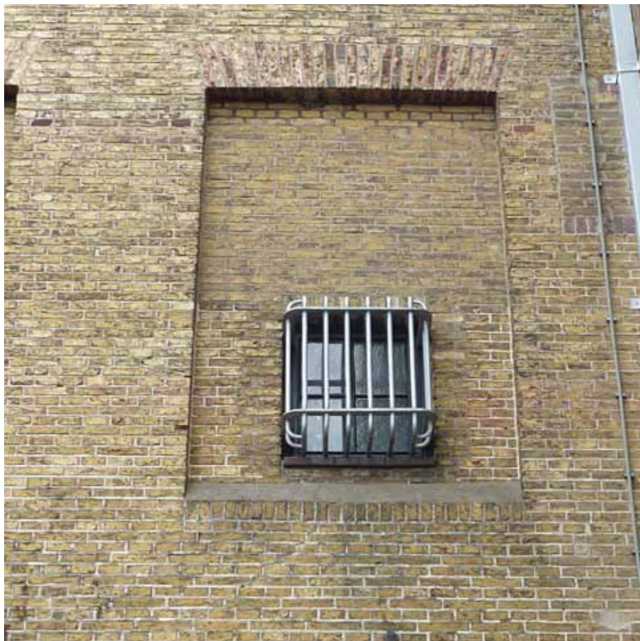
Afbeelding 20. Rechter zijgevel ter hoogte van de eerste verdieping. Het ijzeren vierruits venster dateert van de verbouwing uit 1959, terwijl de tralies recent zijn (1988-1991). Rechtsboven is de dichtzetting van een klein bovenlicht zichtbaar (zie Afbeelding 19).
