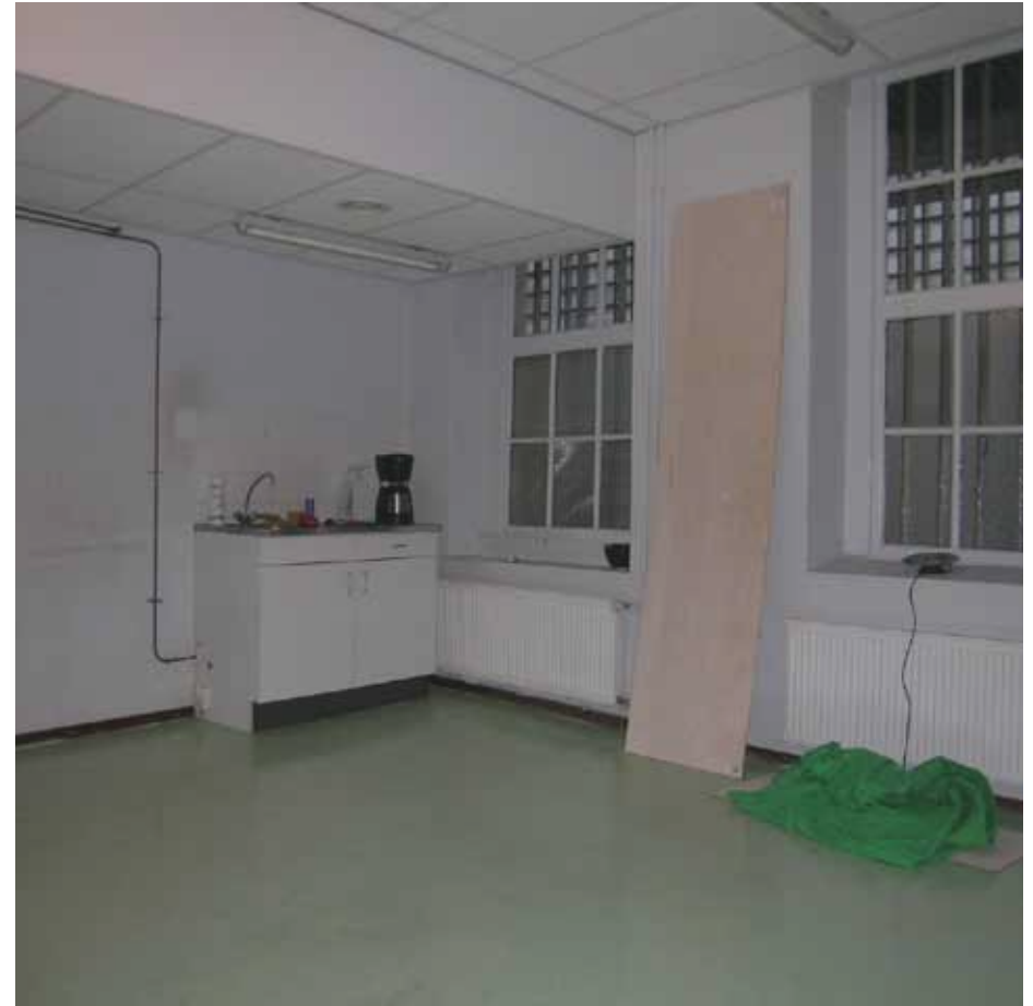
Afbeelding 64. Overzicht van ruimte F0.10 gezien richting het oosten. De ruimte werd in 1981 en 1988 verbouwd, waarbij de huidige vloer- en wandafwerkingen werden aangebracht.
