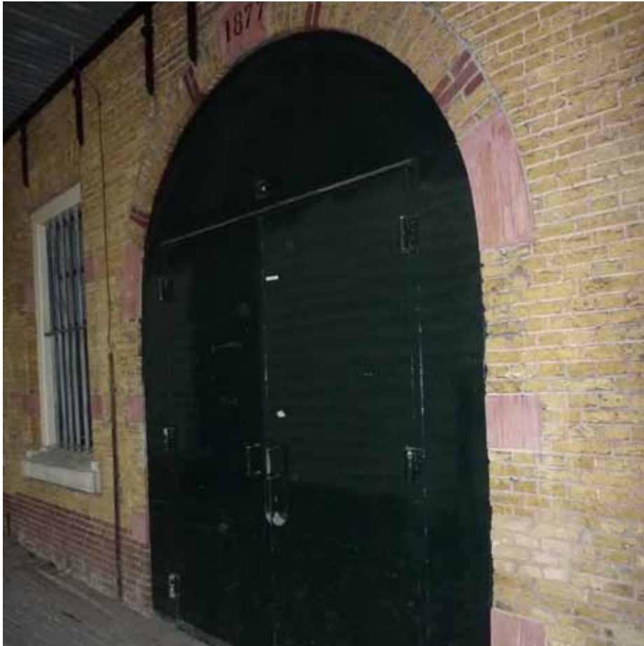
Afbeelding 28. Detail van de achtergevel ter hoogte van de begane grond. De sluitsteen boven poortdeuren draagt het jaartal '1877'. De poort met bijbehorende boog werd in 1877 secundair aangebracht in de oude binnenplaatsgevel.
