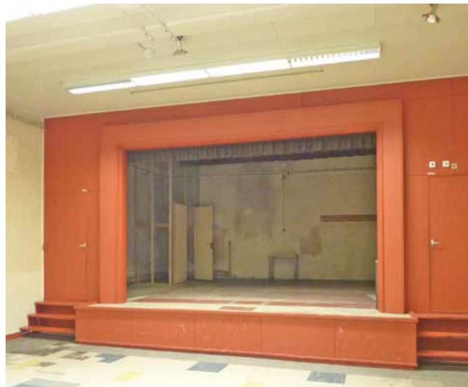
Afbeelding 93. Overzicht van de recreatiezaal E1.11 met het podium aan de oostzijde. Het podium is rondom afgewerkt met geperforeerde boardplaten.
