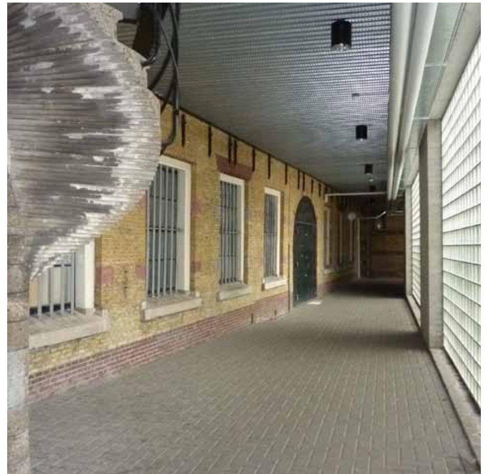
Afbeelding 23. De achtergevel ter hoogte van de begane grond. De gang aan de binnenplaats werd in 1991 gerealiseerd. Boven het tweede venster links van de poort is een afwijkende strek aanwezig (zie Afbeelding 26).
