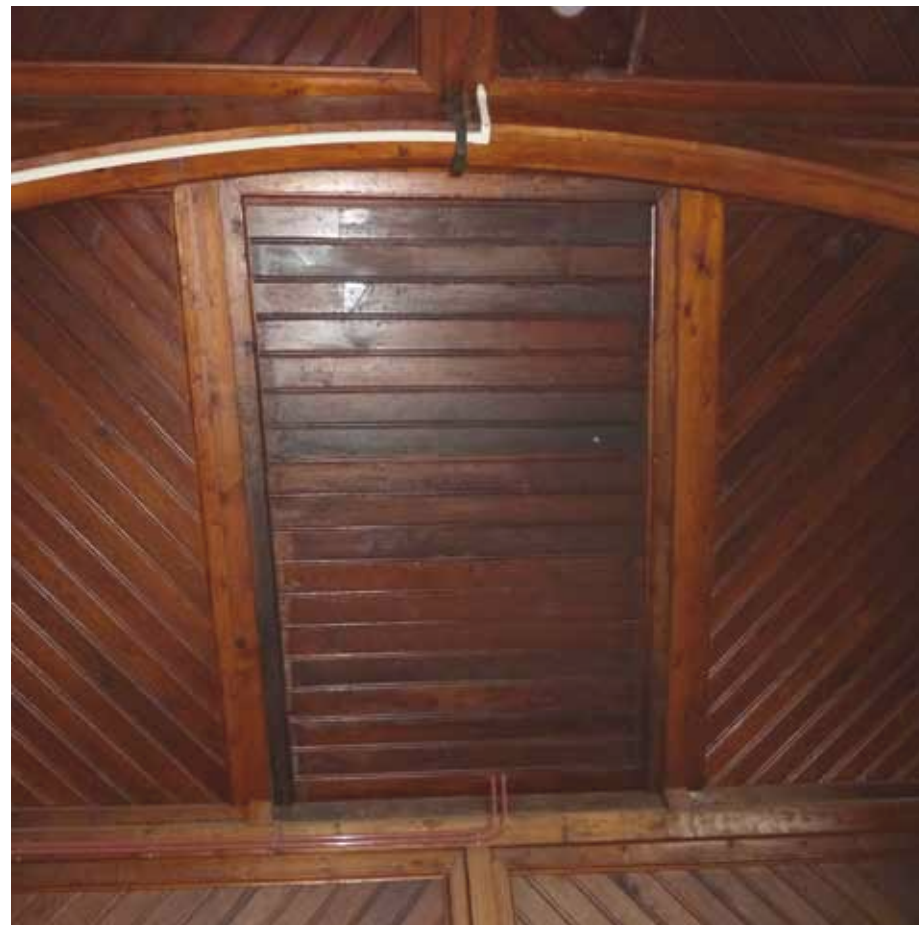
Afbeelding 83. Zicht op het plafond van de zoldering van de kerk met een secundaire opvulling van een plafondlicht.
