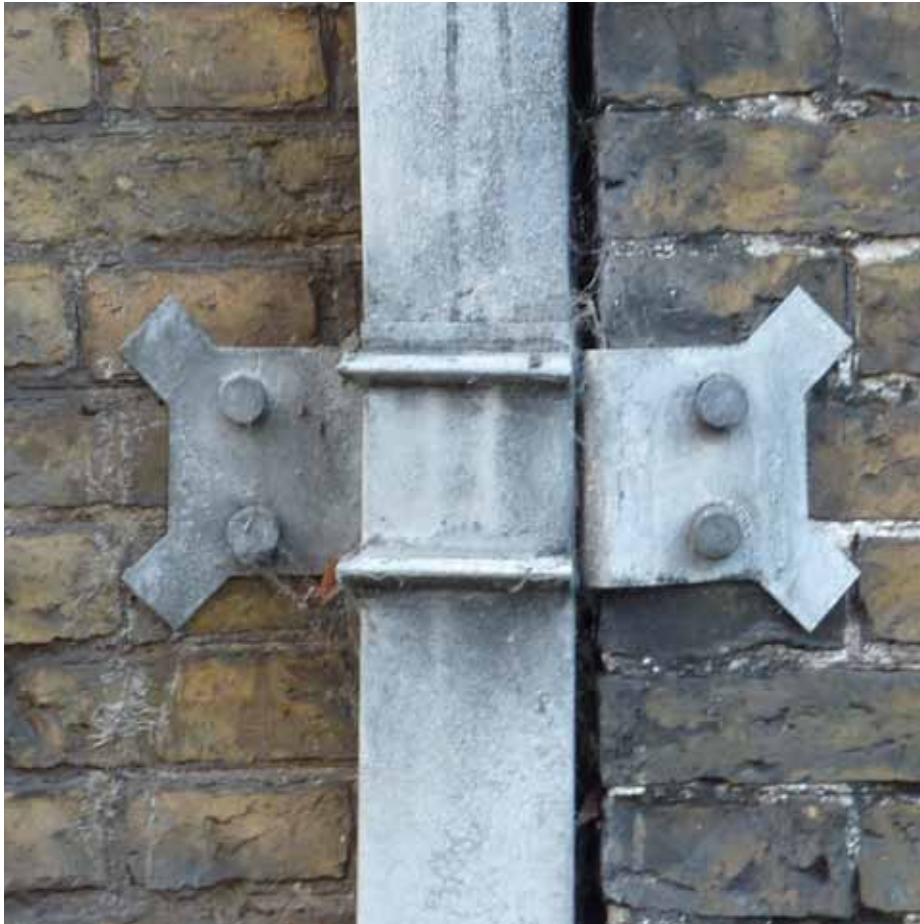
Afbeelding 12. Hemelwaterafvoer links van de middenrisaliet. De rechthoekige hemelwaterafvoer (1877) is bevestigd door middel van zinken bevestigingsbeugels met kraal.
