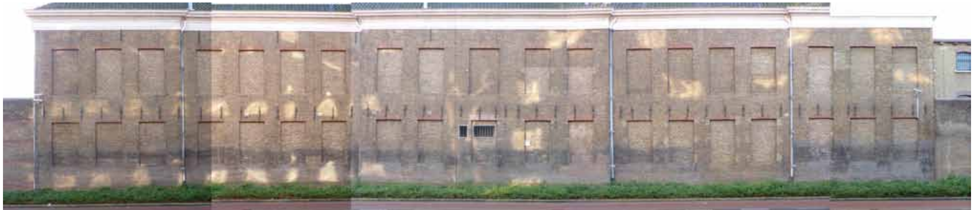
Afbeelding 6. Overzicht van de voorgevel van Bouwdeel A. Ter plaatse van de linker hoekrisaliet ligt de balklaag evenwijdig aan de gevel, maar de gevelankers liggen hier op dezelfde afstand van elkaar als in het rechter deel van de gevel. Het linker gedeelte bezit ter hoogte van de zoldervloer een vijftal ankers, behorende bij de achterliggende betonvloer (1957). De ankers van de zoldervloer van het rechter gedeelte waren verwijderd bij het wijzigen van de kapconstructie van de kerk (1906).
