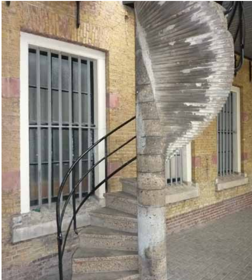
Afbeelding 24. Linkerzijde van de achtergevel ter hoogte van de begane grond met de betonnen trap naar de toegang van de kerk op de eerste verdieping (1959). De trap was oorspronkelijk een buitentrapp en werd 1991 overkapt.
