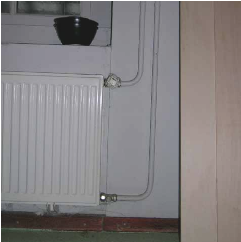
Afbeelding 69. Borstwering onder venster achtergevel (zuidzijde) in ruimte E0.10. De borstwering is vermoedelijk secundair in oudere deuropening geplaatst.
