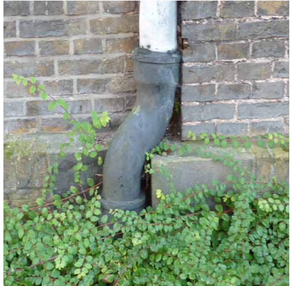
Afbeelding 13. Hemelwaterafvoer links van de middenrisaliet. Aan de onderzijde sluit de afvoer aan op een gietijzeren ronde buis. In de plint zijn op de hoeken hardstenen blokken opgenomen.
