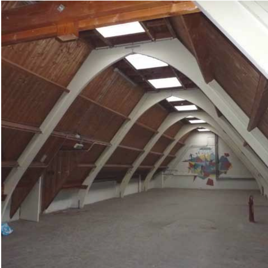
Afbeelding 113. Zicht in de zolderruimte E2.02 met de afgeronde spanten van de sportzaal (1959).
