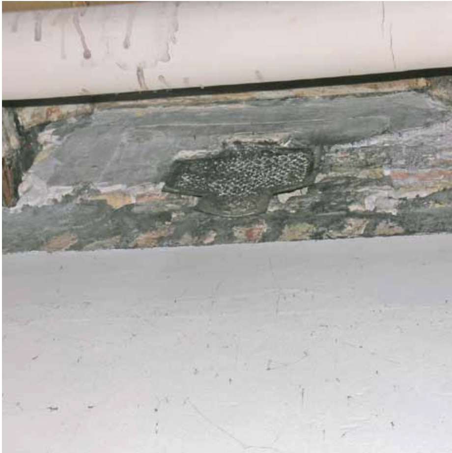
Afbeelding 57. Detail van de oplegging van de enkelvoudige balklaag in de voorgevel (noorden) in ruimte F0.17. Net boven het huidige pleisterwerk zijn stroomlagen in het metselwerk zichtbaar, behorende bij de dichtzettingen van de vensters. Daarboven zijn oudere pleisterlagen aanwezig, die aansluiten op de balken en bovenliggende vloerdelen. Per drie velden is een gietijzeren ventilatieroostertje aangebracht (vermoedelijk 1877).
