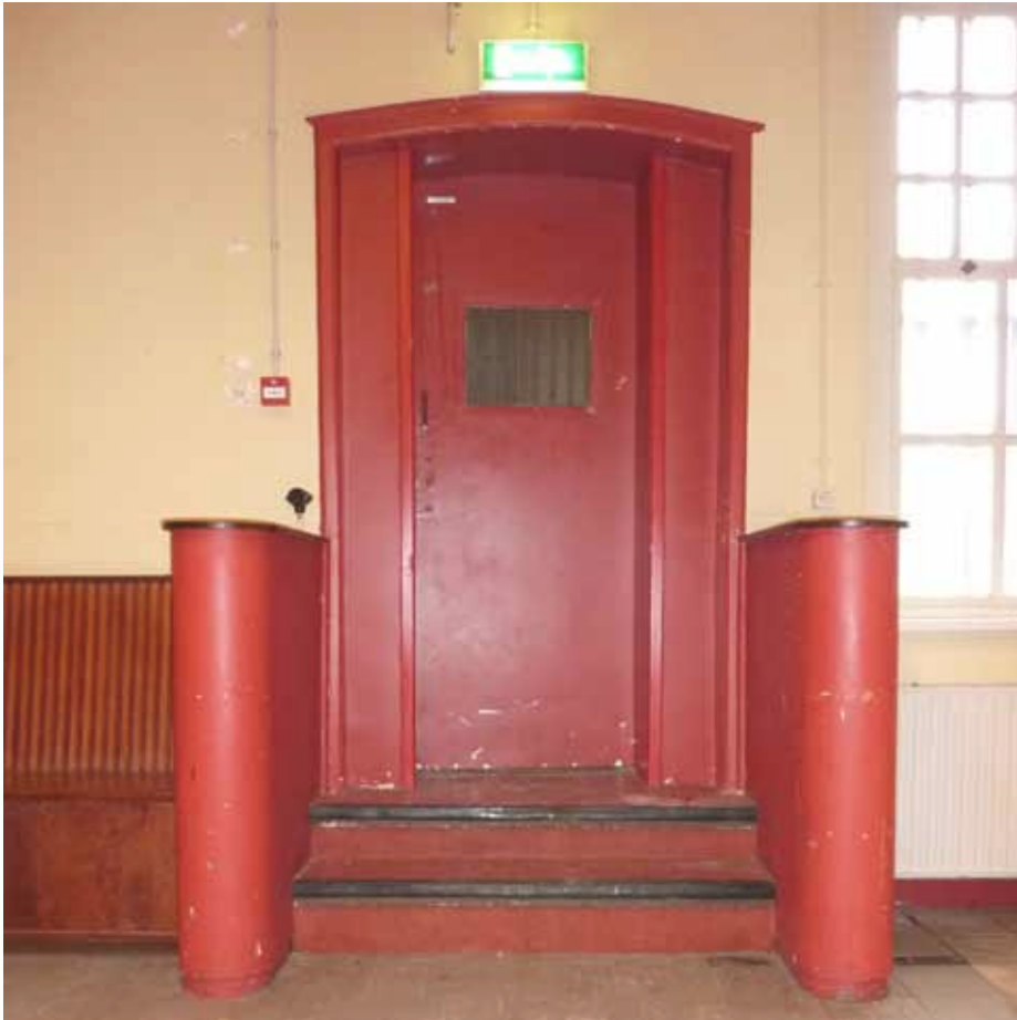
Afbeelding 96. Detail van de deur naar de traptoren in bouwdeel E. De getoogde deur dateert uit de bouwtijd van bouwdeel E (1875), doch werd in 1959 aangepast en voorzien van de afgeronde zijwangen.
