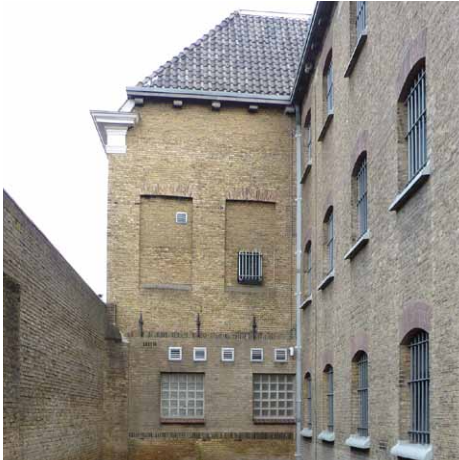
Afbeelding 18. Overzicht van de rechter zijgevel van Bouwdeel A. De vensters werden in 1959 gedicht. Het onderste deel van de rechter zijgevel vormt de buitenzijde van de isoleercellen (1951).
