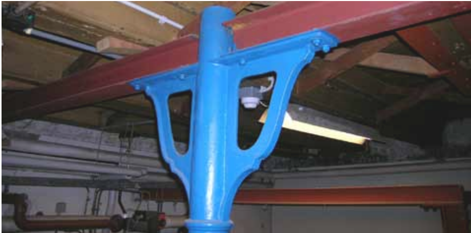
Afbeelding 51. Bovenzijde van één van de kolommen in ruimte F0.17. De hergebruikte gietijzen kolommen zijn samen met de ongeschaafd vurenhouten scheggen en andreaskruizen in 1988 ingebracht ter versterking van de balklaag (gelijktijdig met het aanbrengen van de betonnen zoldervloer).
