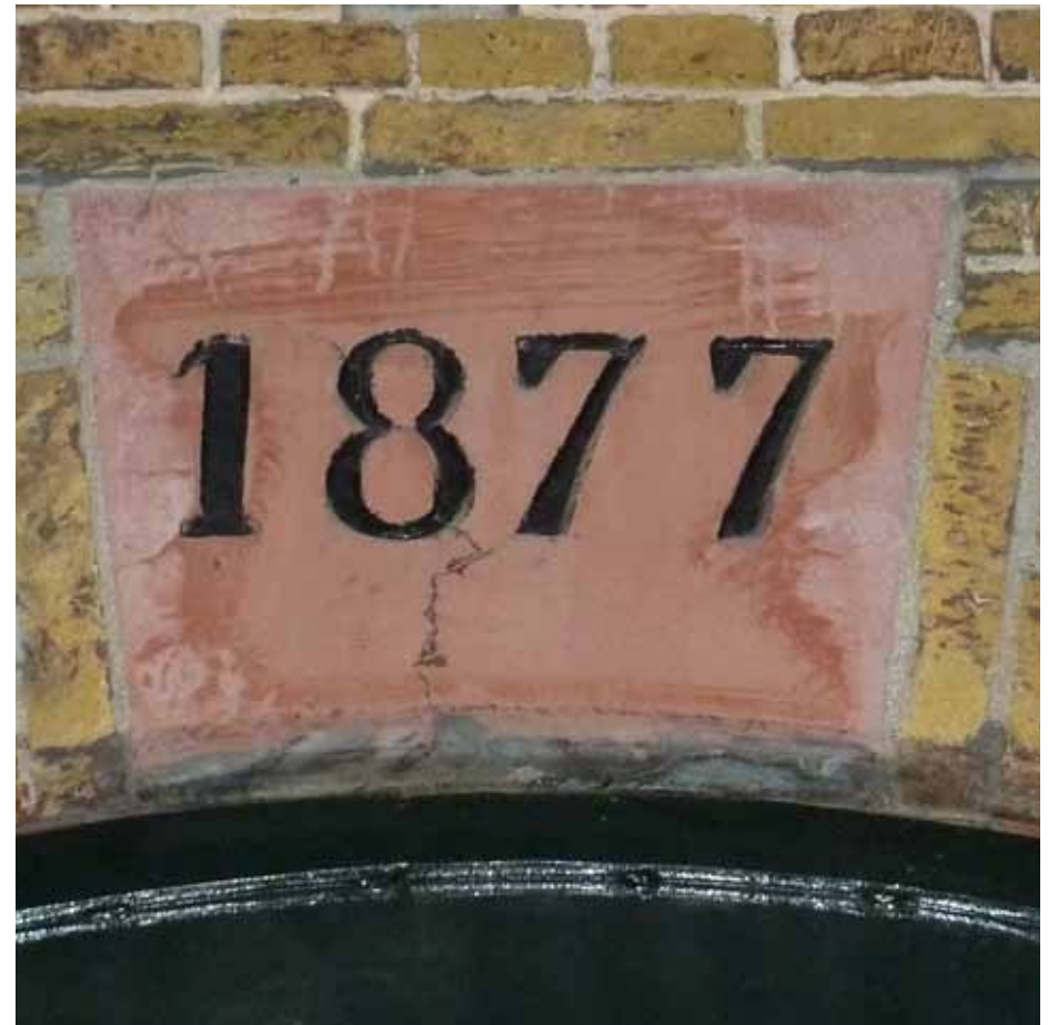
Afbeelding 29. Detail van de voorgaande afbeelding. De Udelfanger zandstenen sluitsteen is evenals het aangrenzende metselwerk van de boog gemetseld en gevoegd in portlandcement en wijkt daarmee af van het kalkvoegwerk van de oorspronkelijke binnenplaatsgevel uit 1822.
