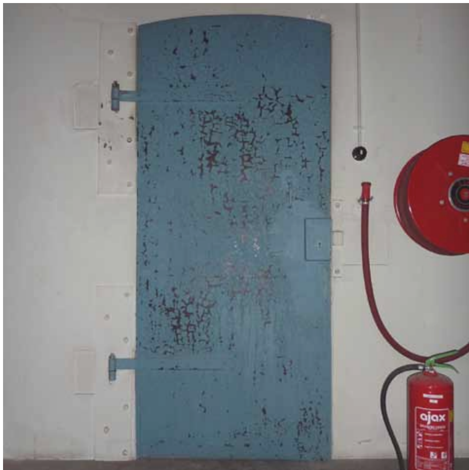
Afbeelding 119. Detail van de plaatstalen deur naar de zolder van bouwdeel E (1875).
