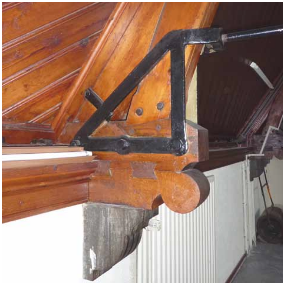
Afbeelding 84. Detail van de oplegging van de spanten met hardstenen consoles en fors gedimensioneerde peerkraalsleutelstukken (1906).
