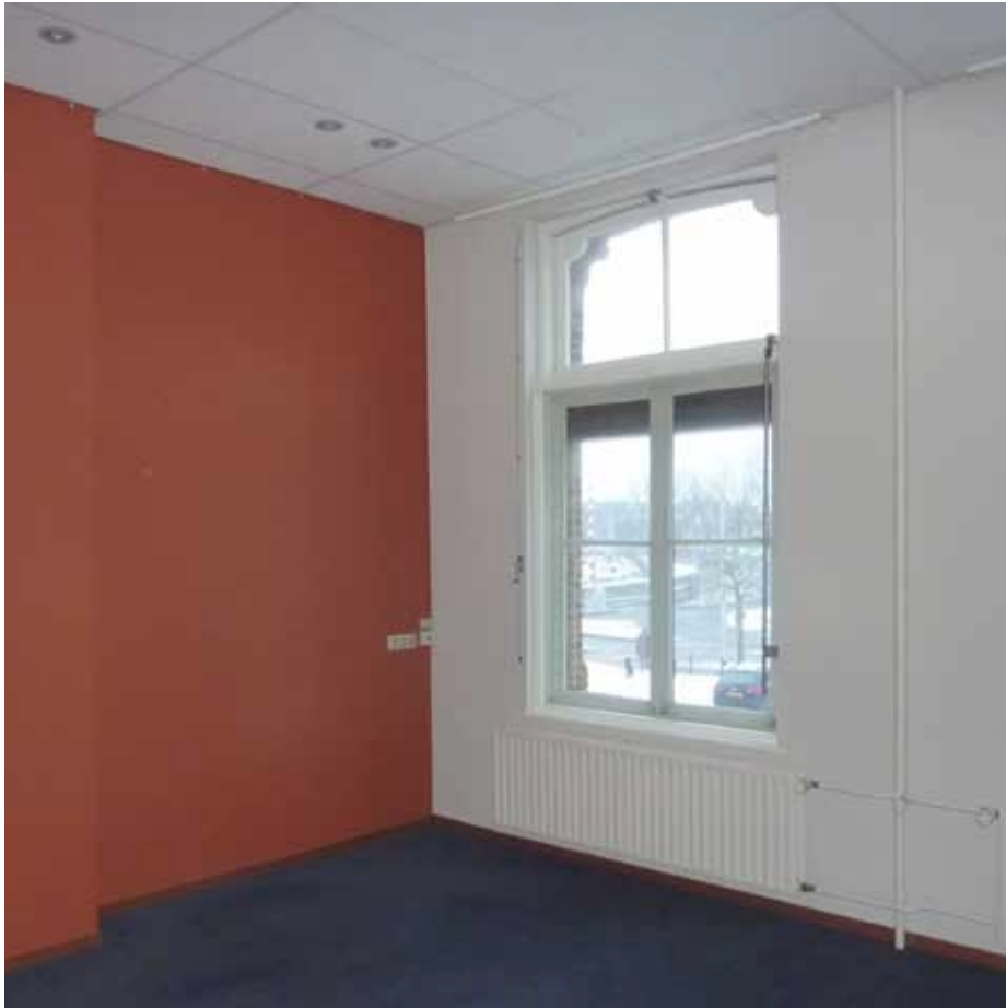
Afbeelding 68. Overzicht van ruimte L1.07 gezien richting het zuidwesten.
