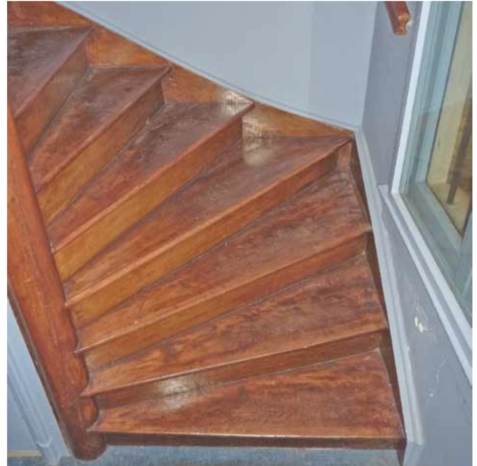
Afbeelding 42. Overzicht van ruimte M0.01 gezien richting het zuiden met de uit de bouwtijd daterende wenteltrap (1870).
