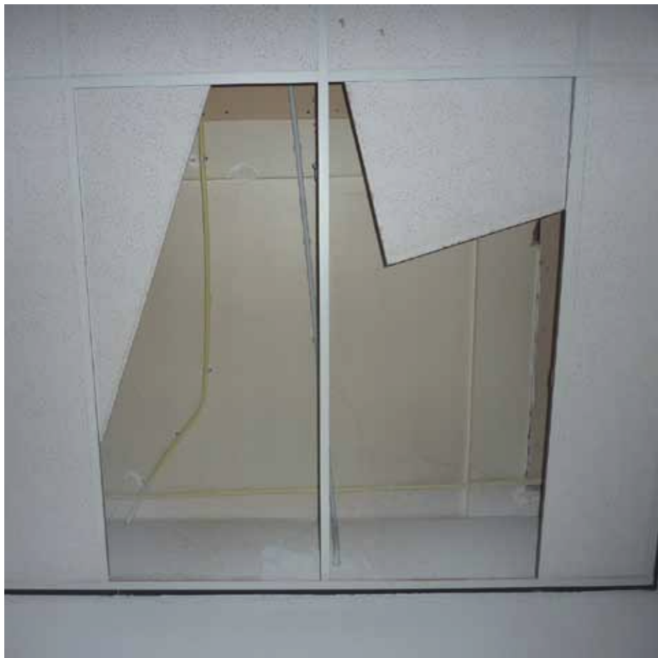
Afbeelding 75. Detail van het stucplafond boven het verlaagde plafond van de technische ruimte L1.04. De plafondplint rechts markeert een oudere scheidingwand.
