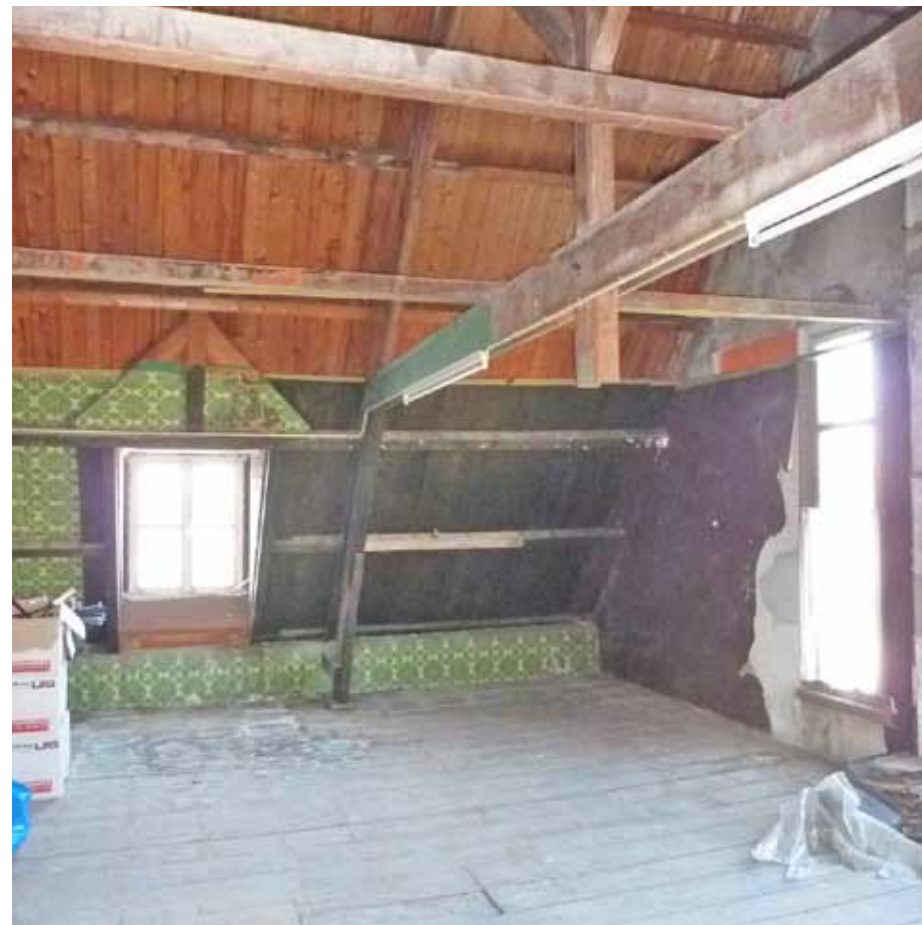
Afbeelding 83. Overzicht van ruimte M2.02 gezien richting het westen. Tegen het dakbeschot tekenen zich nog oudere zolderkamertjes af middels het behang.
