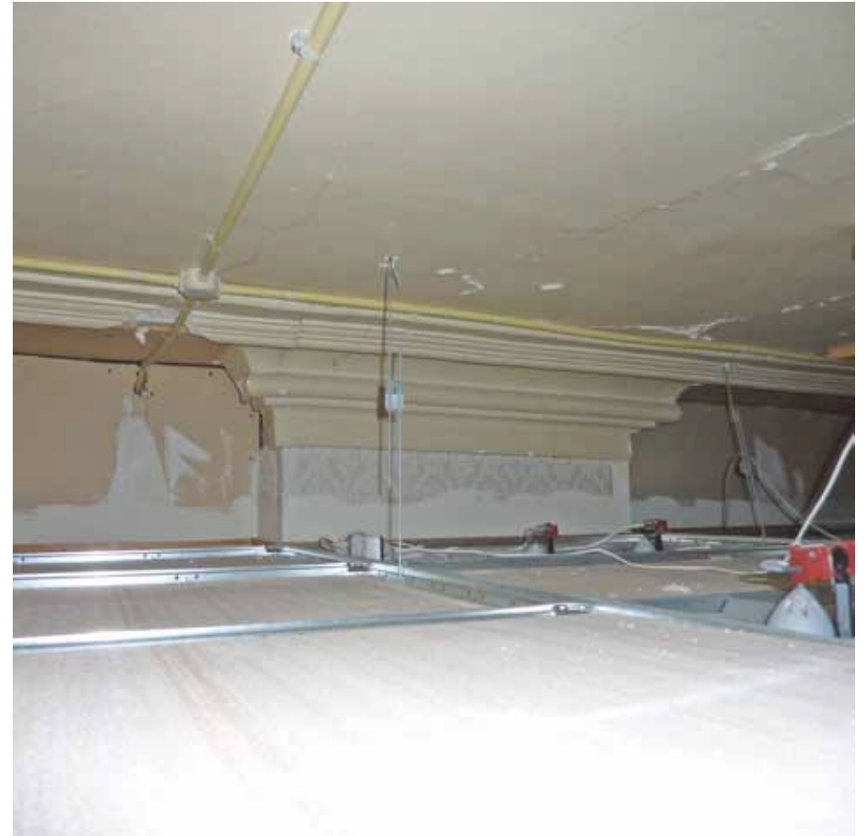
Afbeelding 69. Zicht boven het verlaagde plafond in ruimte L1.07. De ruimte - oorspronkelijk één van de slaapkamers van de kommandantswoning - bezit nog het uit de bouwtijd daterende stucplafond met geprofileerde lijsten (1870). Tevens is het rookkanaal met bijbehorende kooflijsten behouden.
