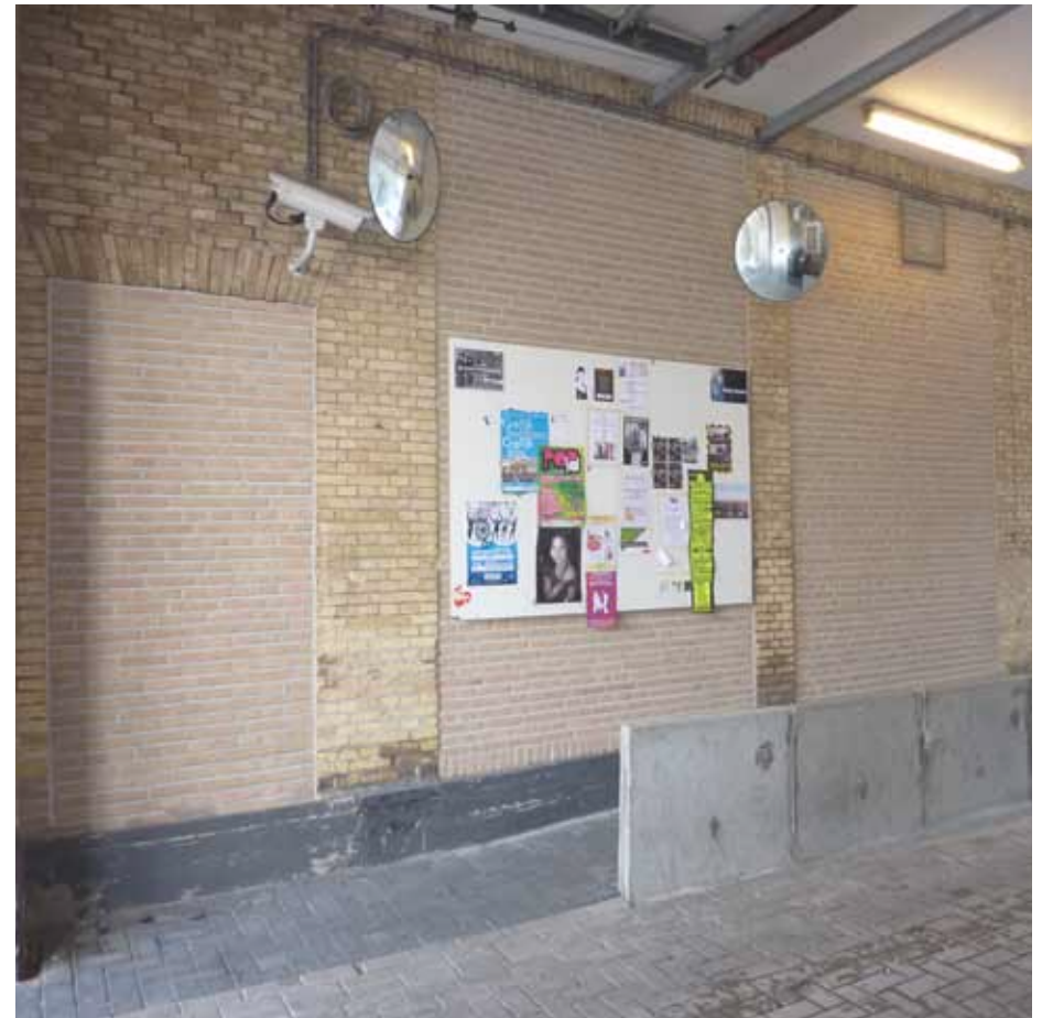
Afbeelding 30. Overzicht van de zuidwand van de eerste poort met de twee grote dichtzettingen van de gevelopeningen van de voormalige Militaire Wacht. Links een dichtzetting van de doorgang naar de voormalige portiersruimte.
