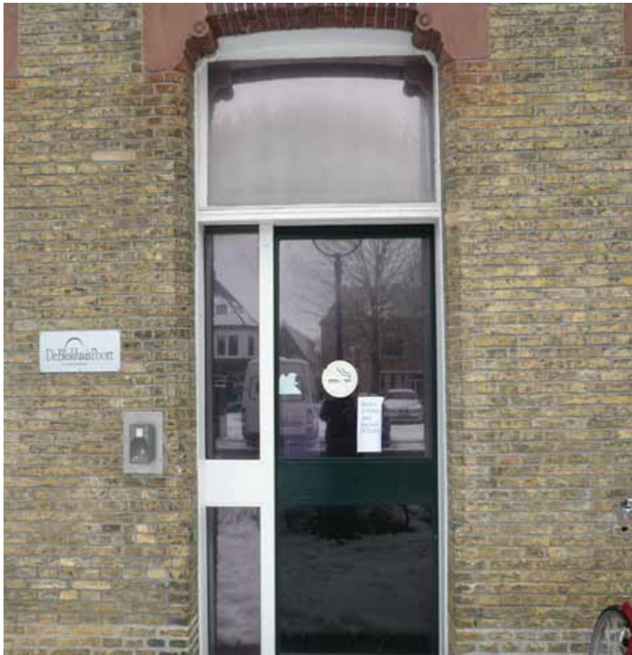
Afbeelding 8. Detail van de deur in het zuidelijke deel van de voorgevel. De doorgang werd in het begin van de 20ste eeuw in een vensteropening aangebracht. De huidige deur met het samengesteld kozijn is recent (1988).
