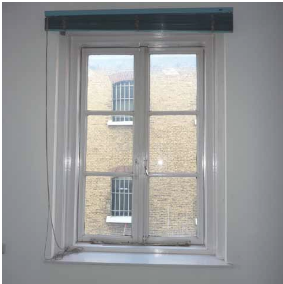
Afbeelding 73. Overzicht van ruimte M1.04 gezien richting het noorden.
