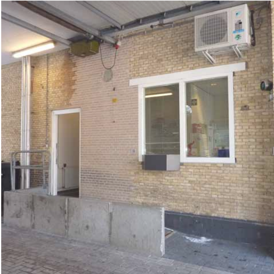
Afbeelding 31. Overzicht van de zuidwand van de 1e poort. De dichtzetting betreft de oorspronkelijke entree van de kommandantswoning (1870). De huidige deur en het tweelicht werden ten behoeve van de nieuwe portiersloge in 1988 ingebracht.
