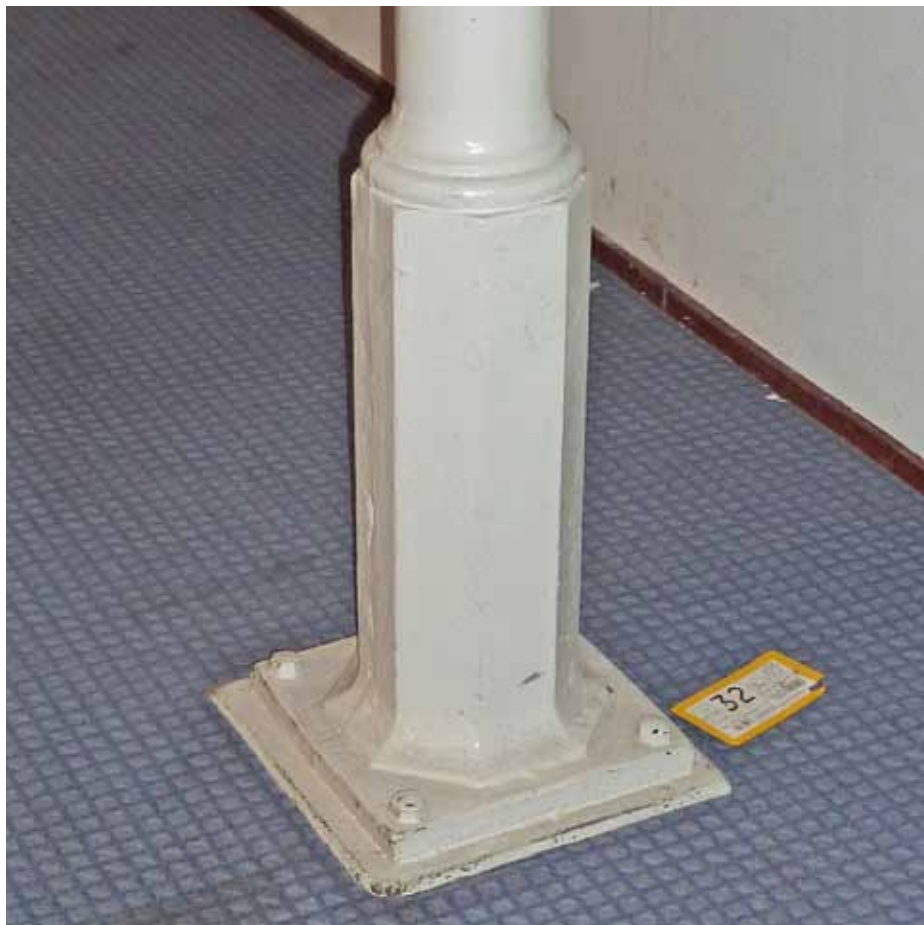
Afbeelding 34. Detail van de vorige afbeelding met de gietijzeren kolom. De kolom bezit een voetplaat van 30 x 30 cm en is geplaatst op een hardstenen poer van 35 x 35 cm.
