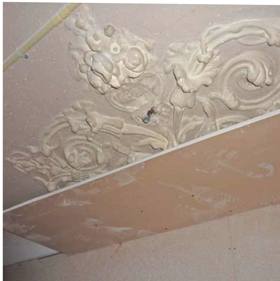
Afbeelding 66. Zicht boven het verlaagde plafond in ruimte M1.06. De ruimte - oorspronkelijk een deel van de regentenkamer boven de poort - bezit nog het uit de bouwtijd daterende stucplafond met geprofileerde lijsten en rijk middenornament (1870).
