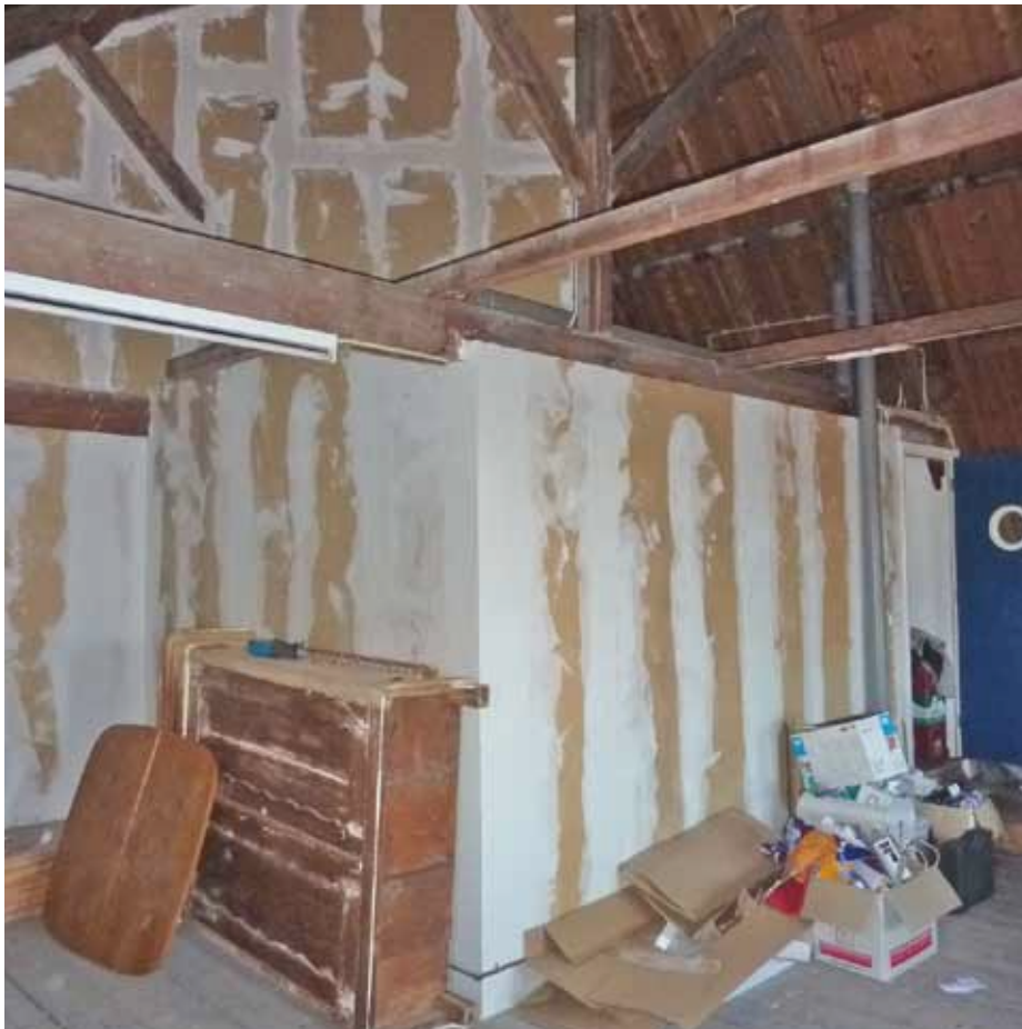
Afbeelding 84. Overzicht van ruimte M2.02 gezien richting het zuidwesten. Hier is de met gipsplaten beklede uitbouw van de aangrenzende pantry en wc zichtbaar.
