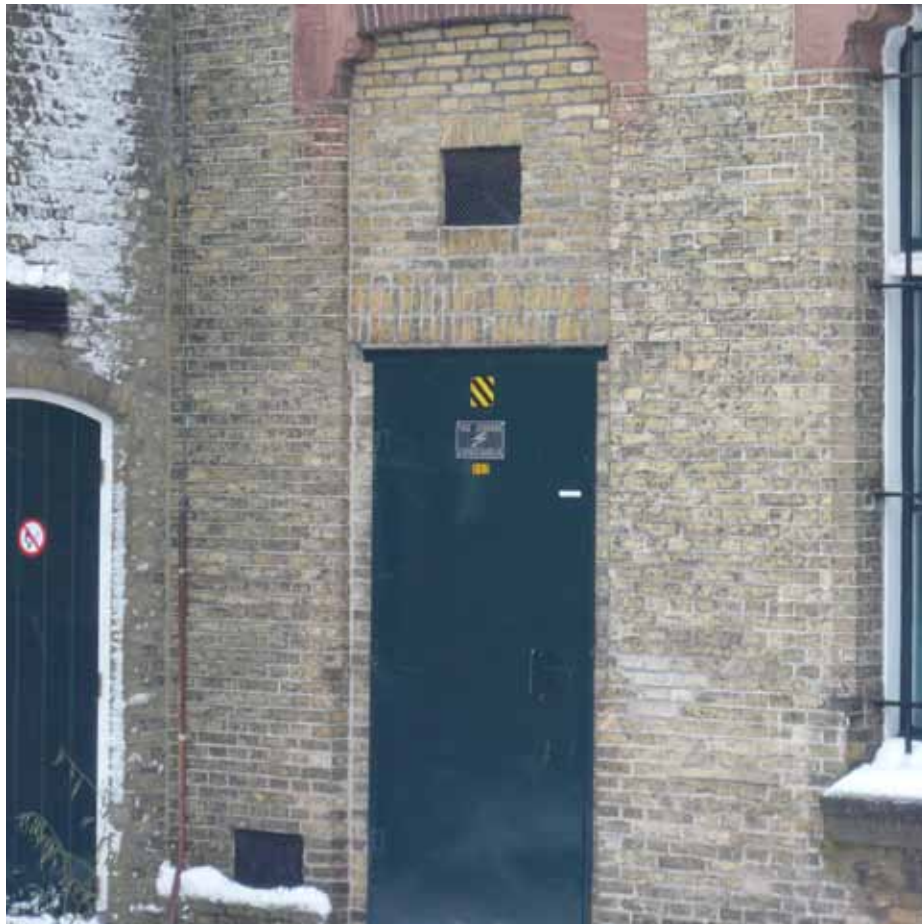
Afbeelding 6. Detail van de eervorige afbeelding met de vermoedelijk omstreeks 1948 aangebrachte traforuimte en bijbehorende stalen deur in de voor-gevel.
