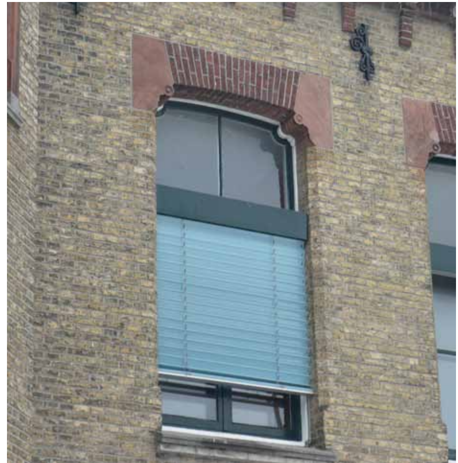
Afbeelding 9. Detail van één van de vensters met de zonwering uit 1988. De vensters zijn voorzien van zeer slanke uit de bouwtijd daterende kozijnen (1870) en waren oorspronkelijk voorzien van schuiframen. De huidige stolpramen dateren vermoedelijk uit 1948.
