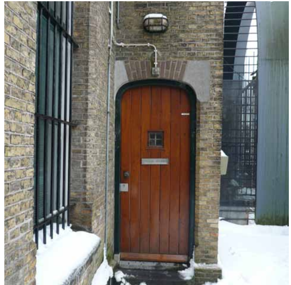
Afbeelding 7. Zicht op de linker zijde van de noordelijke traptoren met de getoogde doorgang. De doorgang werd in een latere, vroeg 20ste-eeuwse, fase ingebracht (XXa). De aanzetstenen zijn hier van hardsteen in plaats van de in 1870 toegepaste Udelfanger zandsteen.
