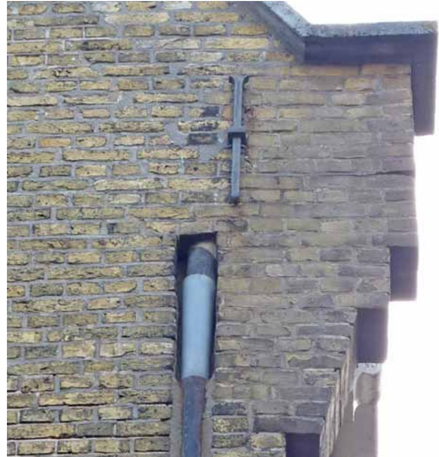
Afbeelding 19. Detail van de vorige afbeelding met het schouderstuk en de hemelwaterafvoer. Het schouderstuk bevat enkele reparaties. De hemelwaterafvoer bestaat nog deels uit de originele gietijzeren afvoerbuizen, die in de gevel zijn opgenomen (1870).
