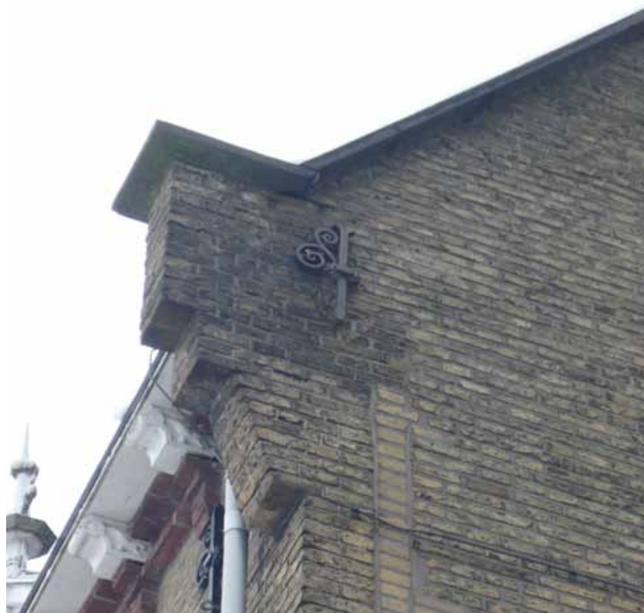
Afbeelding 21. Detail van de vorige afbeelding met een schouderstuk en in-middels dichtgezette voormalige sleuf van de hemelwaterafvoer.
