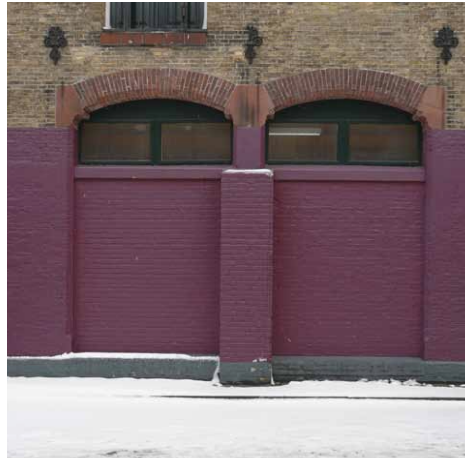
Afbeelding 89. Zicht op de in 1988 dichtgezette openingen met bovenlichten in de binnenplaatsgevel. Opening van deze dichtzettingen, wijziging van de zware muurdam en verwijdering van de verflaag op het omliggende metselwerk zouden de kwaliteit van de architectuur en de eenheid van de bestaande gevel kunnen versterken.
