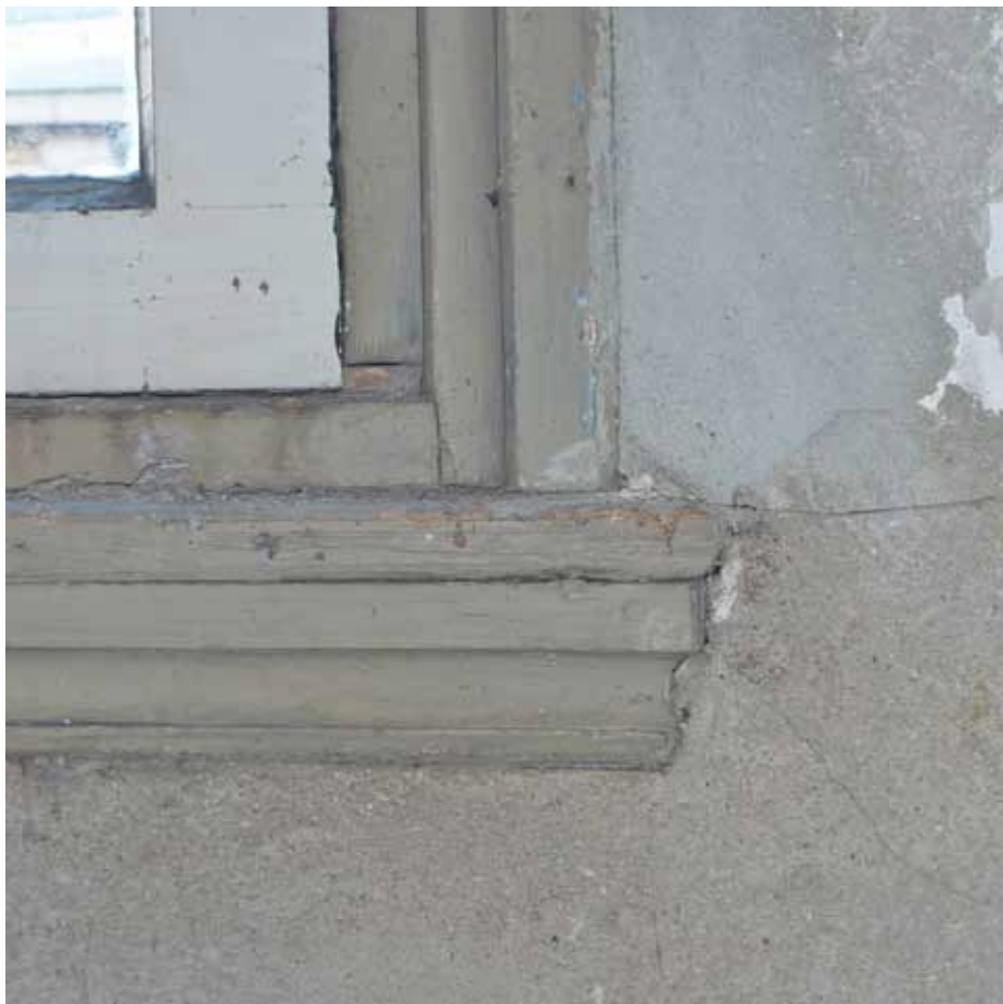
Afbeelding 86. Detail van de uit de bouwtijd daterende vensterbank van het centrale venster in de noordwand van ruimte M2.02 (1870).
