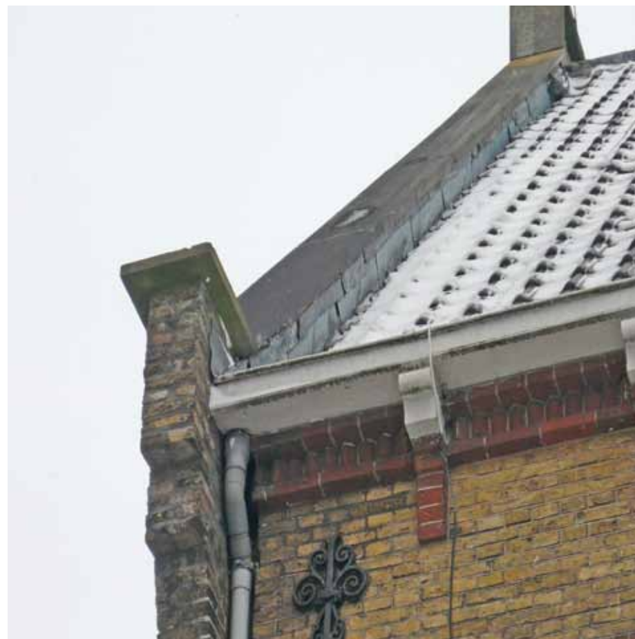
Afbeelding 29. Detail van één van de schouderstukken bij de achtergevel.
