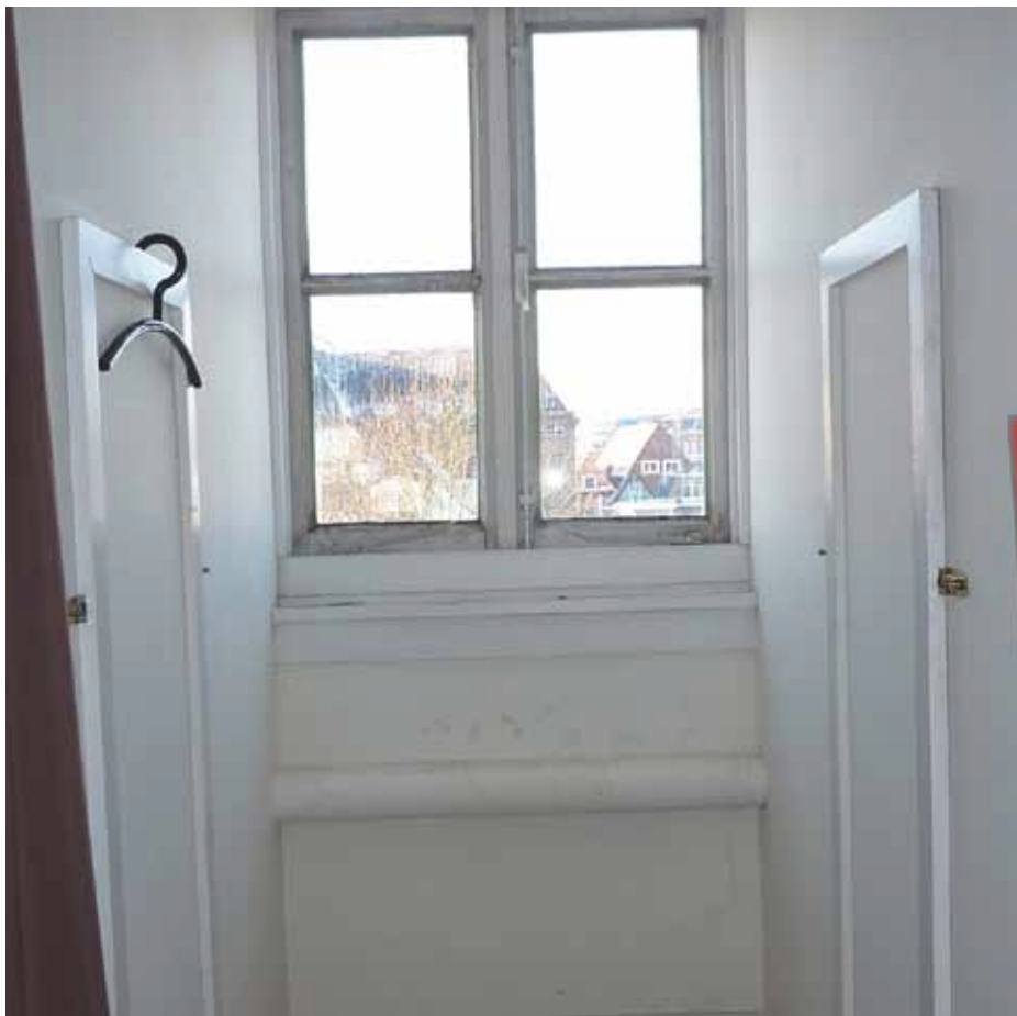
Afbeelding 81. Zicht op de uit de bouwtijd daterende dakkapel aan de oostzijde van ruimte L2.02.
