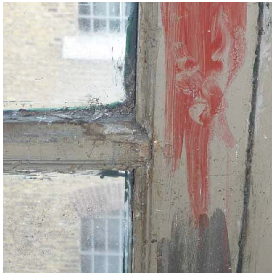
Afbeelding 87. Detail van een uit de bouwtijd daterende geprofileerde vensterroede van één van de zijramen in de noordwand van ruimte M2.02 (1870).
