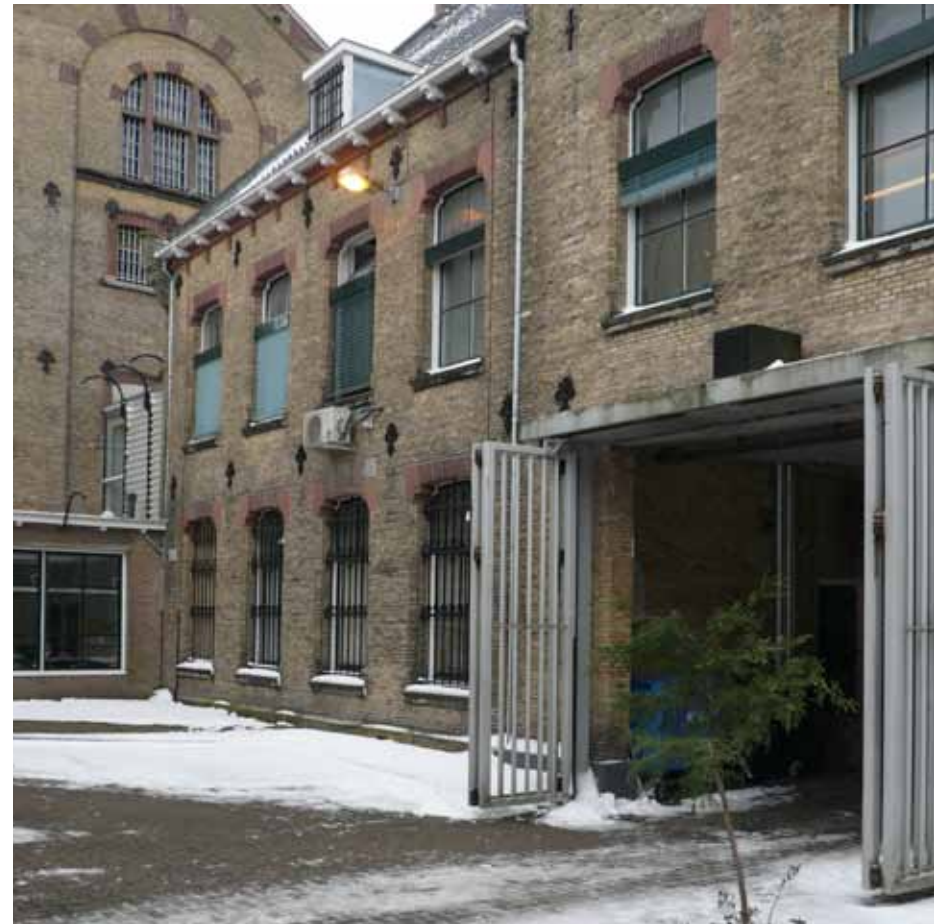
Afbeelding 25. Zicht op de zuidelijke helft van de achtergevel van bouwdeel B.
