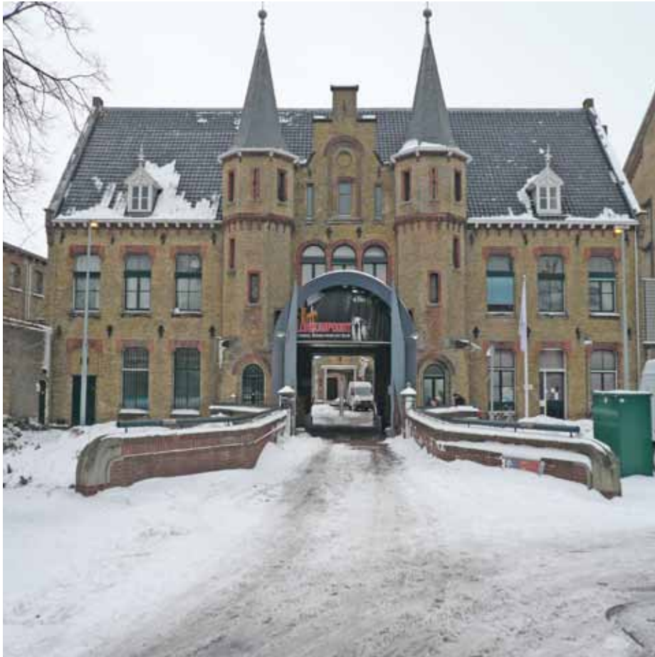
Afbeelding 4. Zicht op de voorgevel van het bouwdeel B. De stalen poort dateert uit de verbouwing van 1988.
