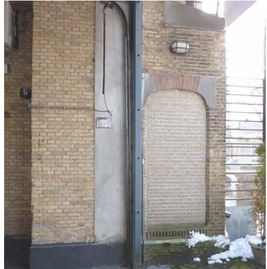
Afbeelding 32. In de zuidelijke traptoren is een dichtzetting van een voormalige entree zichtbaar. De gepleisterde strook markeert de plaats van de muurdammen van de - in 1988 vergrote poort - oorspronkelijke poortdeuren.
