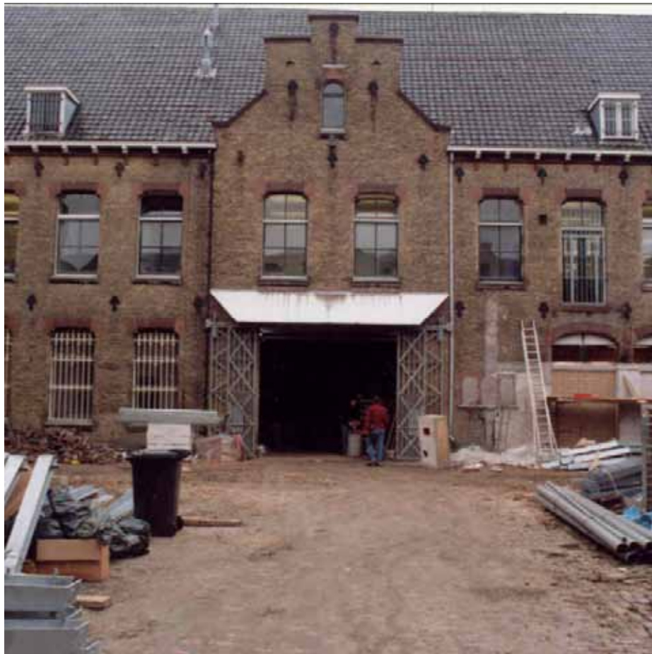
Afbeelding 22. Zicht op de achtergevel tijdens de verbouwing van 1988.
