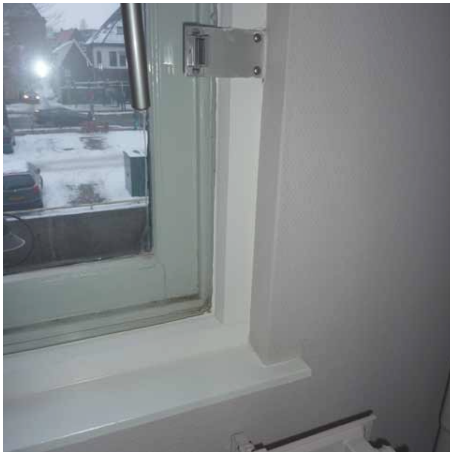
Afbeelding 70. Zicht op één van de vensters in de westwand van ruimte L1.07.
