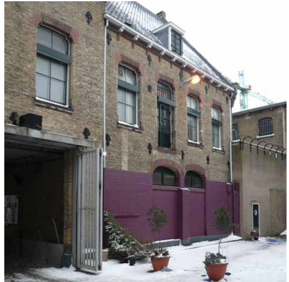
Afbeelding 27. Zicht op de zuidelijke helft van de achtergevel van bouwdeel B na de verbouwing uit 1988. De getoogde doorgangen van de voormalige Militaire Wacht werden als blindnissen weer hersteld.
