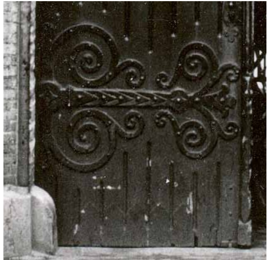
Afbeelding 88. Detail van de oorspronkelijke poortdeuren met rijk bewerkte gesmede gehengen (1870). Deze deuren zijn omstreeks 1988 verwijderd, waardoor het poortgebouw een wezenlijk functioneel onderdeel sindsdien mist.
