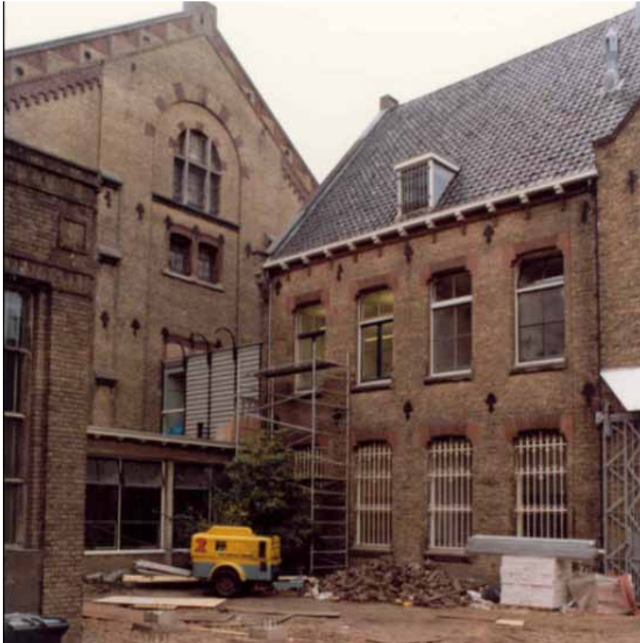
Afbeelding 24. Zicht op de zuidelijke helft van bouwdeel B tijdens de verbouwing van 1988. Tijdens de werkzaamheden werd tevens de eerste verdieping van bouwdeel K aangebracht als tussenlid tussen de bouwdelen B en C.
