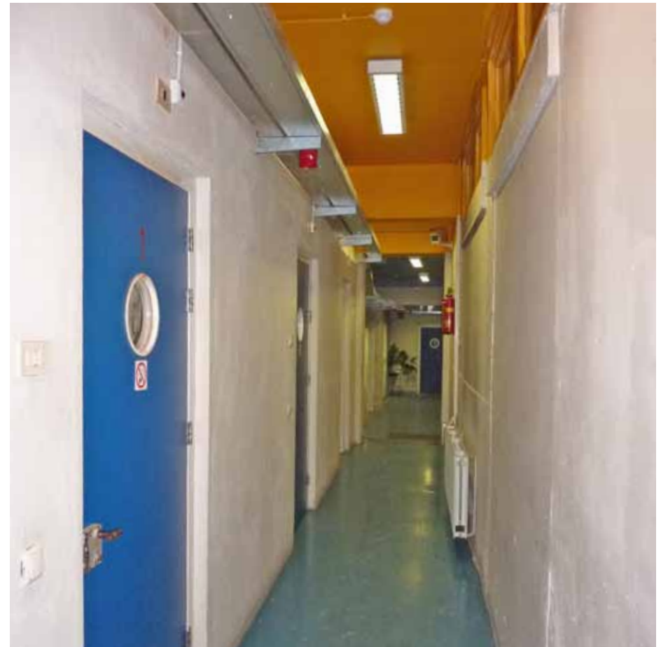
Afbeelding 36. Zicht in de gang naar het noorden. De verdikkingen in het pleisterwerk rechts en de twee hoger geplaatste tweelichten markeren de plaats van de oorspronkelijke gevelopeningen van de Militaire Wacht.
