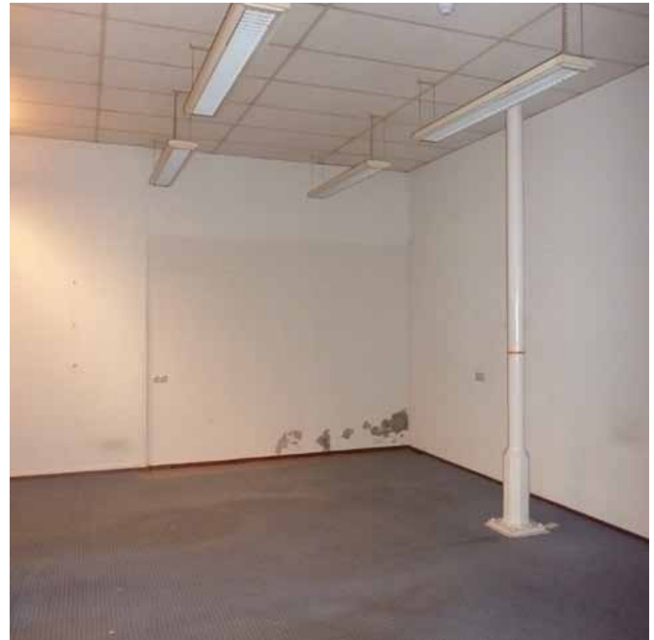
Afbeelding 33. Overzicht van ruimte M0.02 gezien richting het noorden. In de wand markeert een sprong in de gevel de naad tussen de voormalige traforuimte en de aangrenzende verdelerruimte.
