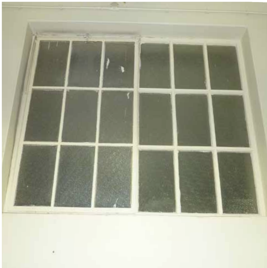
Afbeelding 113. Detail van één van de in de bouwmuren opgenomen ramen in ruimte K2.18. Deze houten roedenramen zijn voorzien van ijzeren draaiende delen en dateren van de verbouwing uit 1946-1948, waarbij de ziekenafdeling gemoderniseerd werd.
