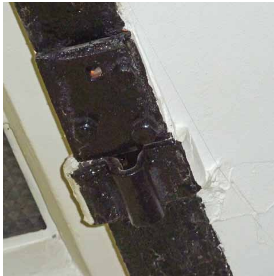
Afbeelding 74. Detail van de onderzijde van één van de ijzeren binten in ruimte K2.18. De functie van de ijzeren klemmen is onbekend. Mogelijk betreffen het bevestigingsklemmen voor de oude gasleidingen van de verlichting.
