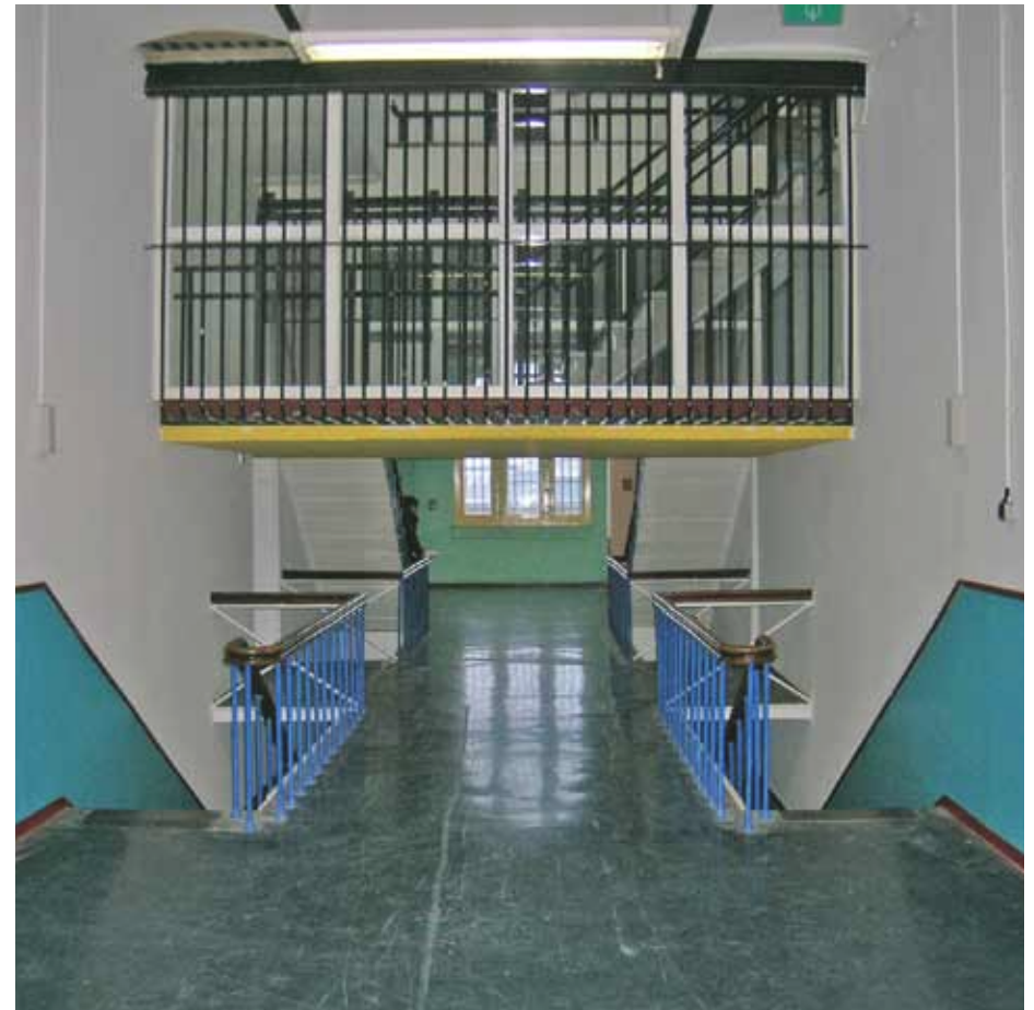
Afbeelding 15. Overzicht van het trappenhuis vanaf de tweede verdieping gezien richting het noorden. Het traliewerk en het hekwerk aan de andere zijde van het tussenbordes dateren van de verbouwing van 1946-1948.
