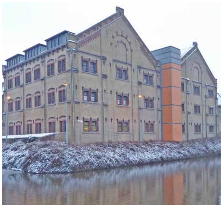
Afbeelding 100. Aanzicht van de in 1997 toegevoegde liftschacht. De liftschacht werd sterk contrasterend vormgegeven in afwijkende materialen en kleuren, waardoor het bouwonderdeel afbreuk doet aan de kwaliteit van de overige 19de-eeuwse architectuur van Metzelaar.
