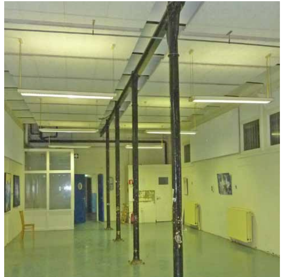
Afbeelding 120. Overzicht van ruimte K1.21 gezien richting het westen. De toiletten - op de foto rechts achterin - werden in 1946-1947 in de slaapzalen gebouwd en werden in 1997 gemoderniseerd. Het kantoortje linksachter stamt uit 1988-1991. De toiletten zijn karakteristiek voor de verbetering van de leefomstandigheden van de gevangenen in de na-oorlogse periode. Conservering van één groep toiletten is wenselijk. De inbouwen uit de perioden 1988-1991 en 1997 bezitten geen monumentwaarde en kunnen verwijderd worden.
