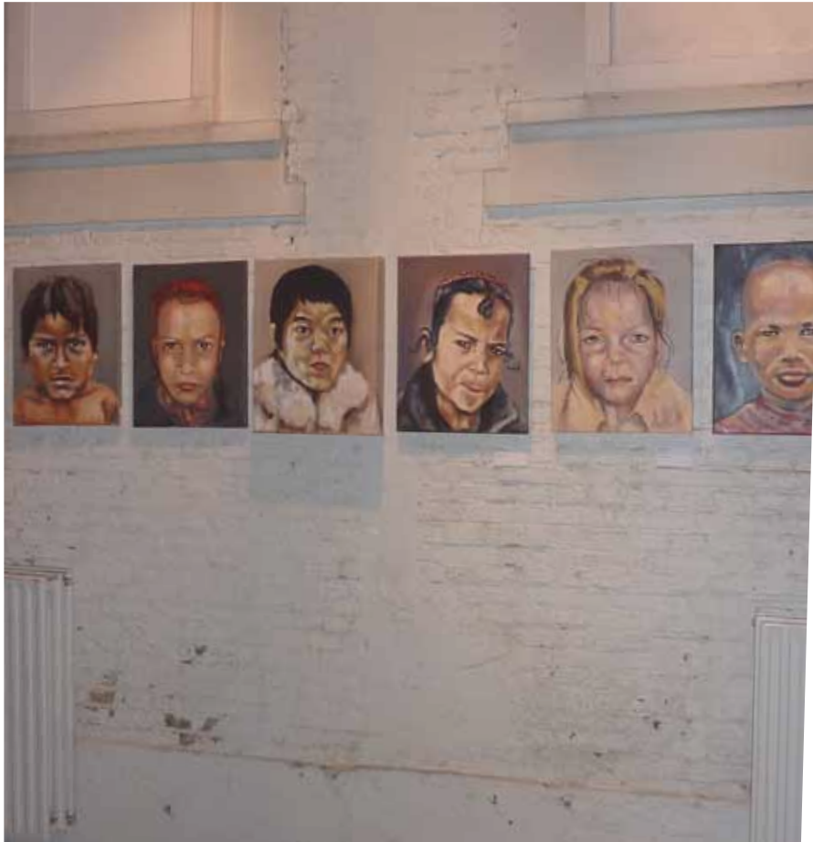
Afbeelding 115. Zicht in werkruimte K0.09 met de muurdam tussen de ramen in de oostgevel. De verticale strook pleisterwerk in het midden markeert de oorspronkelijke plaats van de hardstenen wasbakken en schotten, die deze zaal in twee smallere ruimten opdeelde.
