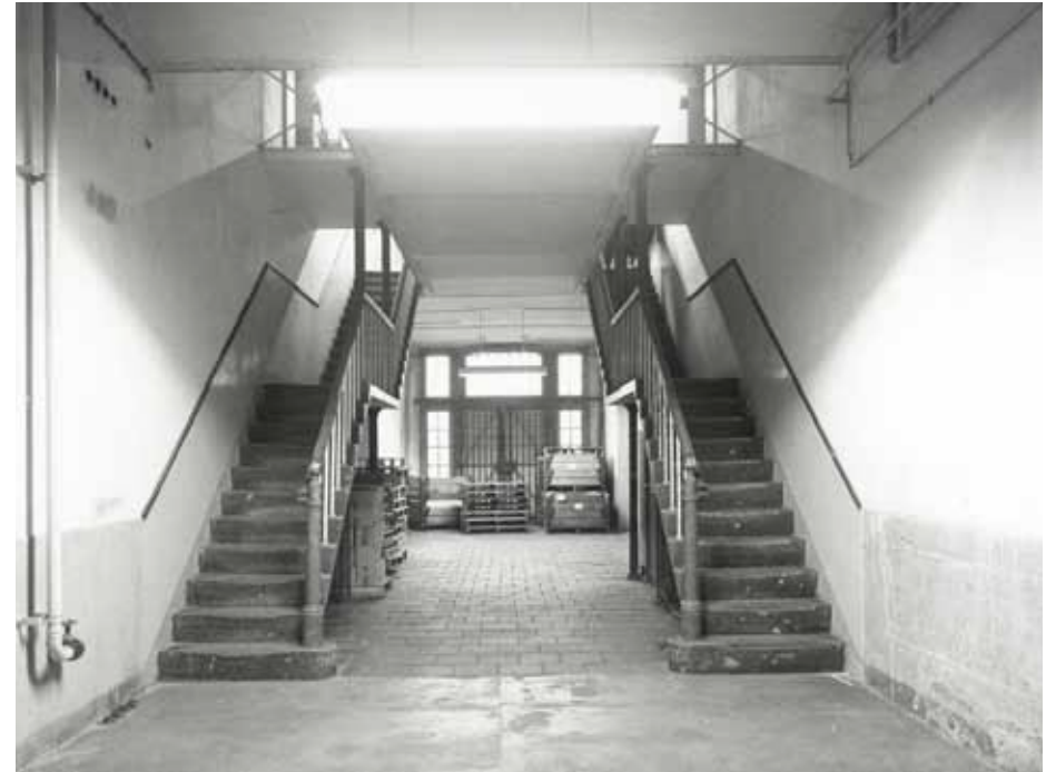
Afbeelding 17. Overzicht van het trappenhuis vanaf de begane grond gezien richting het zuiden in februari 1983. Het trappenhuis is hier zonder hekwerk en nog met de oorspronkelijke uitgang aan de zuidzijde. Vergelijk met Afbeelding 10
