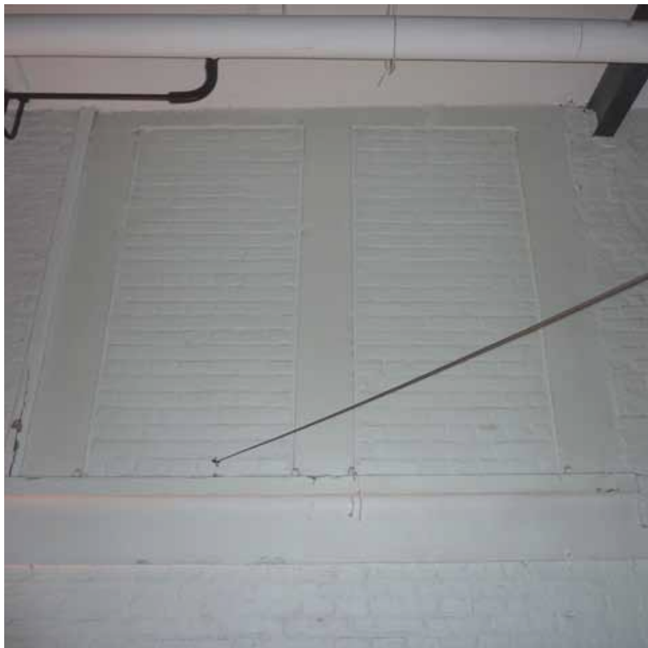
Afbeelding 32. Zicht op één van de dichtgezette vensters in de oostwand van ruimte K0.07.
