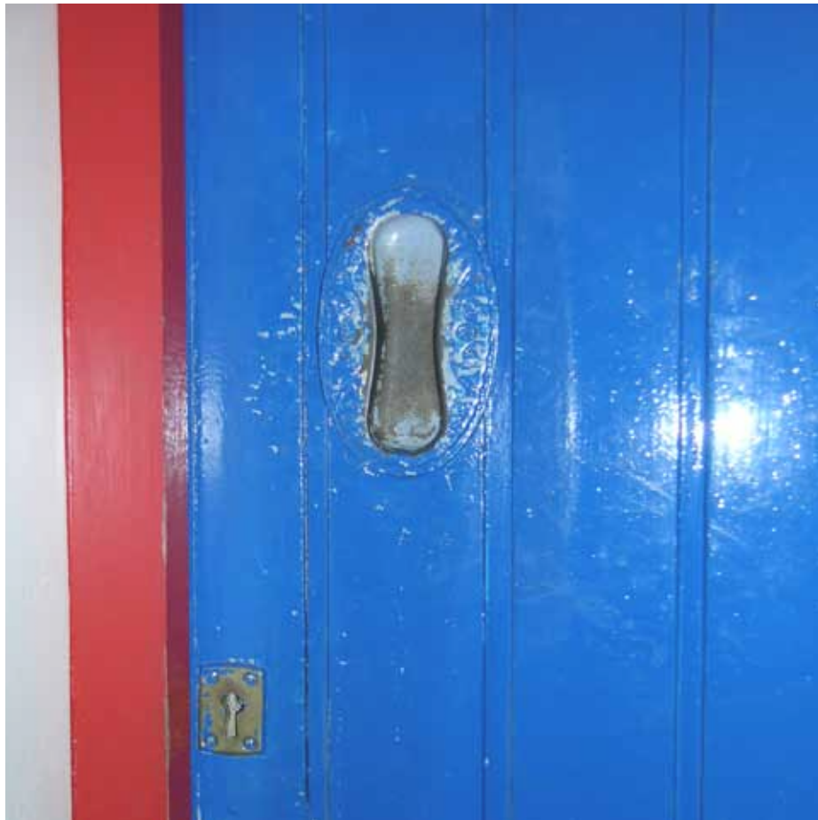
Afbeelding 123. Detail van één van de deurgrepen in de schuifdeuren in het trappenhuis op de begane grond. De deuren en het bijbehorende hang- en sluitwerk dateren van de verbouwing uit 1946-1948.
