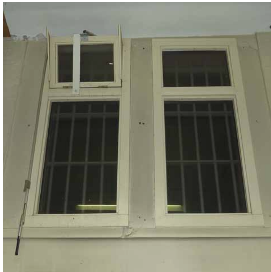
Afbeelding 114. Detail van één van de in 1997 vervangen ramen. Hierbij werden de bestaande ijzeren roedenramen vervangen door de huidige houten vrij grof gedetailleerde exemplaren. Herstel van de ijzeren ramen met 20-ruits roedenverdeling zou de kwaliteit van de interieurs ten goede komen (Afbeelding 118).
