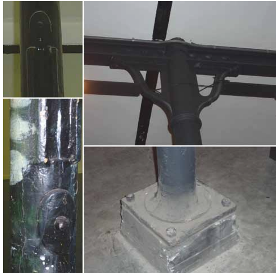
Afbeelding 31. Compilatie van afbeeldingen van één van de kolommen in het bouwdeel. (1870). De kolommen zijn voorzien van strips ten einde eventuele tussenwanden en schotten te kunnen plaatsen. Blijkens de bouwtekeningen waren oorspronkelijk hardstenen platen als afscheidingen in de alkoofruimten aangebracht (1870). Deze indeling was op de begane grond reeds vóór 1894 verdwenen.
