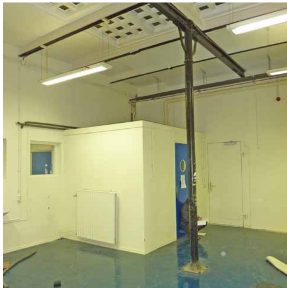
Afbeelding 72. Zicht op de toiletruimten K2.19, K2.22 en K2.23 aan de oostzijde van ruimte K2.17. Deze ruimten werden zeer recent aangebracht (1997).
