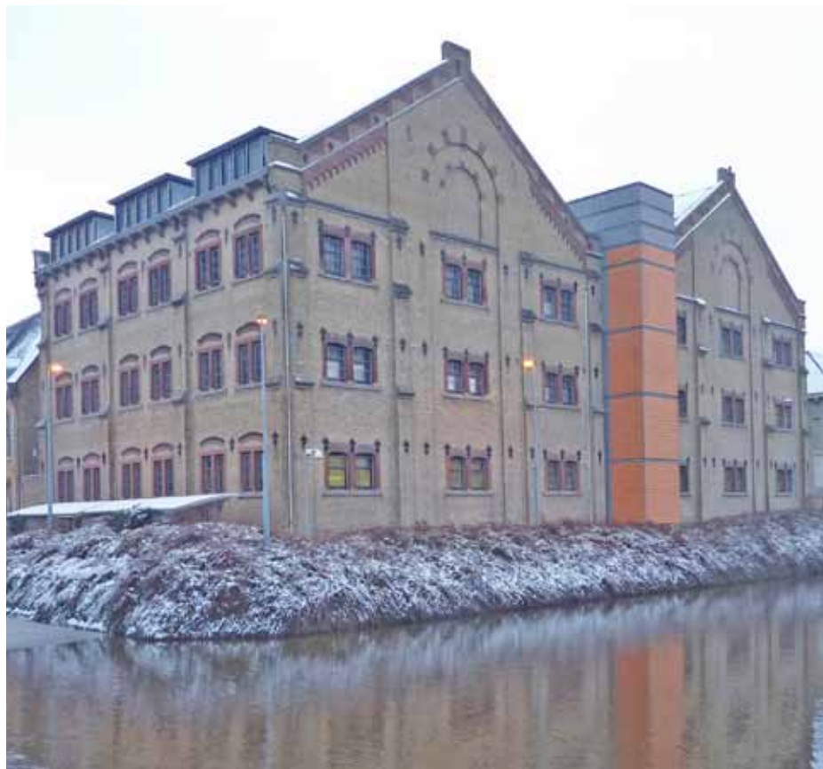
Afbeelding 8. Overzicht van de zuid- en westgevel van bouwdeel C. Rechts is de contrasterende liftschacht uit 1997 naar ontwerp van Ir. Vegter zichtbaar.
