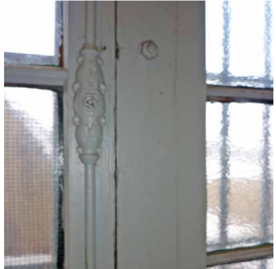
Afbeelding 82. Detail van voorgaande afbeelding met uit de bouwtijd daterende espanjolet (1870).
