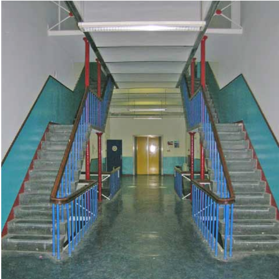
Afbeelding 18. Overzicht van het trappenhuis vanaf de eerste verdieping gezien richting het zuiden.
