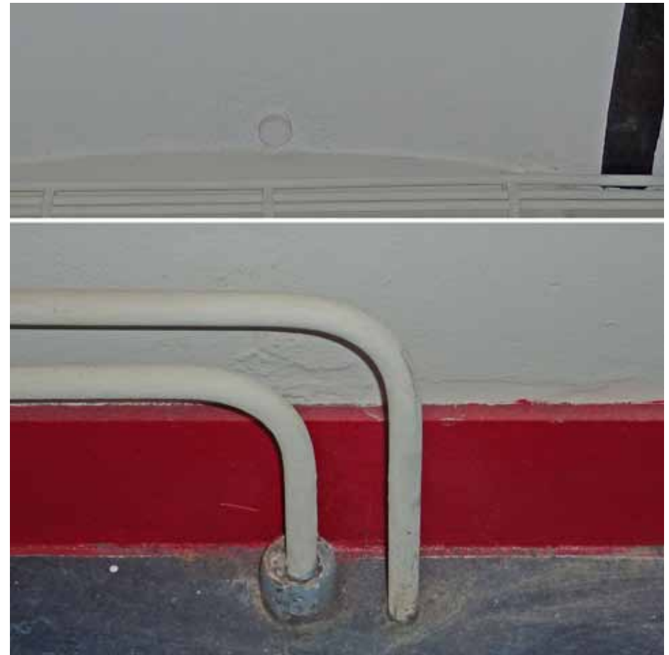
Afbeelding 64. Detail van één van de doorvoeren van de verwarmingsbuizen ter plaatse van de zuidwand van de gang. Links is een 8 cm zware cv-buis zichtbaar, die vermoedelijk uit de verbouwing van 1946-1947 stamt. Vermoedelijk betrof het het zogenaamde Tichelaar systeem, dat functioneerde als een enkelbuizig systeem met natuurlijke circulatie van het cv-water. Tijdens een latere modernisering werden de oude cv-buizen vervangen door duims buizen. De oude buis bleef hierbij in de vloeren als mantelbuis gehandhaafd.
