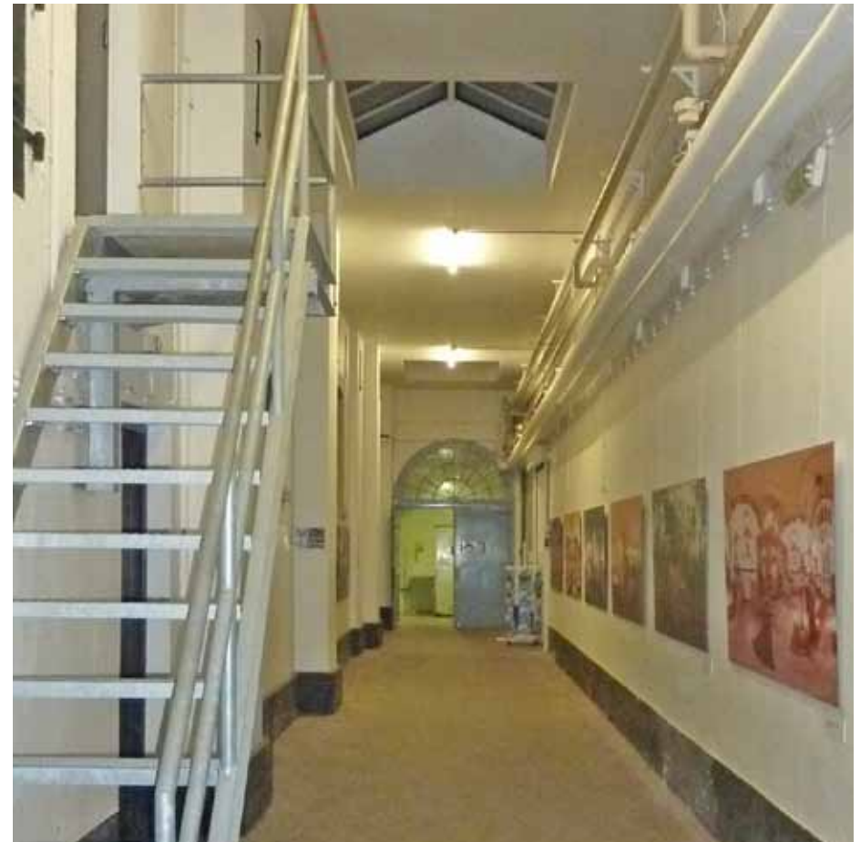
Afbeelding 24. Overzicht van ruimte K0.06 gezien richting het westen. Links de vluchtrap vanaf de sportzaal op de tweede verdieping.
