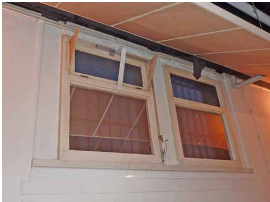
Afbeelding 53. Zicht op één van de vensters in de zuidwand van ruimte K1.18.
