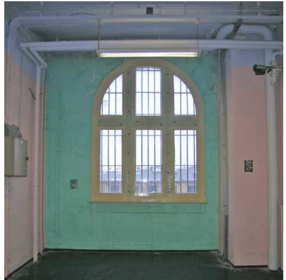
Afbeelding 21. Zicht op het venster in de noordgevel op de tweede verdieping in het trappenhuis (1870).
