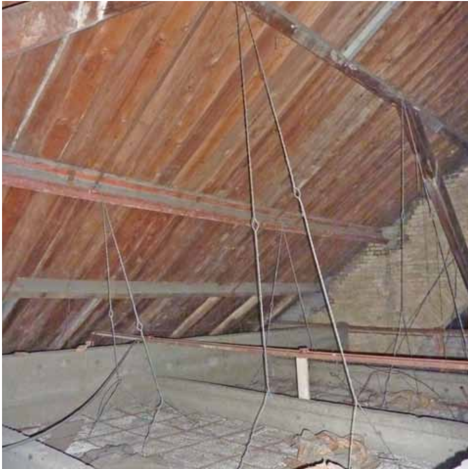
Afbeelding 99. Overzicht van de westelijke kap gezien richting het noorden. Het plafond van de onderliggende vertrekken van de derde verdieping betreft stuc op steengaas tegen een betonnen raamwerk (1946). Het steengaas is middels trekdraden aan de gordingen tegen doorhangen opgehangen. De raveling in het dak juist boven de betonnen randbalk hoort bij het voormalige daklicht, dat in de jaren '50 boven de dakkapellen werd toegevoegd.
