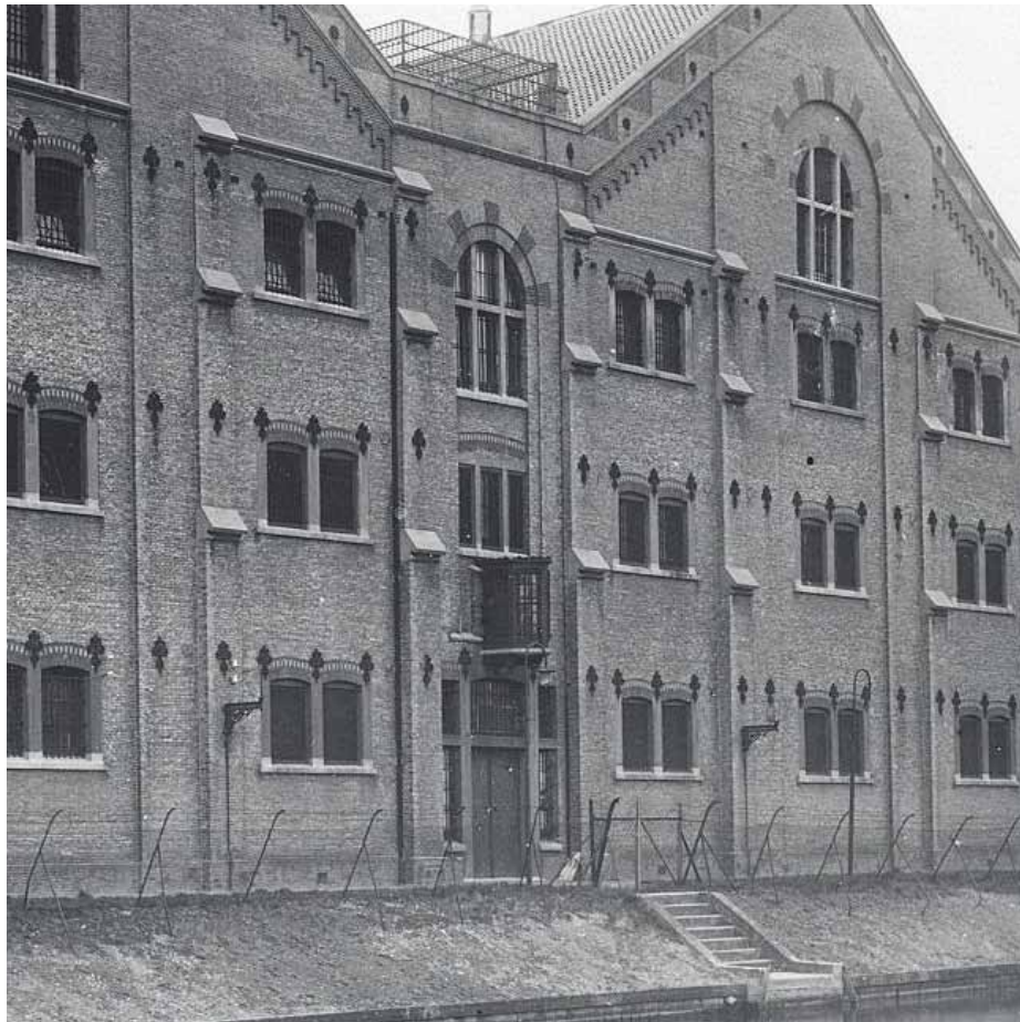
Afbeelding 10. Detail van de voorgaande afbeelding met de zuidgevel omstreeks 1925-1935, zonder de liftuitbouw. Op de begane grond gaf een deur met zij- en bovenlichten toegang tot het talud met een watertrap. Geheel boven is nog juist de ijzeren kooi van de ziekenluchtplaats zichtbaar. Foto: Collectie Beeldbank Leeuwarden, documentnr.: FDBLHSPLA020.
