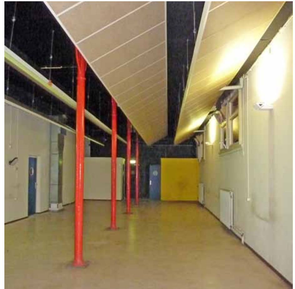
Afbeelding 50. Overzicht van ruimte F1.18 gezien richting het westen. De ruimte wordt gekarakteriseerd door de verbouwing uit 1997 met de marmoleum vloer, meranti plinten en de akoestische platen onder de troggewelven.
