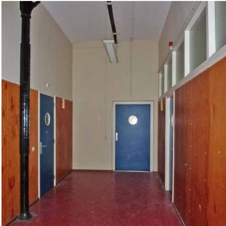
Afbeelding 46. Overzicht van ruimte K1.10 gezien richting het zuiden.
