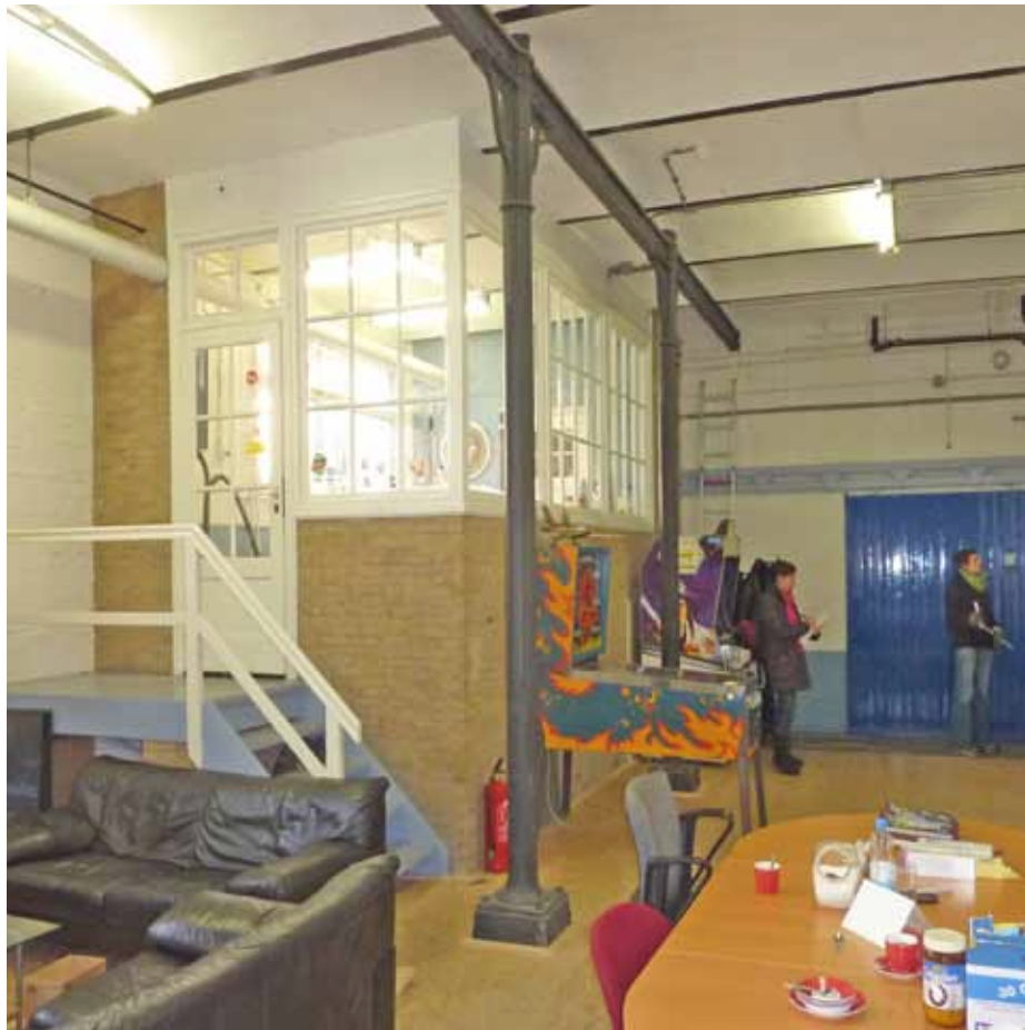
Afbeelding 119. Overzicht van ruimte K0.11 gezien richting het westen. Links het kantoortje uit 1948. De in 1948 ingebouwde hokjes zijn verzorgd gedetailleerd en zijn karakteristiek voor de periode (toezicht op het werk van de gevangenen). De hokjes dienen bij voorkeur behouden te worden.
