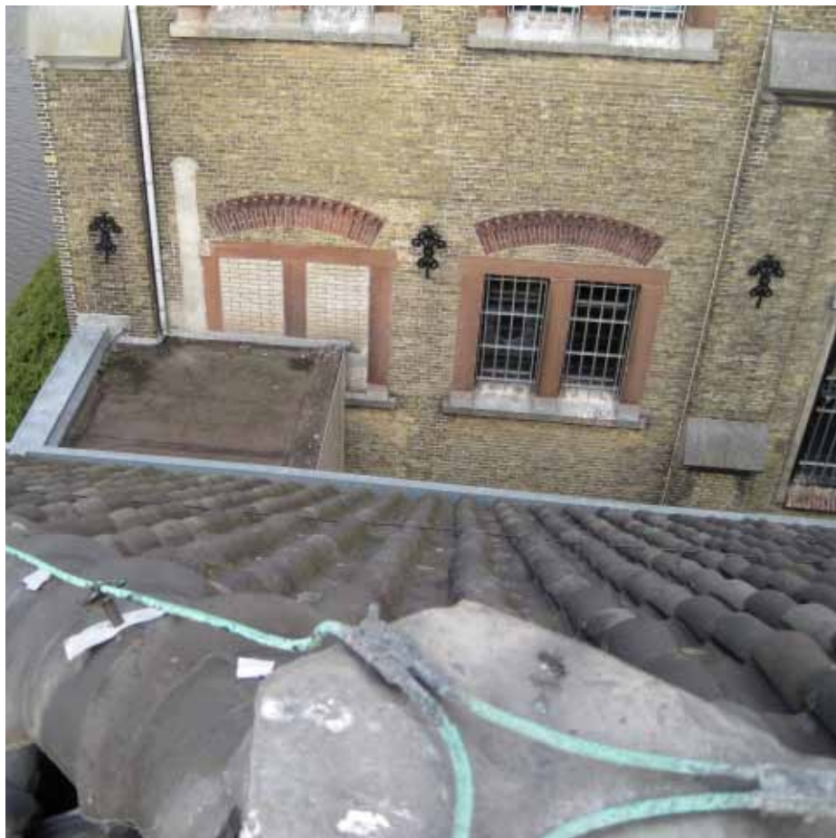
Afbeelding 6. Zicht op het linker gedeelte van de oostgevel ter hoogte van de eerste verdieping. Het venster links werd dichtgezet tengevolge van de aanleg van de gang op de eerste verdieping (1988-1991).
