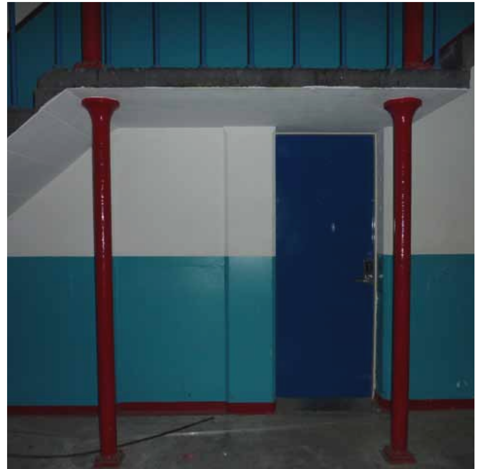
Afbeelding 110. Detail van één van de deuren onder de bordessen in het trappenhuis op de begane grond. De deur op de foto is recent van een beplating voorzien (1988). Links is de verdiepte dichtzetting van de voormalige aangrenzende deur zichtbaar, waardoor een blindnis ontstaan is.
