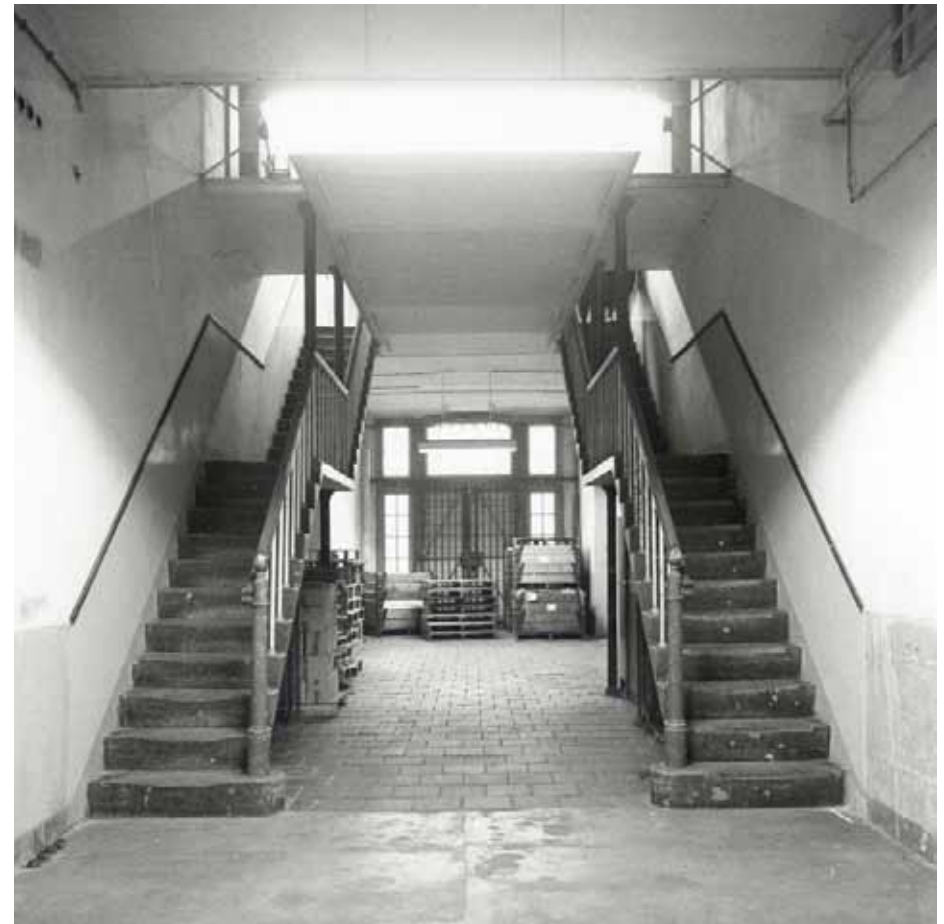
Afbeelding 108. Overzicht van het trappenhuis vanaf de begane grond gezien richting het zuiden in februari 1983. Het trappenhuis is hier zonder hekwerk en nog met de oorspronkelijke uitgang aan de zuidzijde. De lichtval vanaf de zuidgevel vanaf de 1e verdieping en begane grond draagt sterk bij aan de kwaliteit van de ruimte. Foto: Collectie Beeldbank Leeuwarden, documentnr.: FDBLHSPLB060
