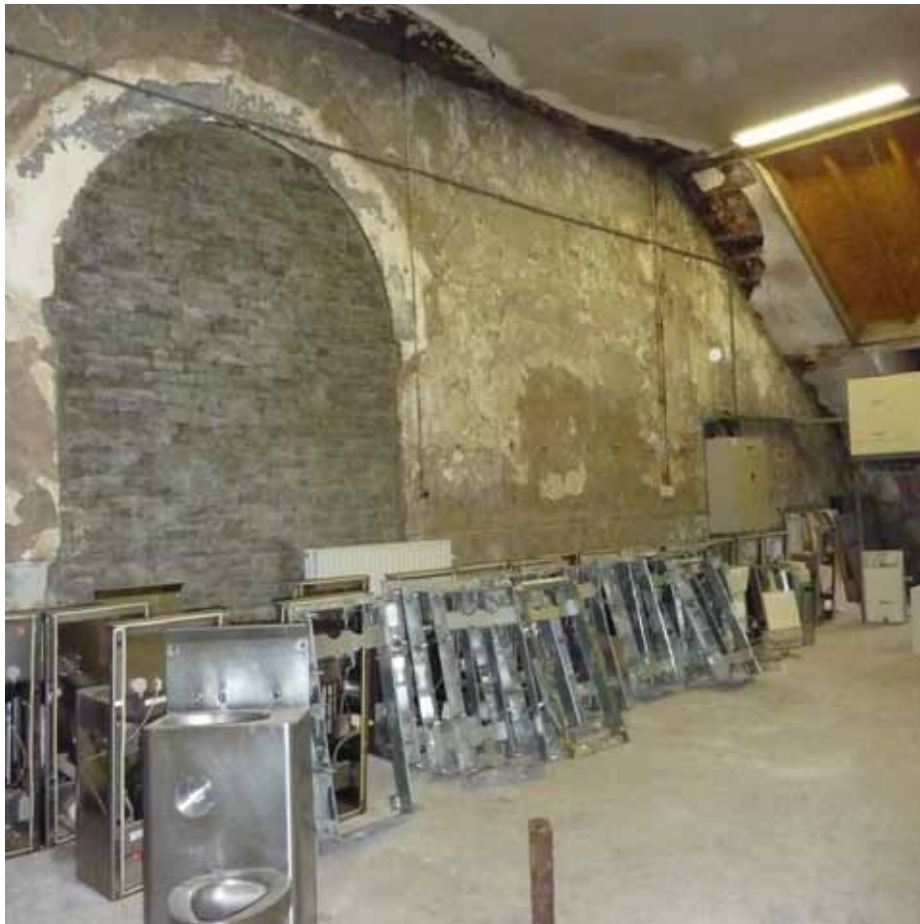
Afbeelding 89. Overzicht van ruimte K3.09 gezien richting het zuidwesten. De grote dakkapel, geheel rechts op de foto, dateert uit 1946-1947. De grote dakramen in de dakvlakken boven de dakkapel zijn van later datum en werden tijdens de verbouwing van 1988-1991 dichtgelegd.
