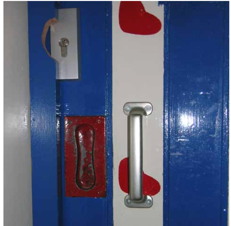
Afbeelding 124. Detail van één van de deuren in het trappenhuis op de begane grond. De deurgrepen werden hier recentelijk aangepast (2004), doch weinig passend bij het bestaande werk.
