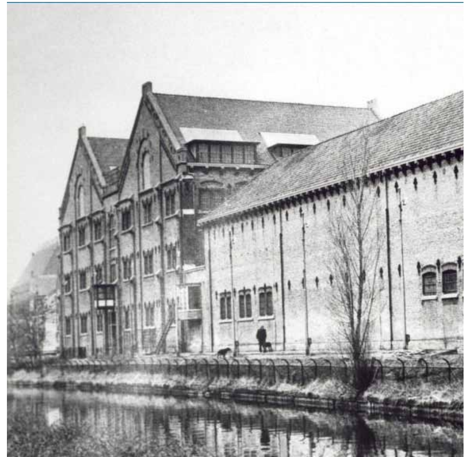
Afbeelding 104. Overzicht van de zuidgevel vanuit het oosten in februari 1974 waarop de dakkapellen uit 1946 en de bovenliggende dakramen uit de jaren '50 van de 20ste eeuw nog zichtbaar zijn. De dakkapellen bezitten een positieve monumentwaarde. De inmiddels verdwenen dakramen waren storend in de gevelarchitectuur en dienen niet hersteld te worden. Foto: Collectie Beeldbank Leeuwarden, documentnr.: FDBLHSPLA053.
