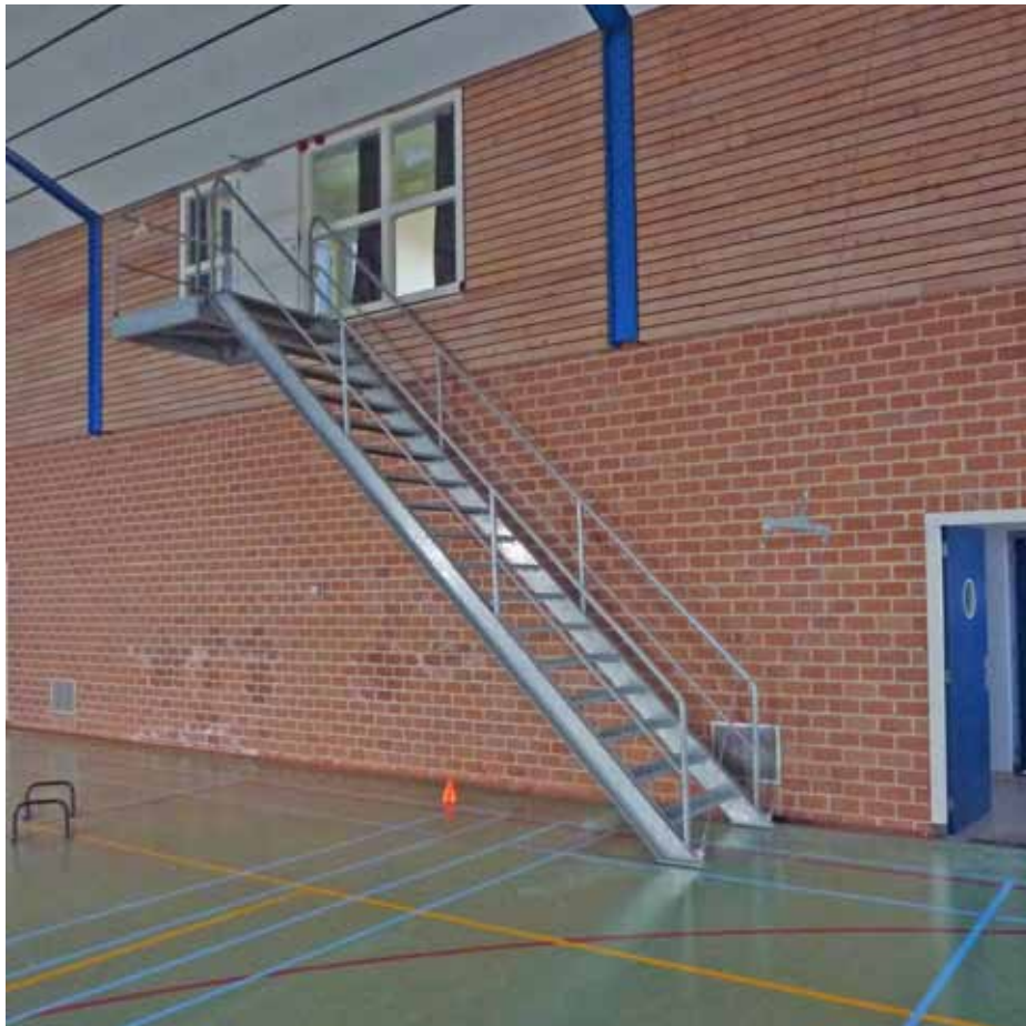
Afbeelding 66. Zicht op de trap tegen de westwand van ruimte K2.08. De ophaalbare stalen trap werd in 2000 aangebracht als vluchtweg voor het personeel.
