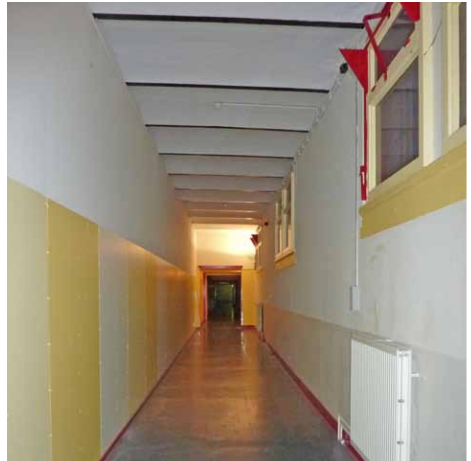
Afbeelding 62. Overzicht van ruimte K1.29 gezien richting het oosten.
