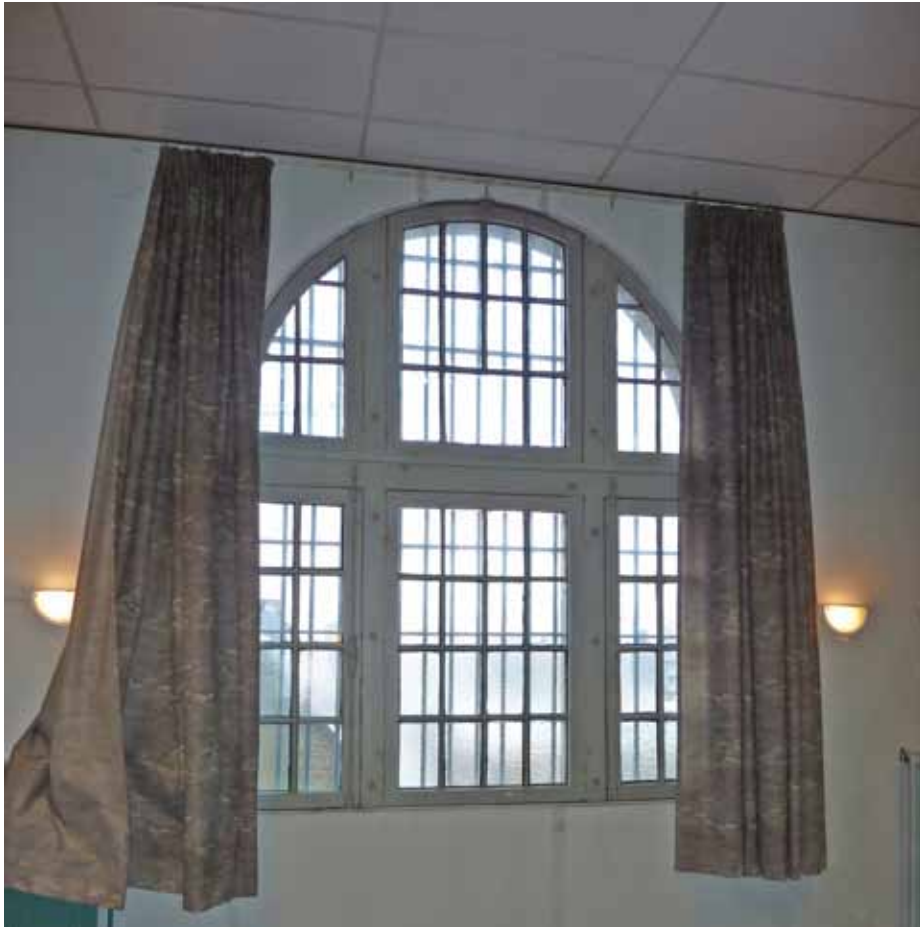
Afbeelding 81. Zicht op het venster in de noordelijke kopgevel in ruimte K3.01, een uit de bouwtijd daterend groot getoogd roedenraam met zinken roeden en bijhorende originele espanjoletten (1870).
