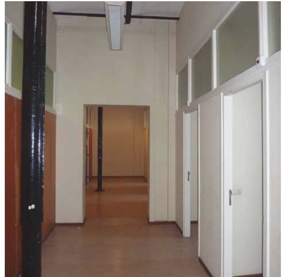
Afbeelding 47. Overzicht van ruimte K1.17 gezien richting het zuiden. Rechts naats de doorgang is een terugliggende sleuf zichtbaar, behorende bij een voormalig ventilatiekanaal uit de bouwtijd.
