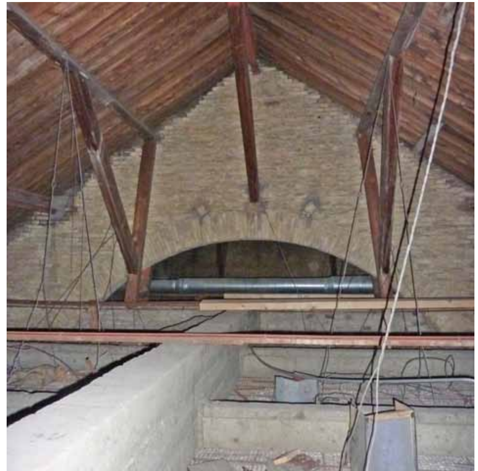
Afbeelding 98. Overzicht van de westelijke kap gezien richting het zuiden. In plaats van spanten zijn de bouwmuren tot in de zolderruimten doorgetrokken, waarop de gordingen met muurstijlen en korbels zijn opgelegd. Blijkens een reeks dichtgezette balkgaten, waren de twee afgeschoorde gordingen oorspronkelijk onder 45 graden op de gevel afgeschoord.
