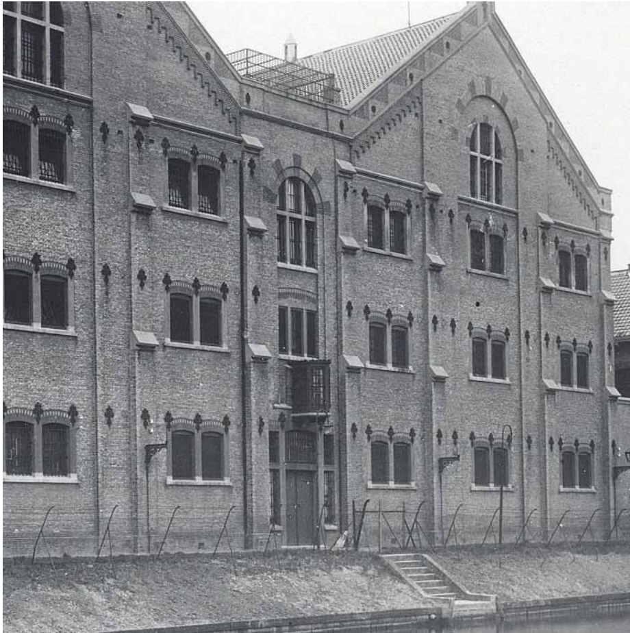
Afbeelding 101. De zuidgevel zonder de liftuitbouw. Op de begane grond gaf een deur met zij- en bovenlichten toegang tot het talud met een watertrap. Foto: Collectie Beeldbank Leeuwarden, documentnr.: FDBLHSPLA020.
