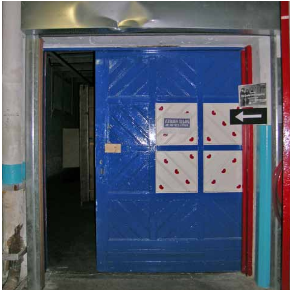
Afbeelding 20. Zicht op de toegangsdeur van ruimte K0.08 in de oostwand op de begane grond. De schuifdeuren met kraaldelen werden tijdens de verbouwing van 1946-1948 ingebracht.
