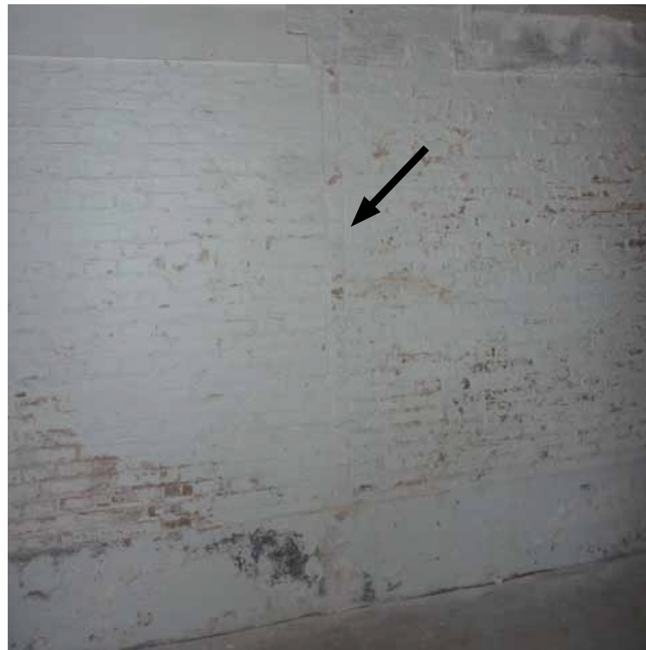
Afbeelding 33. Zicht op het muurwerk van de oostwand van ruimte K0.07. De pijl geeft een bouwspoor aan van een voormalige dwarswand of tussenschot, behorende bij de oorspronkelijke gootstenen en hardstenen tussenschotten.
