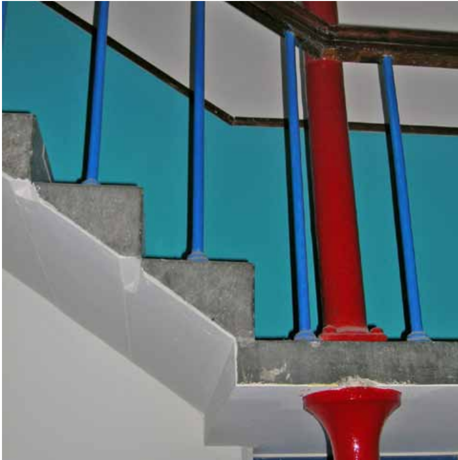
Afbeelding 22. Zicht op het bordes van één van de trappen. De treden en tussenbordes zijn uit massief hardsteenblokken vervaardigd (1870).
