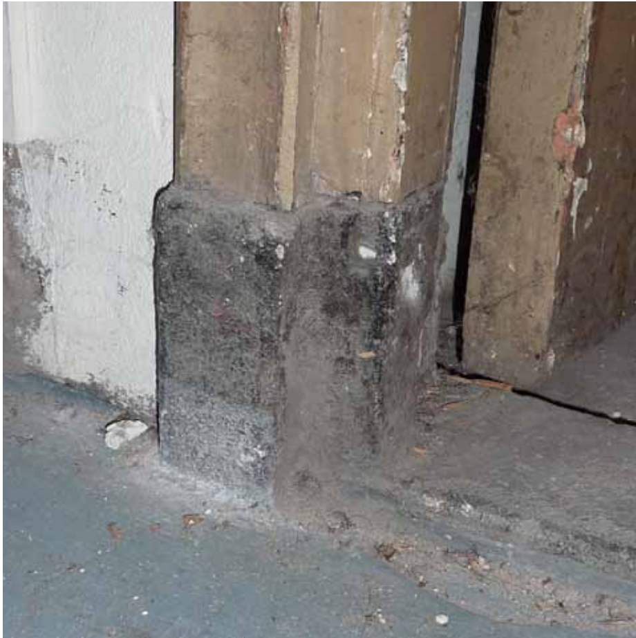
Afbeelding 84. Detail van de onderzijde van de rechter stijl van de deur op de voorgaande afbeelding. De deurkozijnen zijn voorzien van gecementeerde neuten en dorpel (1946-1947).
