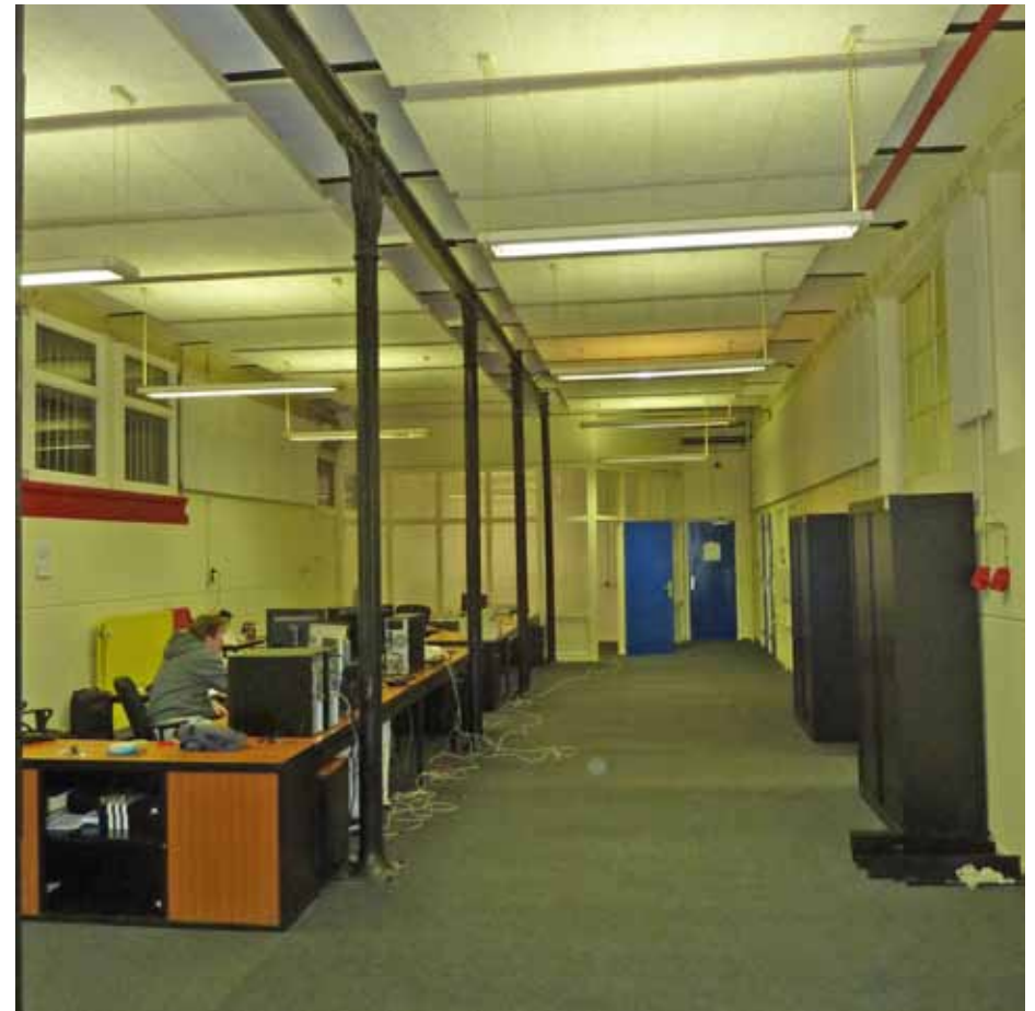
Afbeelding 68. Overzicht van ruimte K2.20 gezien richting het oosten. In de ruimte bevinden zich recente akoestische platen onder het oorspronkelijke plafond met troggewelven (1997)
