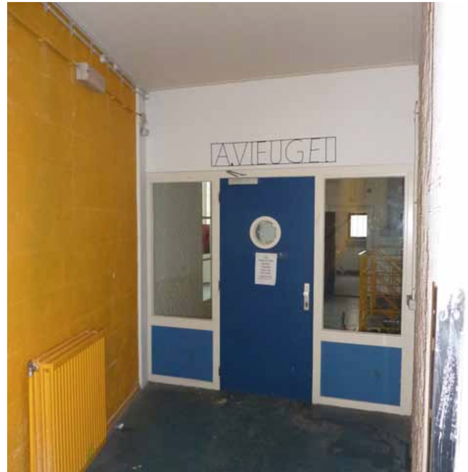
Afbeelding 79. Overzicht van ruimte A1.09 gezien richting het oosten (cellenhal). De schuine wand aan de linker zijde maakt deel uit van de verbindingsgang (1988) tussen de bouwdelen E en F.
