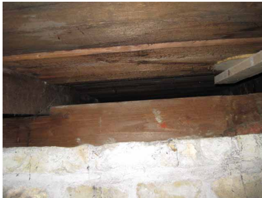
Afbeelding 85. Zicht vanuit de zolderruimte boven de cellen naar de ruimte boven de cellenhal. Detail van de muurplaat op de bouwmuur van de cellenhal, die de daksporen halverwege het zadeldak ondersteunt. Foto: Dhr. Bastiaans, Monumentenwacht Overijssel en Flevoland / Drenthe 2009.
