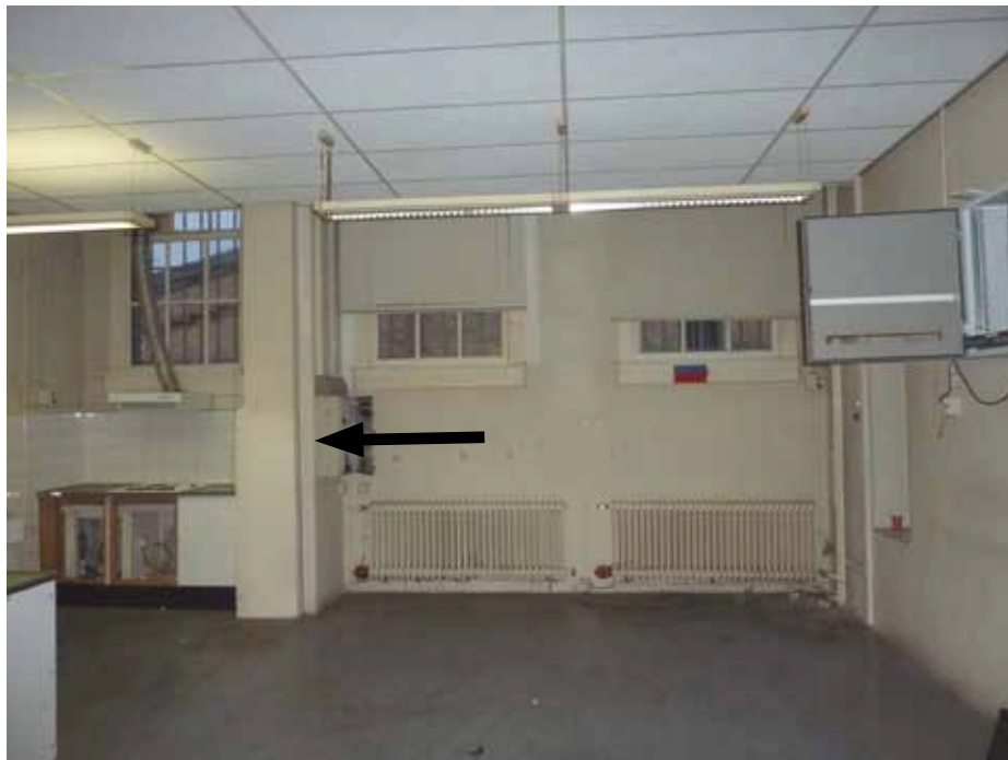
Afbeelding 54. Overzicht van ruimte A2.26 gezien richting het oosten (de buitengevel). Op deze afbeelding is de voormalige scheidingswand zichtbaar. Deze wand werd ten behoeve van de bewakersruimte in 1988 verwijderd. De linker ruimte was oorspronkelijk ingericht als keuken voor de woning van de bewaardster en de ruimte rechts was de gezamenlijke ziekencel. Het verschil in functie tussen beide ruimten is af lezen in de detaillering van de vensters (zie Afbeelding 55).
