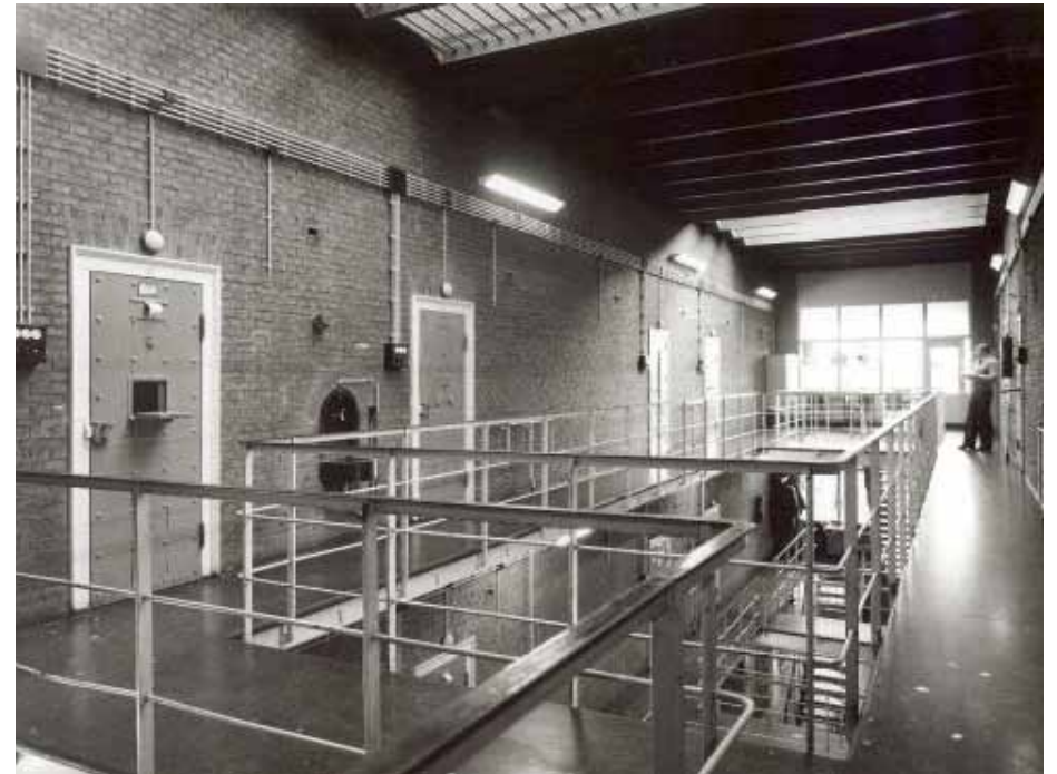
Afbeelding 31. Overzicht van de cellenhal in februari 1983, gezien richting het zuiden. Hier zijn de oorspronkelijke balustrades en de fonteintjes nog aanwezig. De wand naar de in 1964 gerealiseerde toezichtruimte werd in 1988 verwijderd. Foto: Collectie Beeldbank Leeuwarden, documentnr.: FDBLHSPLB025
