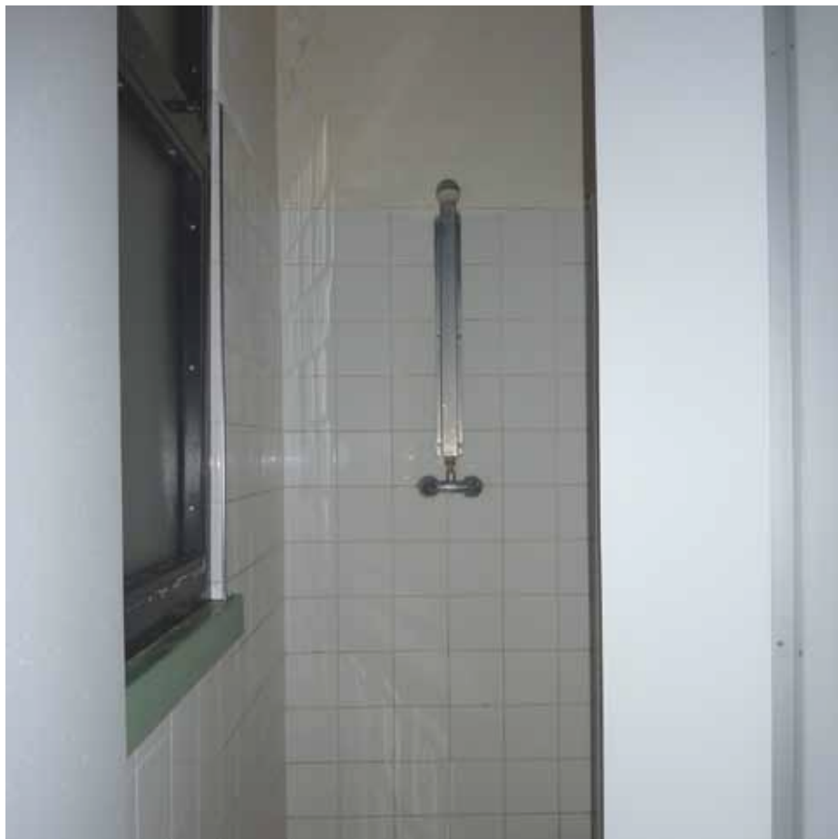
Afbeelding 57. Zicht in één van de douches. De douches zijn van elkaar gescheiden middels trespa schermen.
