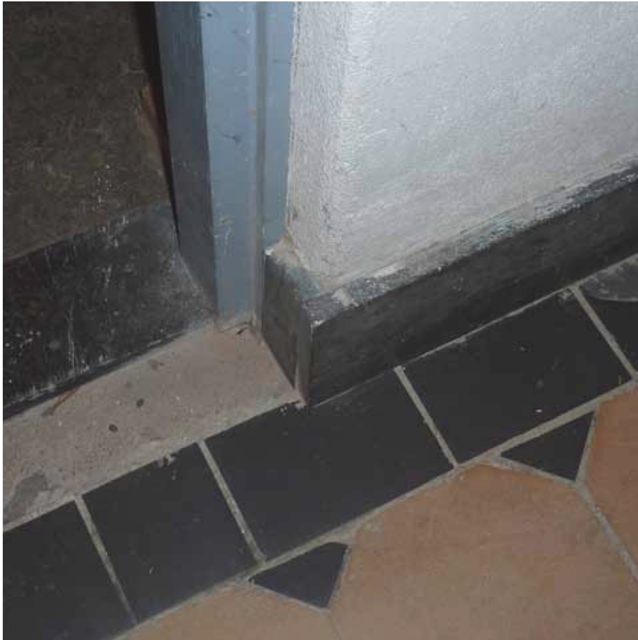
Afbeelding 68. Onderdetail van één van de doorgangen in de gang. De oorspronkelijke plint is gecementeerd en zwart geschilderd. Ter plaatse van secundaire openingen of dichtzettingen werd deze aangeheeld met stroken hardsteen van dezelfde afmetingen.
