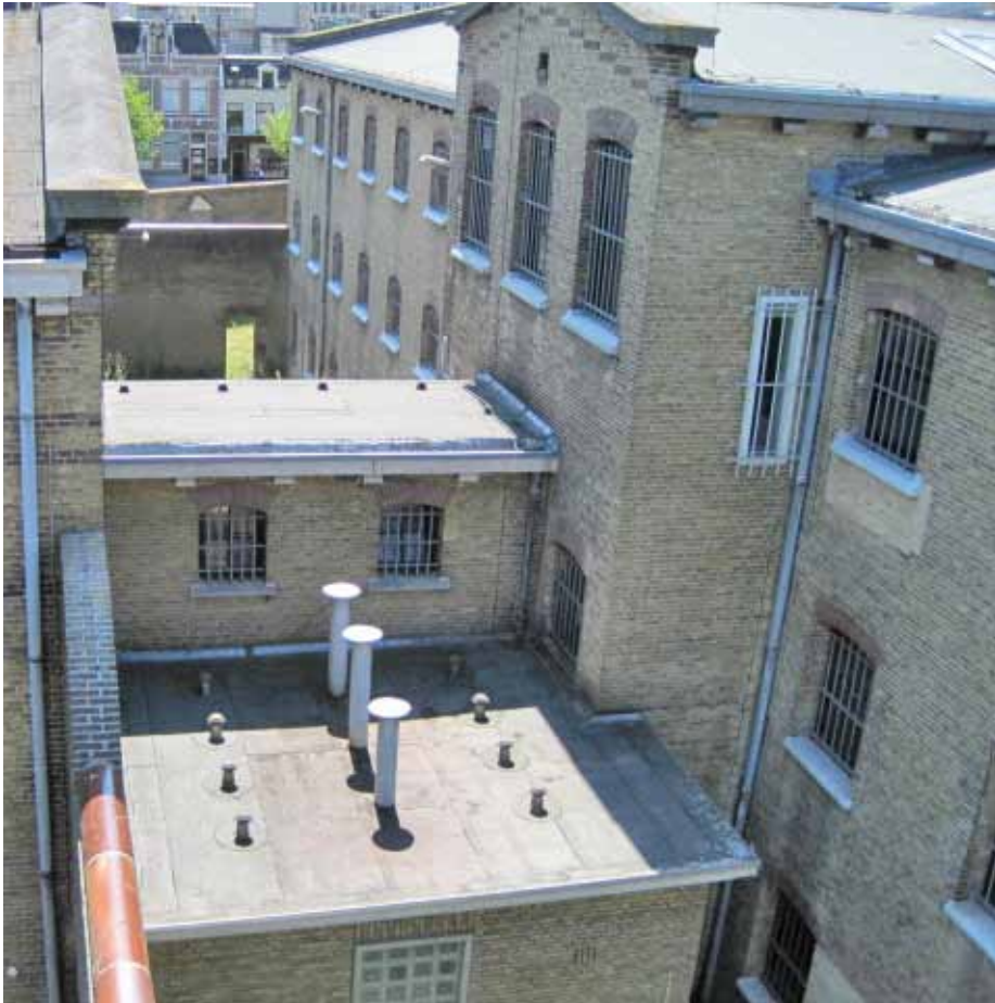
Afbeelding 6. Overzicht van het midden- en linker deel van de oostgevel. Het venster in de noordelijke zijgevel van de dwarsbeuk ter hoogte van de tweede verdieping werd in 1988 ingebroken. Het lichtere metselwerk (1997) onder het venster rechts daarvan - in het rechter deel van de zijgevel - geeft aan dat dit venster langer was (vergelijk met Afbeelding 96). Foto: Dhr. Bastiaans, Monumentenwacht Overijssel en Flevoland / Drenthe 2009.
