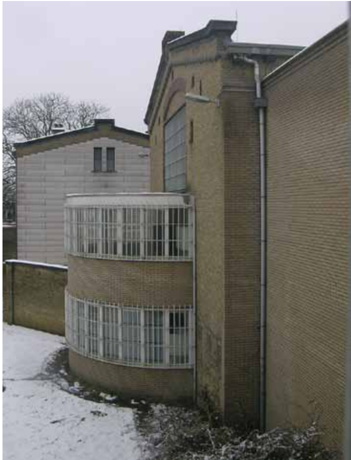
Afbeelding 4. Overzicht van de kopgevel (noordgevel) van Bouwdeel F. De halve cirkelvormige tweelaags aanbouw werd gerealiseerd na het slopen van de wandelplaatsen in 1983 (vergelijk met Afbeelding 5). Het onderste deel van het drielicht ter hoogte van de eerste en tweede verdieping is aan de binnenzijde van de aanbouw nog zichtbaar.
