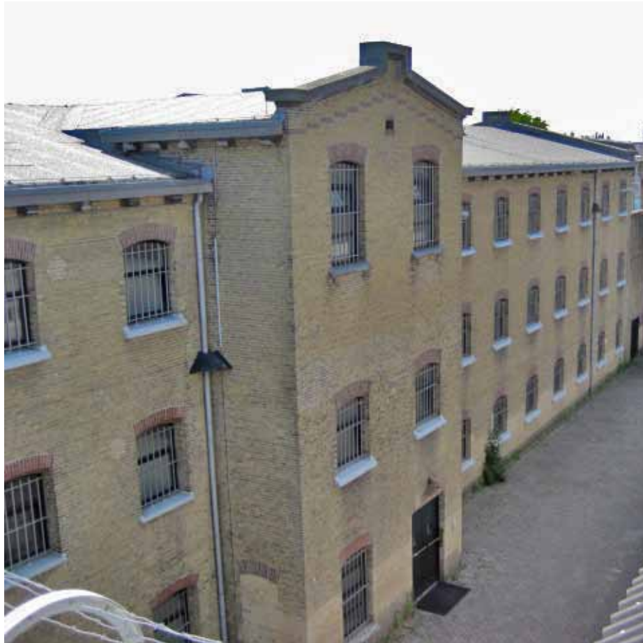
Afbeelding 10. Overzicht van de westelijke zijgevel. De ruimten op de begane grond en tweede verdieping van de dwarsbeuken hadden een afwijkend gebruik, hetgeen zich aftekent in de grootte van de vensters. Het venster in de noordelijke zijgevel van de dwarsbeuk werd recentelijk dichtgezet (1997) bij het renoveren van de achterliggende sanitaire ruimte. Foto: Dhr. Bastiaans, Monumentenwacht Overijssel en Flevoland / Drenthe 2009.
