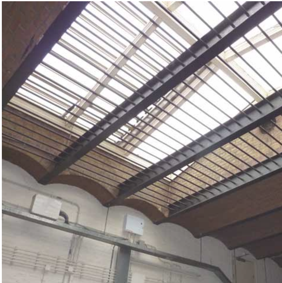
Afbeelding 23. Zicht op de onderzijde van het oorspronkelijke daklicht (1891). Dwars op de doorgaande I-profielen van de troggewelfjes zijn ijzeren staven bevestigd met een onderlinge afstand van 15 cm. De kopschotten bestaan uit schoon metselwerk met geknipte voegen. De kozijnen zijn voorzien van geprofileerde latten. Twee ramen aan de oostzijde (links) zijn voorzien van ventilatieschoepen (1988), de overige ramen bezitten draadglas.
