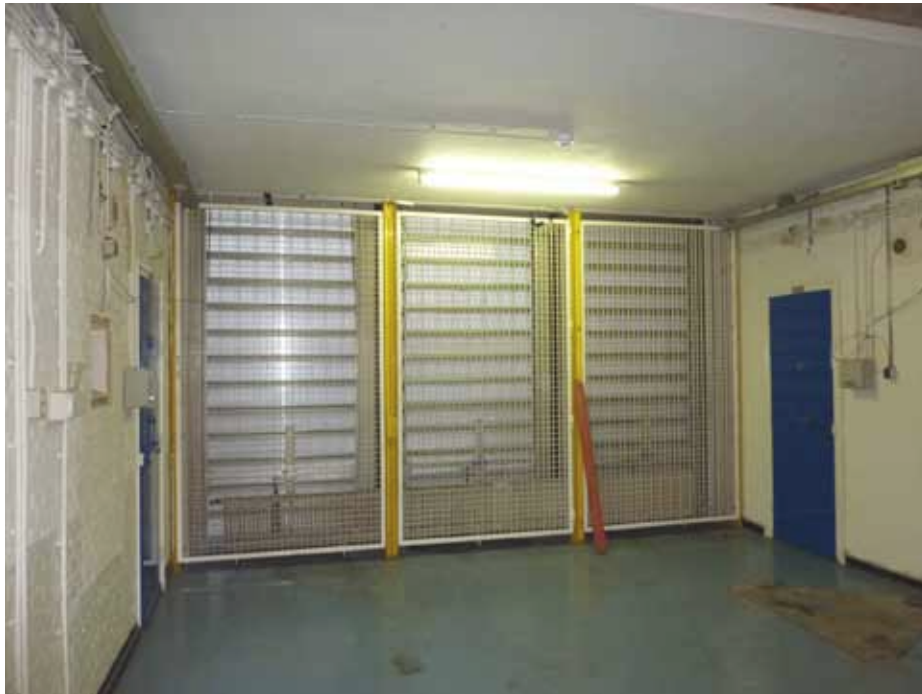
Afbeelding 28. Zicht op de zuidelijke kopgevel ter hoogte van de eerste verdieping. Ter hoogte van de eerste en tweede verdieping is een pui aangebracht in de kopgevel, die door twee verticale stijlen in drieën gedeeld wordt. In het onderste gedeelte van de pui bevinden zich in elk deel dertien horizontale lamellen (1988) uit geribt veiligheidsglas, die kunnen worden geopend ten behoeve van ventilatie van de hal. De vloer ter plaatse van deze gevel werd aangebracht in 1964 ten behoeve van het realiseren van toezichtruimten. Voorheen was dit deel van de cellenhal geheel open. De toegangen tot de cellen die op deze vloer ontsluiten, werden ingebroken bij het splitsen van de cellen in 1988.
