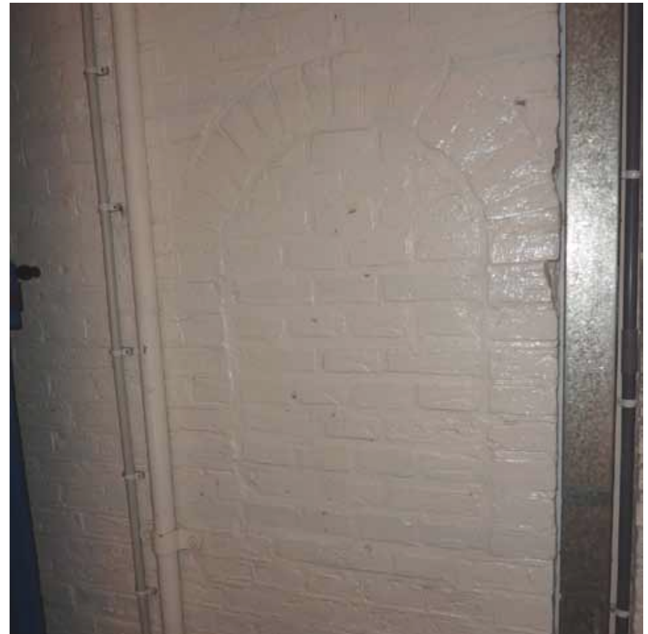
Afbeelding 33. Detail van één van de dichtgezette fonteintjes in de cellenhal (tussen cellen A1.06 en A1.07). In de sporing rechts van de dichtzetting (nu aluminium kabelgoot) bevond zich vroeger de aan- en afvoerleiding van de fonteintjes.
