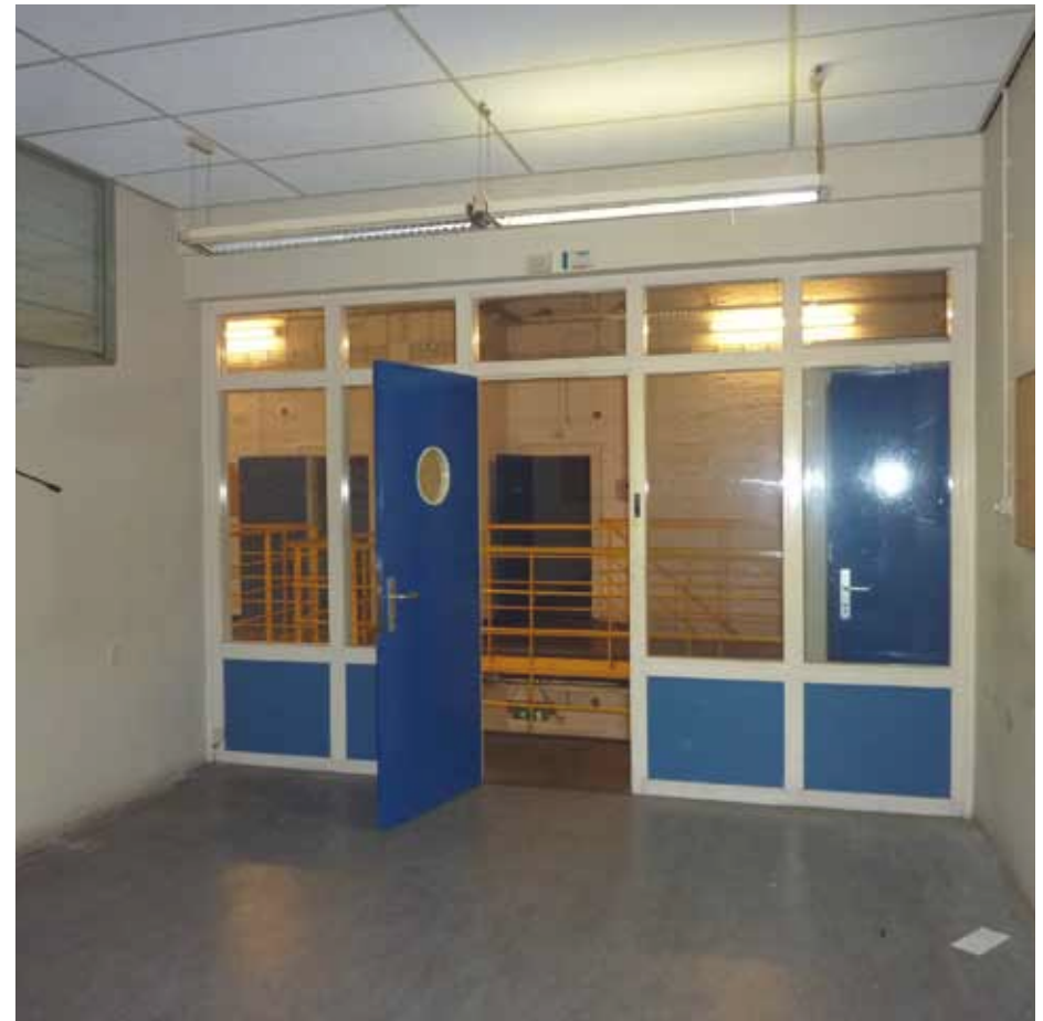
Afbeelding 53. Overzicht van ruimte A2.26 gezien richting het westen (de cellenhal). De pui werd in 1988 ingebracht ten behoeve van het toezichthouden op de cellenhal. De westwand van de voormalige gezamenlijke ziekencel werd hierbij grotendeels verwijderd (vergelijk met Afbeelding 95).
