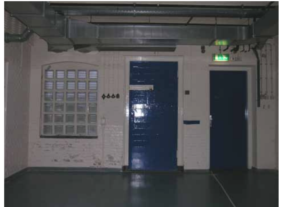
Afbeelding 27. Zicht op de zuidelijke kopgevel ter hoogte van de begane grond. In het midden een buitendeur uit de bouwtijd (1891), met links daarvan een venster opgebouwd uit glazen bouwstenen (1964) en rechts een recente deuropening (1997) naar de daarachter gelegen gang (A0.38). Het venster links is voorzien van een segmentboogvormige rollaag en een hardstenen vensterbank. Ter plaatse van rechter deuropening bevond zich tot de vernieuwing van het sanitair (1997) een extra toilet.
