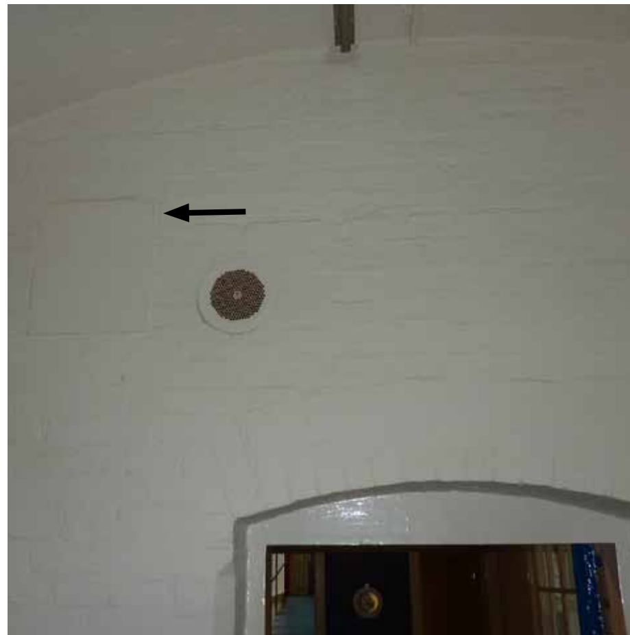
Afbeelding 41. Detail van voorgaande afbeelding. Het houten kozijn van de celdeur bevindt zich in een gemetselde doorgang die wordt overspannen door een segmentboog. De hoeken van het metselwerk zijn voorzien van vellingkanten, beëindigd door kappelletjes. Boven de deur is een ronde (ventilatie)opening aangebracht met links daarvan de dichtgezette oorspronkelijke rechthoekige ventilatieopening (ter plaatse van de pijl).
