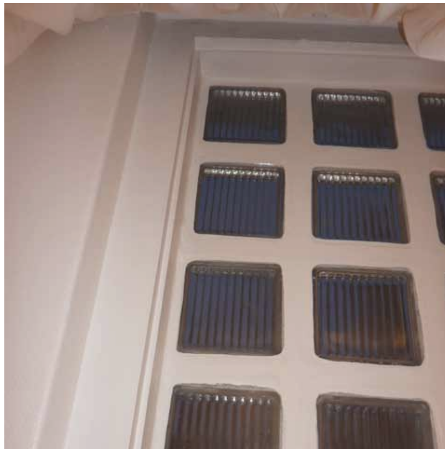
Afbeelding 74. Detail van één van de vensters in de buitengevel van ruimte N0.06. De vensters (1957) zijn opgebouwd uit geribde glazen bouwstenen.
