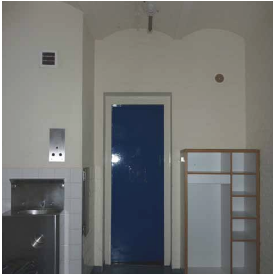
Afbeelding 45. Overzicht van ruimte A1.08 gezien richting de cellenhal A1.29.
