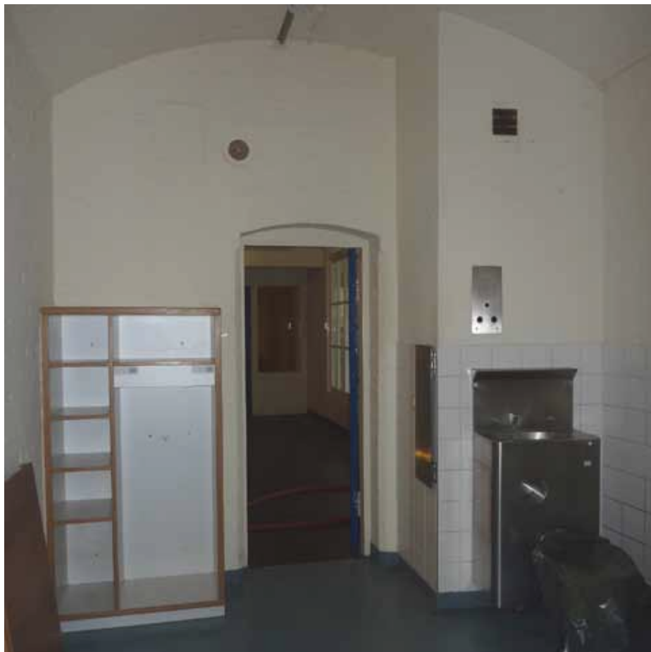
Afbeelding 40. Overzicht van ruimte A1.01 gezien richting de cellenhal A1.29.
