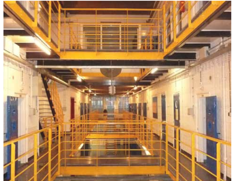
Afbeelding 18. Overzicht van ruimte A1.29 gezien richting het noorden. De cellenhal is op de tweede verdieping korter en door een gemetselde wand afgesloten van de hal van de voormalige vrouwenafdeling (A2.27). Aan de rechter zijde zijn ter hoogte van de eerste verdieping achtereenvolgens een toegang tot een cel (1948), de kapper (1988), de verbindingsgang naar bouwdeel G (1891) en het luik met daarachter de spiltrap zichtbaar.
