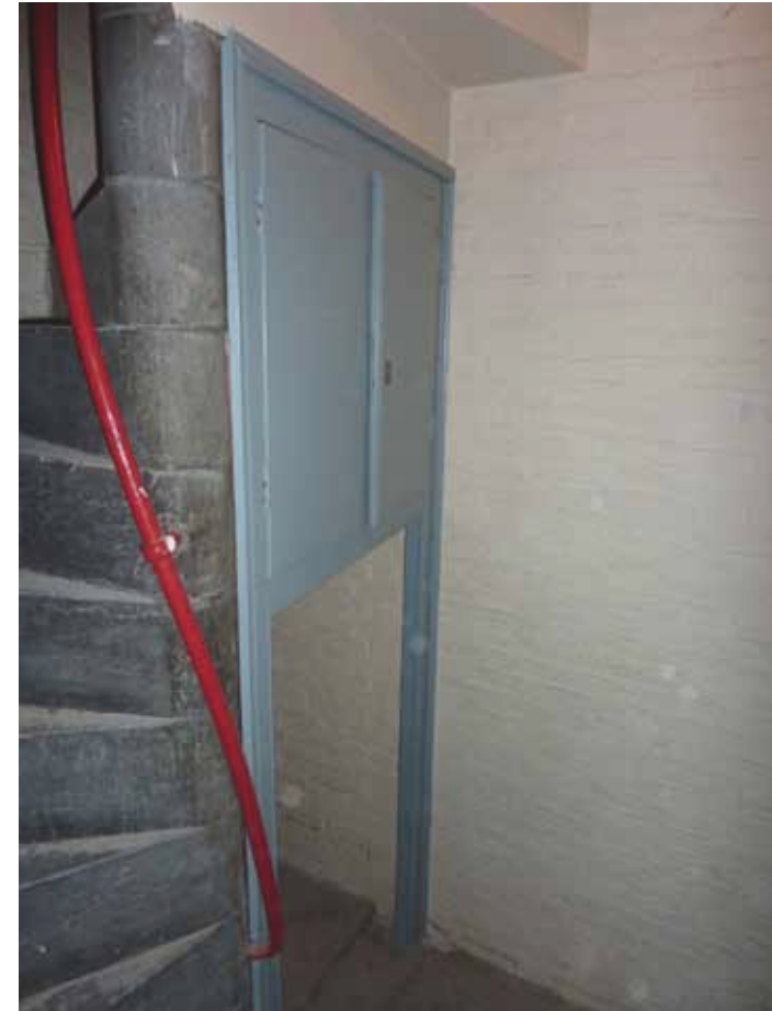
Afbeelding 61. Zicht op de kast onder de hardstenen spiltrap op de begane grond van de traptoren. De aan de bovenzijde door middel van twee deuren af te sluiten kast stamt uit de bouwtijd. De stijlen zijn voorzien van eenvoudig geprofileerde lijsten en de deuren van scharnieren met oud-hollandse knop.
