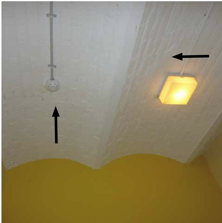
Afbeelding 70. Zicht op de troggewelfjes boven ruimte N0.03. Op de gewelfjes tekenen zich de sporen af van voormalige binnenwanden (zie Afbeelding 71 en Afbeelding 108).
