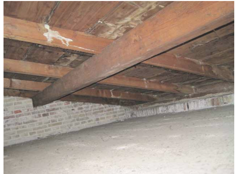
Afbeelding 82. Zicht in de kapconstructie boven één van de cellen. De daksporen liggen op de muurplaat en de bouwmuur van de de cellenhal en worden in het midden door een extra gording op standvinken ondersteund. Foto: Dhr. Bastiaans, Monumentenwacht Overijssel en Flevoland / Drenthe 2009.
