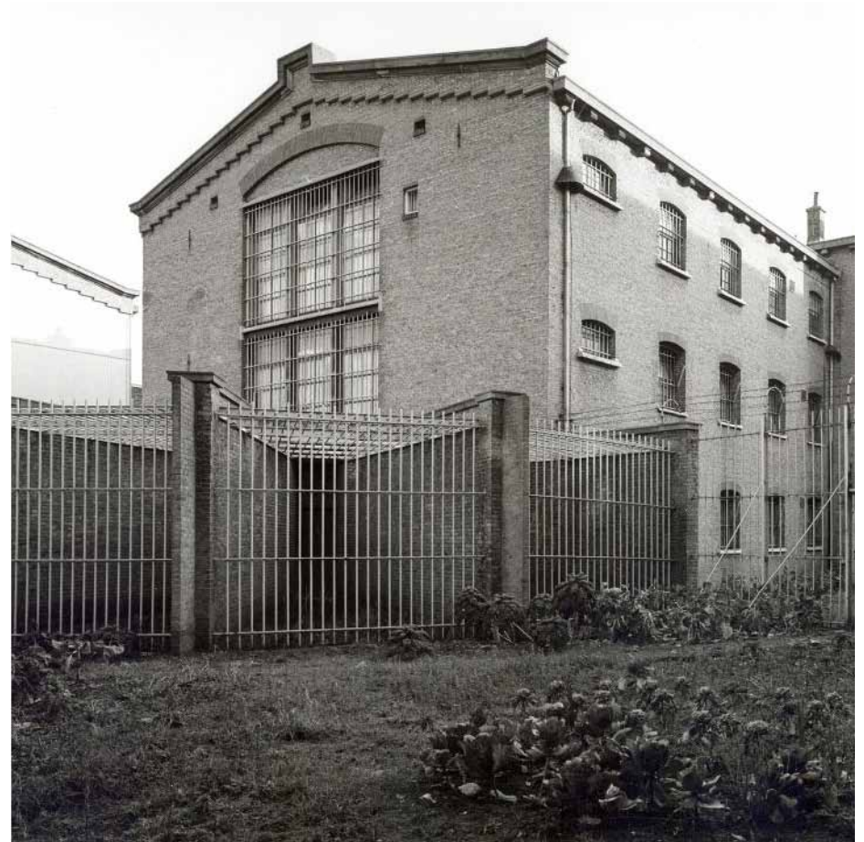
Afbeelding 5. Overzicht van de noordelijke kopgevel en westelijke zijgevel in februari 1983. Alle acht wandelplaatsen waren nog aanwezig en de vensters van de meest linker vensteras van de zijgevel bezitten op deze afbeelding nog de hoogte van de oorspronkelijke vensters (vergelijk met Afbeelding 9).. In 1988 werd ter plaatse van het meest linker venster van de zijgevel een verbindingsgang met bouwdeel E gerealiseerd, het achterliggende trappenhuis verloor hierbij zijn functie. Foto: Collectie Beeldbank Leeuwarden, documentnr.: FDBLHSPLB032
