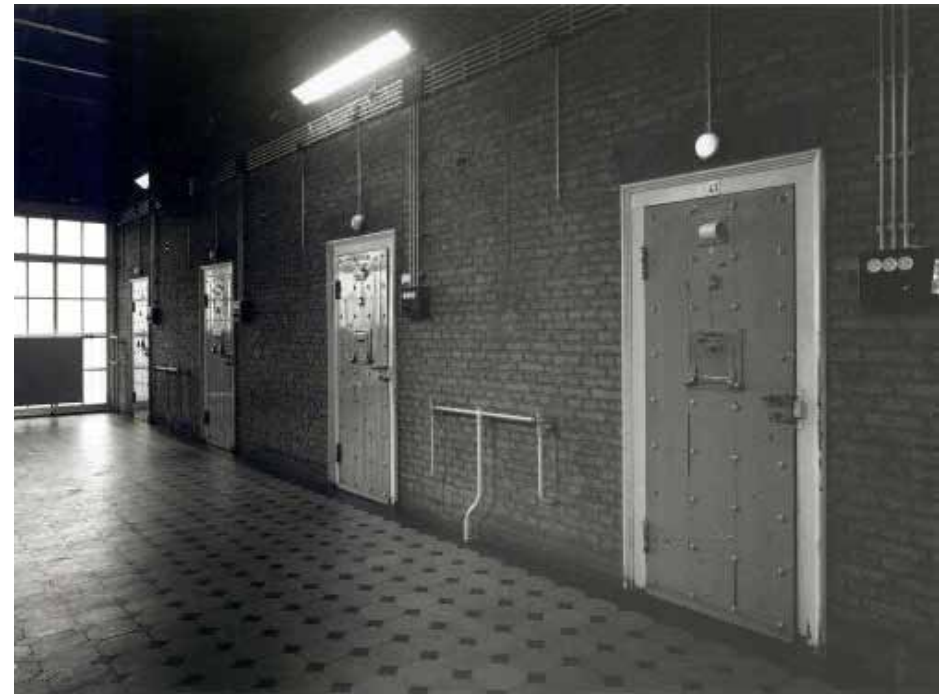
Afbeelding 36. Overzicht van de voormalige vrouwenafdeling in februari 1983, gezien richting het noorden. De schoon metselwerk wanden waren nog niet wit gesausd (1988). De rode baksteen van de plint en de hanekammen tekent zich af in de donkerdere kleur. Foto: Collectie Beeldbank Leeuwarden, documentnr.: FDBLHSPLB028
