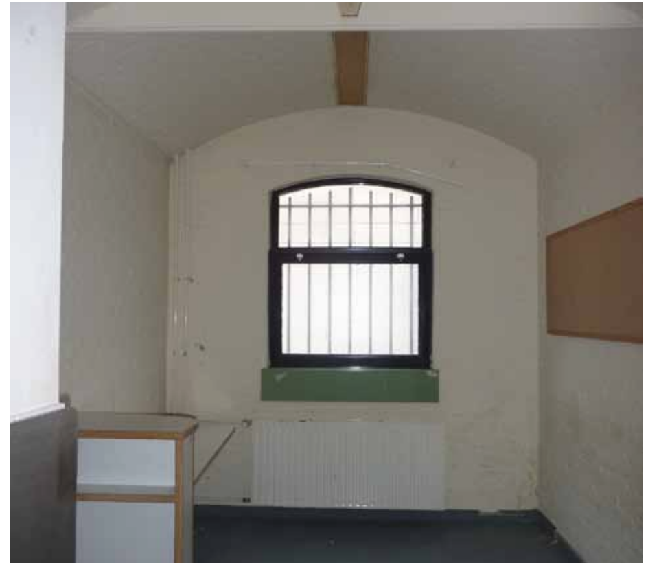
Afbeelding 39. Overzicht van ruimte A1.01 gezien richting de buitengevel.
