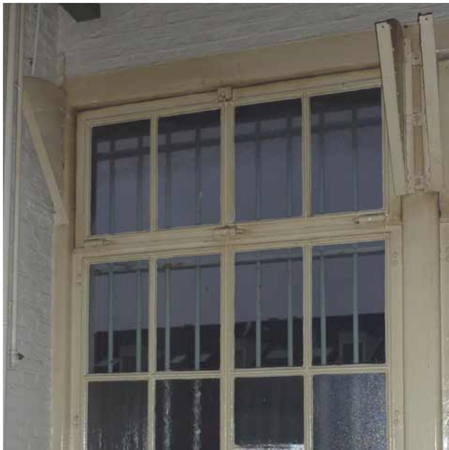
Afbeelding 37. Detail van de binnenzijde van de stalen ramen in het venster ter hoogte van de tweede verdieping (A2.29), bestaand uit 16-ruits vaste onder- en 4-ruits naar binnen vallende bovenramen. De ramen zijn uitgevoerd met een verzwaarde middenstijl, zijn voorzien van een oijef en bezitten ruiten in diverse kleuren en soorten glas.
