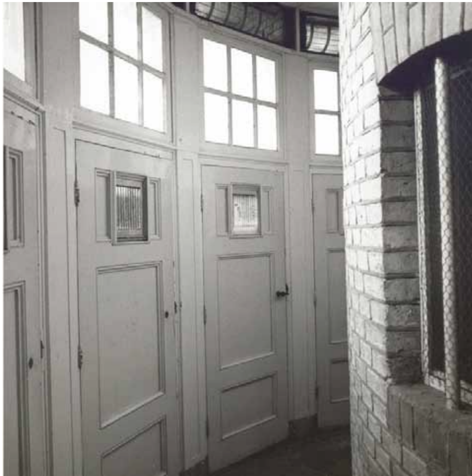
Afbeelding 48. Overzicht van ruimte A0.26a gezien richting het oosten in februari 1983. Aan de linker zijde is de gesegmenteerde pui met daarin de paneeldeuren met 6-ruits bovenlichten zichtbaar. De wand rechts werd in 1988 verwijderd bij het slopen van zes van de acht luchtplaatsen. Foto: Collectie Beeldbank Leeuwarden, documentnr.: FDBLHSPLB022
