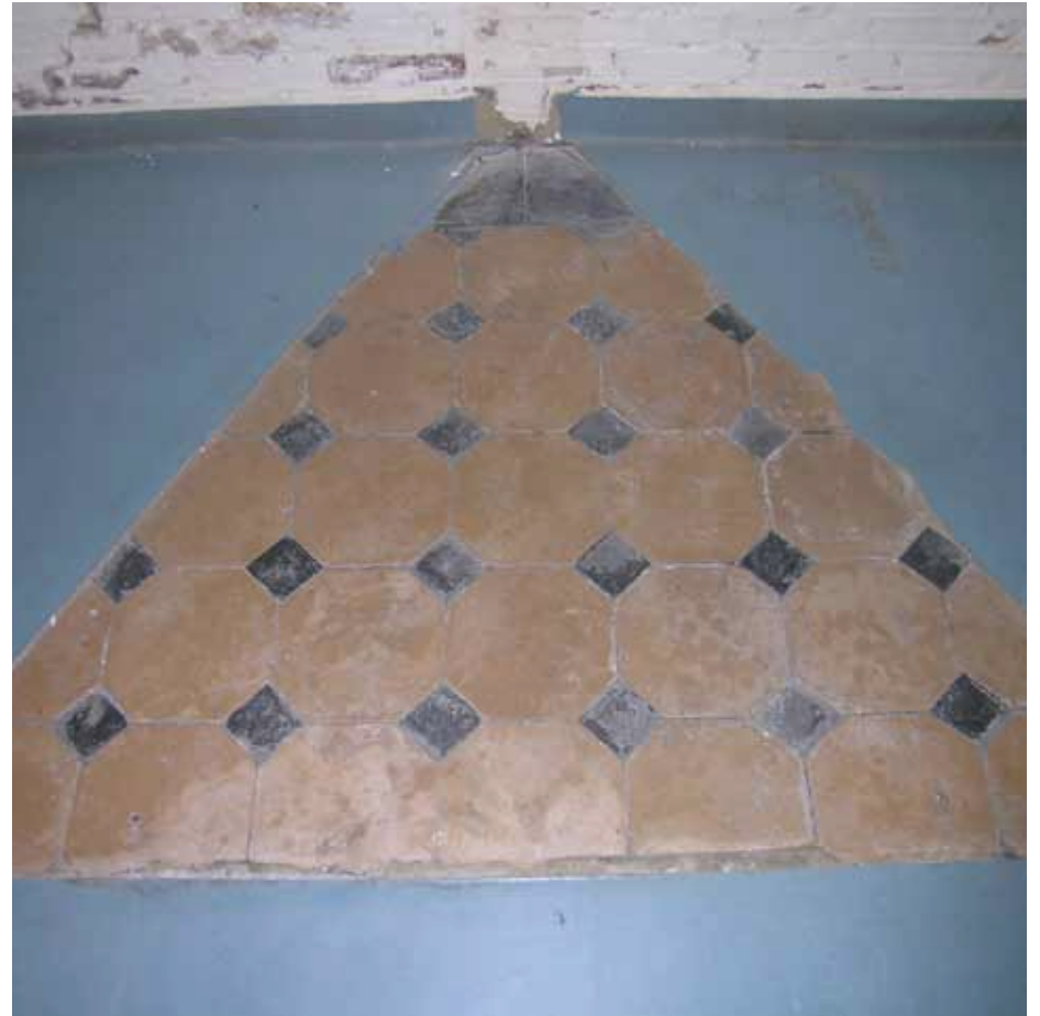
Afbeelding 20. Detail van de oorspronkelijke tegelvloer onder de huidige gietvloer (1997). De vloer (1891) is opgebouwd uit hardgebakken achthoekige okergele tegels met zwarte vierkante tegeltjes en een zwarte border langs de wanden.
