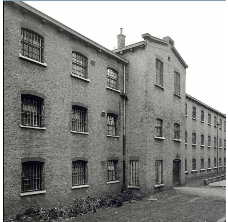
Afbeelding 11. Overzicht van de westelijke zijgevel in februari 1983. Het venster in de noordelijke zijgevel van de dwarsbeuk was hier nog niet dichtgezet, net als de drie ventilatieroostertjes tussen de tweede en derde vensteras van links. De schoorsteen op de kap van de dwarsbeuk was bedoeld ter afvoer van de rookgassen van de kachels van de onderliggende ruimten (zie Afbeelding 93 t/m Afbeelding 95). Foto: Collectie Beeldbank Leeuwarden, documentnr.: FDBLHSPLB051
