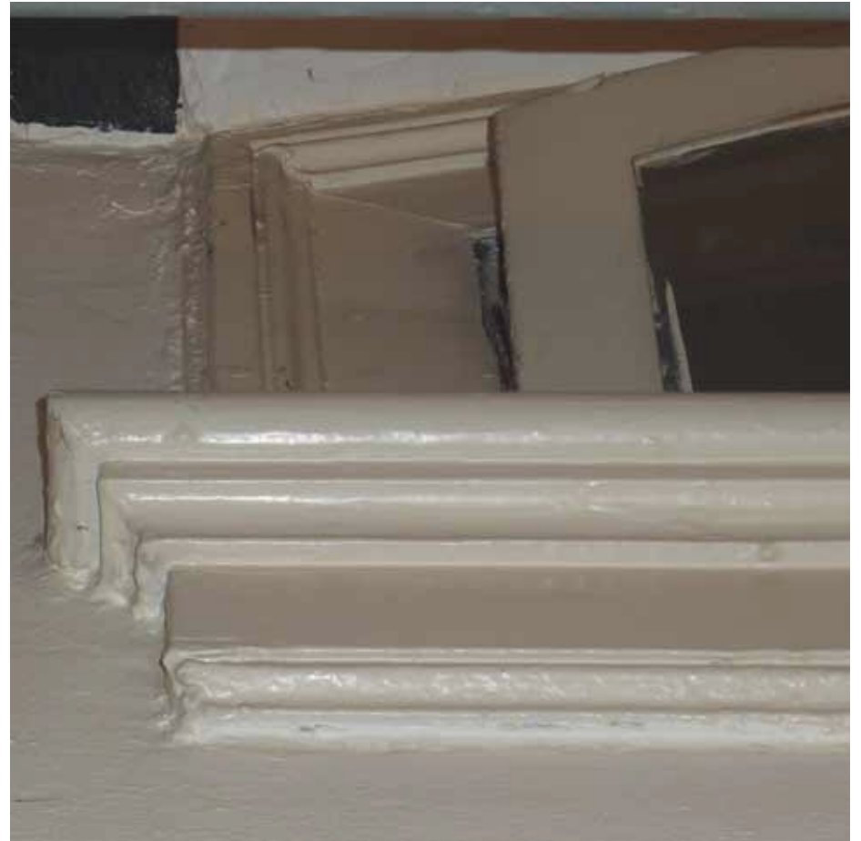
Afbeelding 69. Detail van de linker onderhoek van één van de hoog geplaatste vensters in de zuidwand. De vensters bezaten oorspronkelijk dezelfde hoogte als de gang op de eerste verdieping (ruimte N1.01), maar werden bij het verhogen van de achterliggende ruimten (1957) ingekort. De vensterbank werd hierbij herplaatst en het venster voorzien van een nieuw 5-ruits raam met platte stalen roeden (1957).
