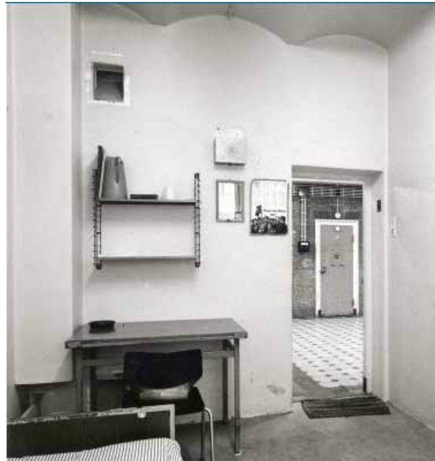
Afbeelding 46. Interieur van één van de cellen in bouwdeel F in februari 1983. Links zijn - onder het bureau en boven naast de schacht - de oorspronkelijke ventilatieopeningen nog zichtbaar (zie pagina 13, fase 1 en Afbeelding 102). Foto: Collectie Beeldbank Leeuwarden, documentnr.: FDBLHSPB020
