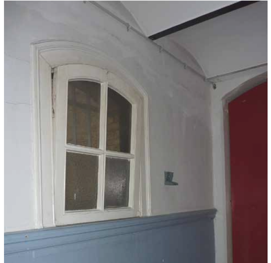
Afbeelding 77. Zicht op één van de vensters in de noordwand van het tweede gedeelte van de gang. Dit gedeelte is voorzien van een geschilderde lambrisering die door middel van een geprofileerde houten lijst wordt beëindigd. De vensters stammen uit de bouwtijd en zijn voorzien van geprofileerde architraaf-latten en naar binnen vallende 4-ruits vensters.
