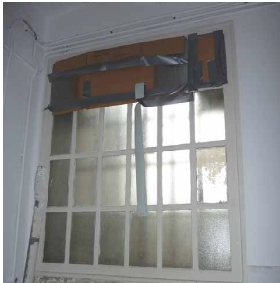
Afbeelding 66. Zicht op het venster in de zuidwand. Het venster (1957) bestaat uit een stalen 24-ruits raam met platte roeden aan zowel de binnen- als de buitenzijde van de buitenwand, met daartussen een luchtspouw.
