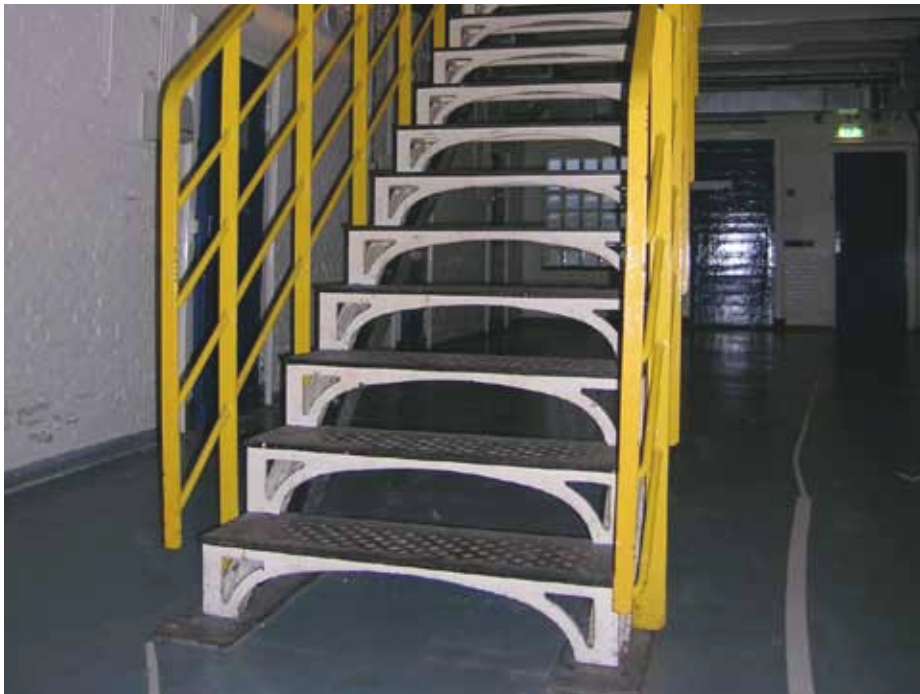
Afbeelding 21. Onderzijde van één van de trappen in de cellenhal. De trappen (1891) bestaan uit op stalen I-profielen bevestigde gegoten ijzeren driehoekige opengewerkte segmenten. De secundaire (1988) leuningen bestaan uit verticale stalen strips met onder de T-vormige handlijst een viertal horizontale ronde staven (rond 2 cm). Oorspronkelijk waren hier leuningen met slechts 2 horizontale tussenstaven (vergelijk Afbeelding 31).
