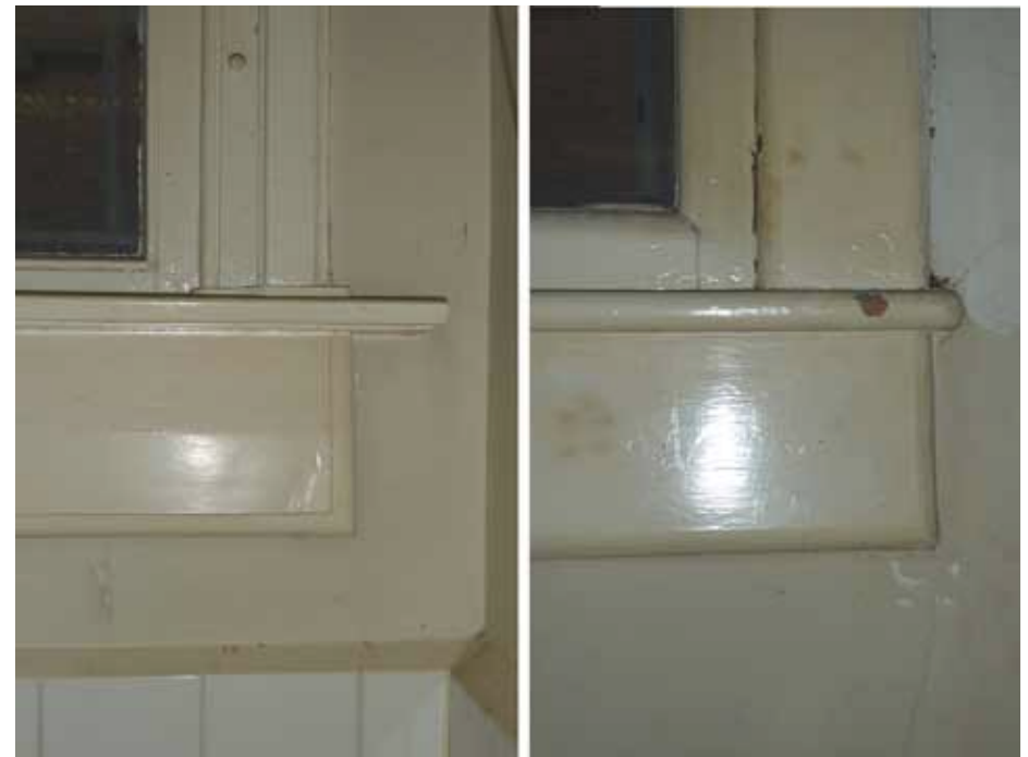
Afbeelding 55. Detail van de rechter onderhoek van het meest linker en één van de rechter vensters op de voorgaande afbeelding. Het linker venster bevond zich in de keuken van de bewaardster en kent een rijkere detaillering dan het eenvoudiger uitgevoerde venster in de voormalige ziekencel. Het linker venster bezit geprofileerde architraaflijsten die door middel van een houten neut aansluiten op de vensterbank.
