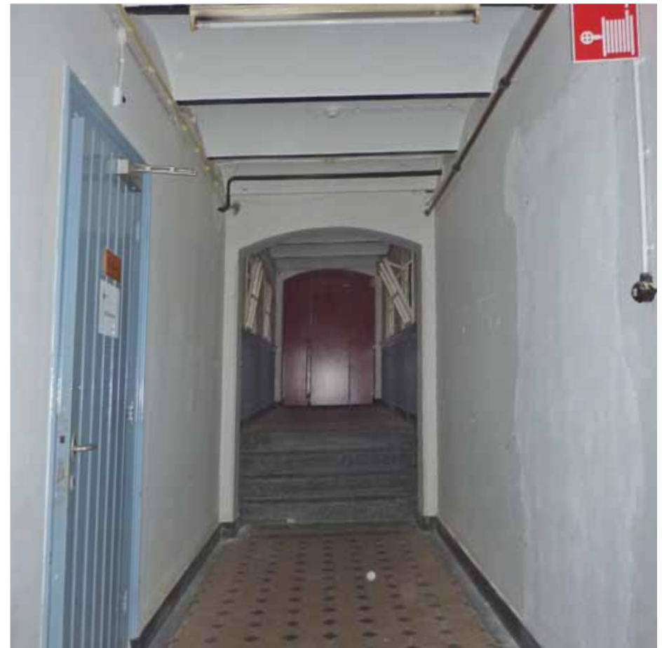
Afbeelding 75. Overzicht van ruimte N1.01 gezien richting het oosten (bouwdeel G). Het hoogte verschil tussen de verdiepingvloeren van beide bouwdelen wordt overbrugd door middel van vier massieve hardstenen treden. Rechts tekent zich de dichtgezette doorgang naar ruimte A1.27 af.
