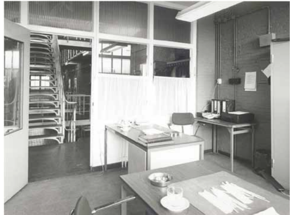
Afbeelding 29. Het bewaardersvertrek op de eerste verdieping aan de zuidzijde van de cellenhal in februari 1983, gezien richting het noorden. (vergelijk met Afbeelding 28) Foto: Collectie Beeldbank Leeuwarden, documentnr.: FD-BLHSPLB029.
