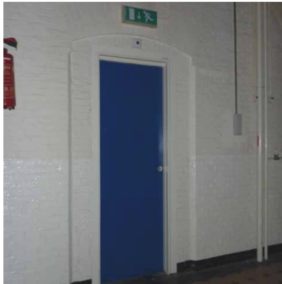
Afbeelding 38. De doorgang tot het voormalige trappenhuis (ruimte A2.28). De gemetselde doorgang is voorzien van vellingkanten, wordt afgesloten door een segmentboog en was mogelijk open (zie Afbeelding 109). In 1988 werd de doorgang versmald en voorzien van een deur.
