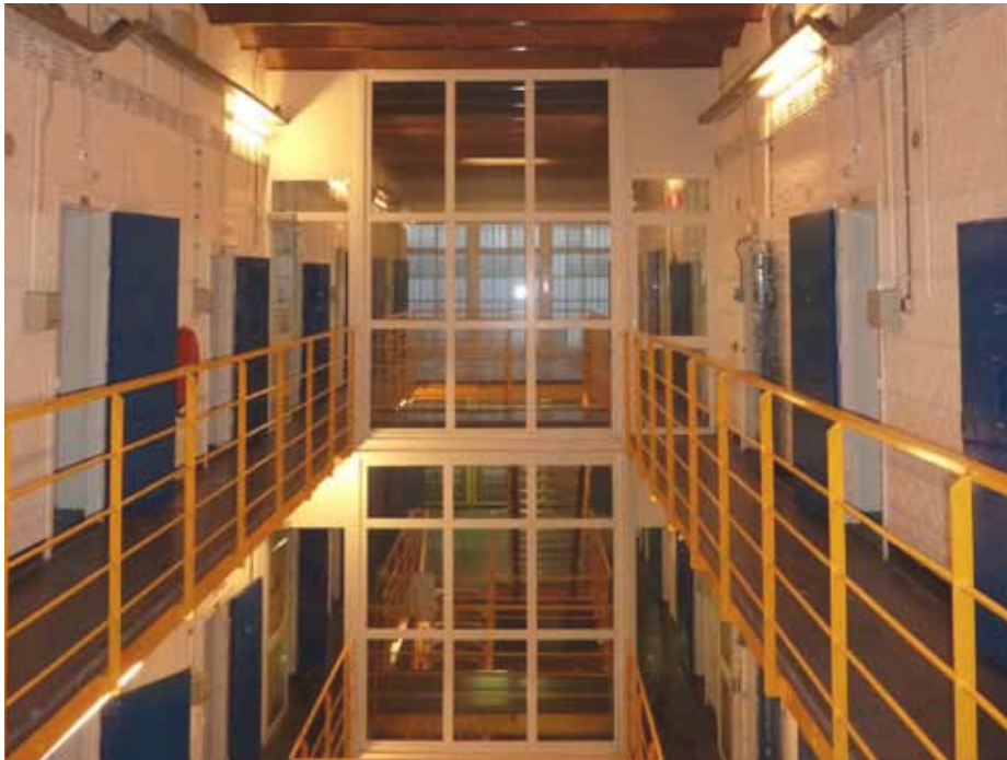
Afbeelding 30. Overzicht van de cellenhal in 2009. De scheidingswand (1997) op tweederde van de lengte deelt de cellenhal. Tijdens de verbouwing in 1988 werden de laatste gezamenlijke cellen in deze vleugel opgedeeld in individuele cellen, dit is duidelijk zichtbaar in het verschil in het aantal deuren dat op de galerijen uitkomt. (Vergelijk met Afbeelding 31).
