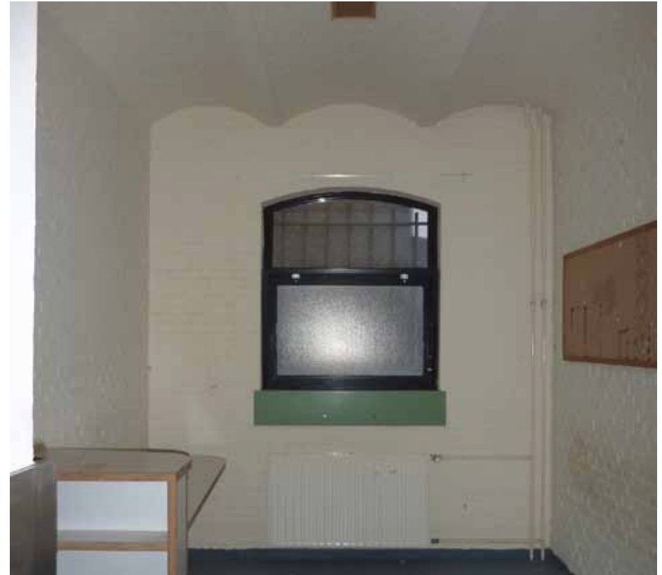
Afbeelding 44. Overzicht van ruimte A1.08 gezien richting de buitengevel. De van oorsprong gezamenlijke cellen bezaten de dubbele oppervlakte en werden door middel van troggewelfjes op stalen binten overspannen.
