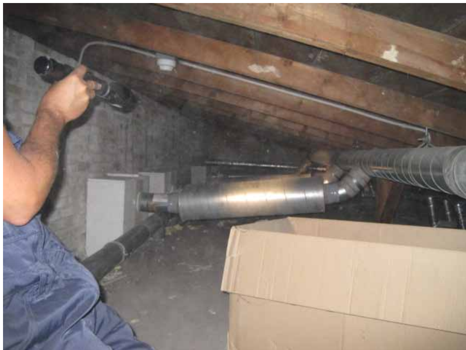
Afbeelding 84. Zicht in de kapconstructie boven de cellen met een moderne ventilatie-installatie. Foto: dhr. Bastiaans, Monumentenwacht Overijssel en Flevoland / Drenthe 2009.
