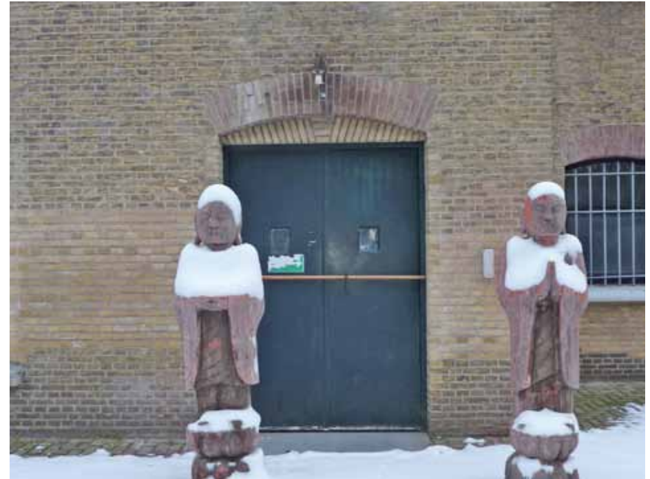
Afbeelding 17. Doorgang in de kopgevel van de westelijk dwarsbeuk. Oorspronkelijk bezat deze gevel ter hoogte van de begane grond een tweetal vensters ten behoeve van de verlichting van het achterliggende bewaardersvertrek. In het tweede kwart van de 20 ste eeuw werd het bewaardersvertrek gesplitst ten behoeve van het realiseren van een doorgang naar de binnenplaats tussen de bouwdelen E en F. De vlakke deuren met geprofileerde naald en siermetselwerk onder de segmentboog werden aangebracht.
