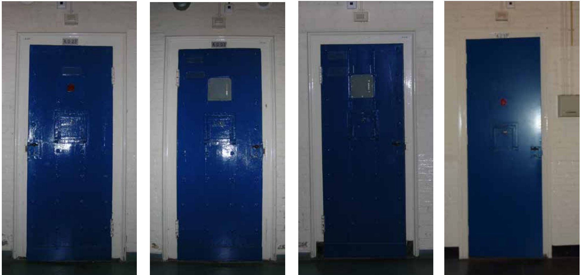
Afbeelding 25. Overzicht van de verschillende typen celdeuren in bouwdeel F. Geheel links een celdeur uit de bouwtijd met een kijkgat, schaftklep en (naam)kaartje. De deur rechts daarvan werd recent voorzien van een groter kijkgat met klep (1997?), die behalve bij de deuren van cellen A0.23 en A0.24 op de gehele begane grond werd aangebracht. In het tweede kwart van de 20 ste eeuw werden op de begane grond de gezamenlijke cellen aan de zuidzijde gesplitst tot individuele cellen (cellen A0.06 t/m A0.21). Hierbij plaatste men op de oorspronkelijke toegangen geïnspireerde deuren (derde deur van links), echter met toepassing met hardstenen neutjes onder de stijlen van de kozijnen. Vervolgens werden in 1964 op de eerste en tweede verdieping de cellen zuidelijk van de kruising gesplitst (zie Afbeelding 109 en Afbeelding 110) en in 1988 de overige cellen (zie Afbeelding 112 en Afbeelding 113). In 1964 werd nog gekozen voor een detaillering die min of meer gelijk was aan de uit de bouwtijd afkomstige deuren, maar in 1988 koos men voor een eenvoudiger vormgeving, zonder geprofileerde architraaflossen en gemetselde hanekam (geheel rechts).
