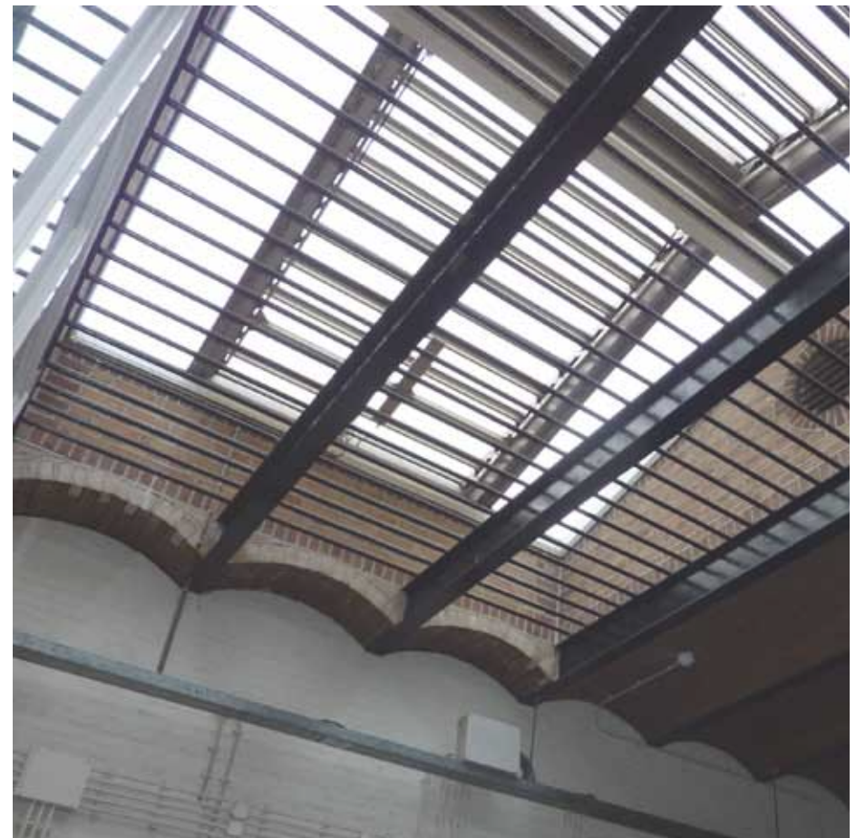
Afbeelding 24. Zicht op de onderzijde het secundaire daklicht (1964). De kopschotten bestaan uit schoon metselwerk met geknipte voegen, echter in een van het overige werk afwijkende steen. Ter plaatse van de troggewelfjes geeft de lichtere kleur van de bakstenen aan dat de stenen werden ingezaagd. Aan beide zijden is één van de drie ramen voorzien van ventilatieschoepen (1988), de overige ramen bezitten draadglas.
