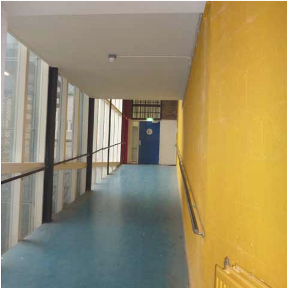
Afbeelding 80. Overzicht van ruimte A1.09 gezien richting het westen. De verbindingsgang werd in 1988 gerealiseerd ten behoeve van het verbeteren van de routing binnen het complex.
