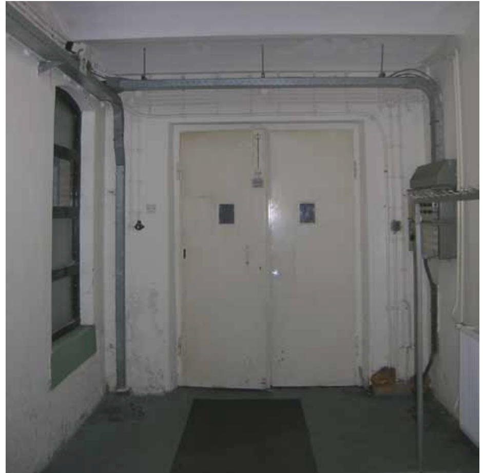
Afbeelding 60. Overzicht van doorgang A0.36 gezien richting de buitengevel (westen).
