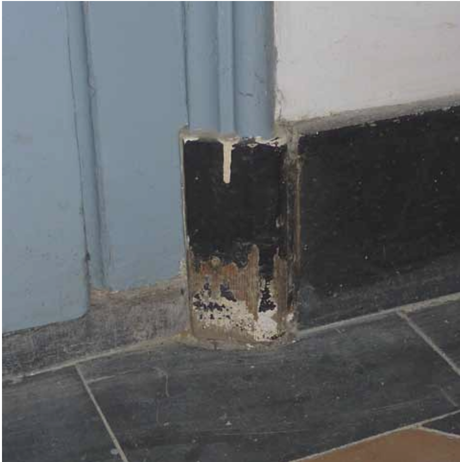
Afbeelding 76. Onderdetail van één van de doorgangen in de gang. De architraaflijsten sluiten aan de onderzijde aan op houten neuten.
