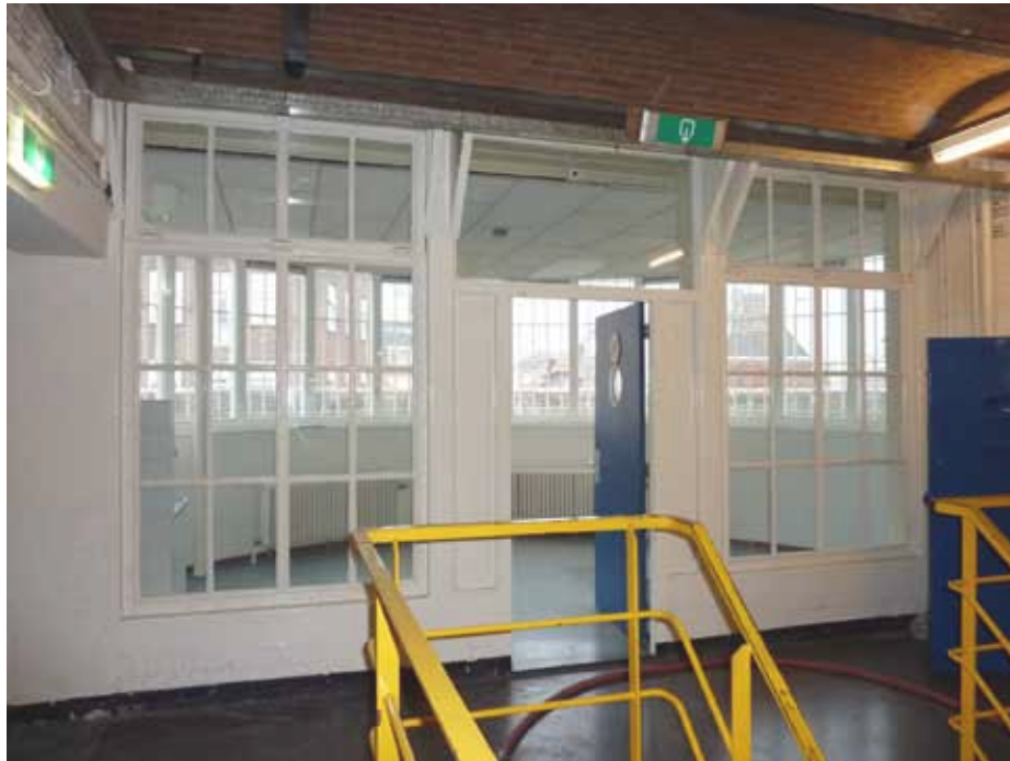
Afbeelding 26. Zicht op de pui in de noordelijke kopgevel ter hoogte van de eerste verdieping. Links en rechts zijn de oorspronkelijke stalen ramen, bestaande uit 16-ruits vaste onder- en 4-ruits naar binnen vallende bovenramen, nog aanwezig. Het middelste gedeelte van het venster werd vervangen (1988) door een houten pui die toegang geeft tot de achterliggende toezichtruimte (A1.26).
