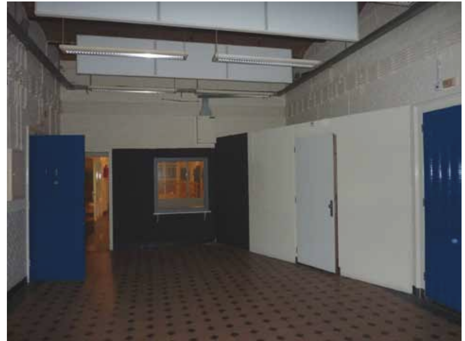
Afbeelding 34. Overzicht van ruimte A2.27 gezien richting het zuiden (cellenhal). In tegenstelling tot de vloer van cellenhal A0.29, werd deze vloer niet voorzien van een gietvloer. Rechts is een driehoekige bergruimte aangebracht (1997).
