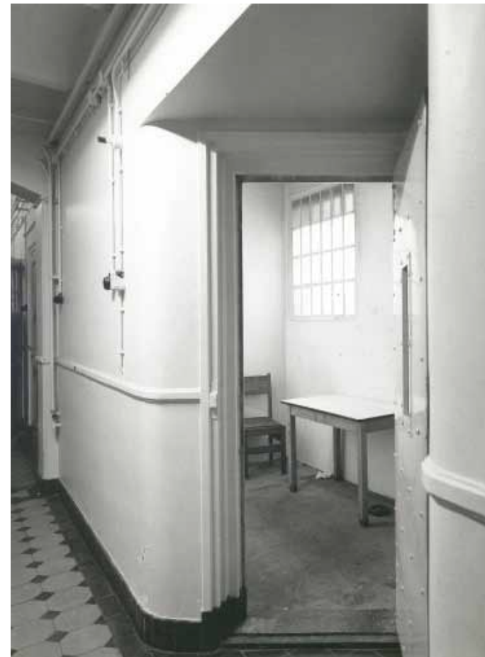
Afbeelding 71. Zicht op de ingang van de zuidelijke strafcel in februari 1983. De binnenwanden van deze in 1957 gewijzigde cellen tekenen zich nog af op de troggewelven van ruimten N0.03 en A0.37. De lambrislijsten op de wanden werden eveneens bij deze verbouwing aangebracht. Foto: Collectie Beeldbank Leeuwarden, documentnr.: FDBLHSP1B012.
