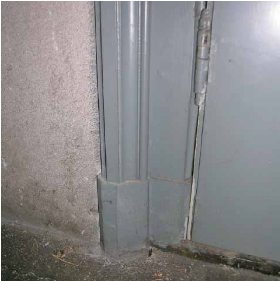
Afbeelding 54. Zicht op de onderzijde van één van de deuren op de zolder. De doorgangen en de afwerkingen daarvan stammen uit de bouwtijd, maar de deuren werden later van triplex beplating voorzien en jaren '50 hang- en sluitwerk.
