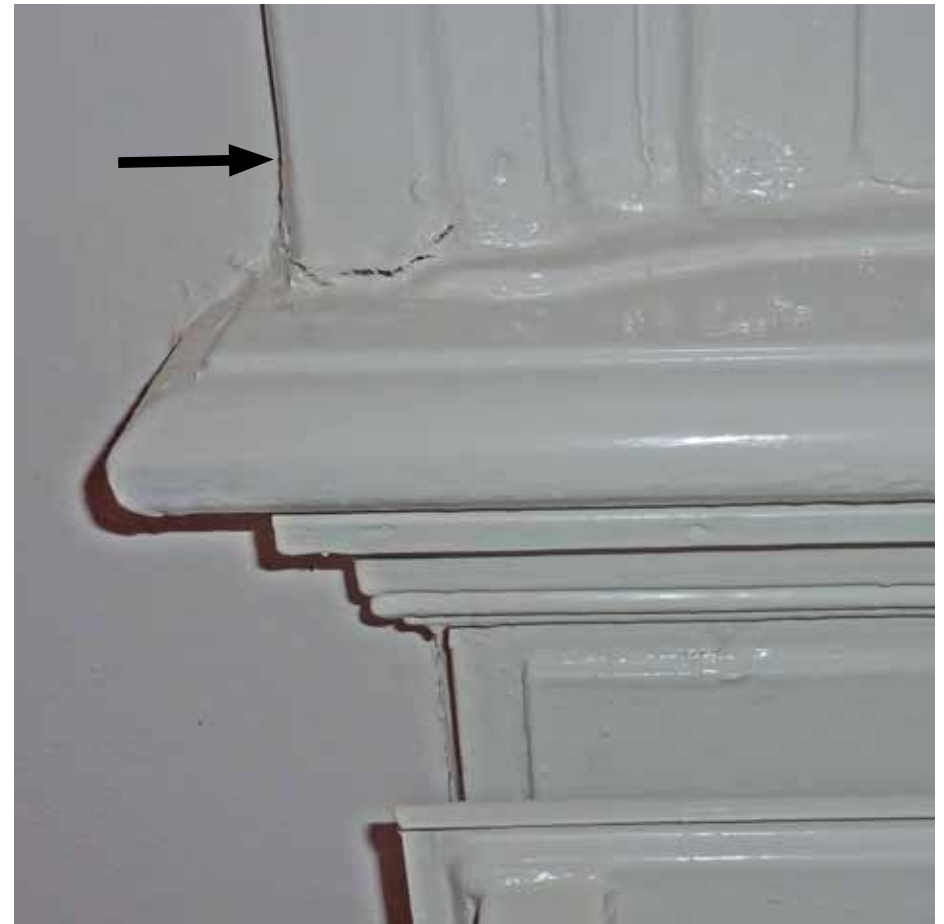
Afbeelding 32. Detail linker onderhoek van één van de schuifvensters. De vensters zijn voorzien van geprofileerde architraaflijsten die door middel van houten neuten aansluiten op de vensterbanken. De lijsten zijn voorzien van extra aftimmerlatten ter aansluiting op de voorzetwanden. Ter hoogte van de borstwering zijn lambriseringen met bossingpanelen aangebracht. Hier zijn de bossingpanelen door vlakke platen aan het zicht onttrokken.
