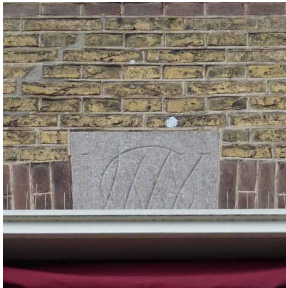
Afbeelding 8. Zicht op de sluitsteen in de beëindiging van het middelste venster ter hoogte van de eerste verdieping van de oostelijke kopgevel. Het hardstenen blok is voorzien van een monogram 'W' 'C' 'M', W.C. Metzelaar.
