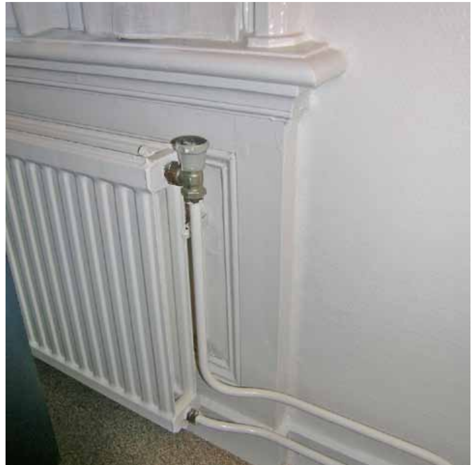
Afbeelding 67. Zicht op de onderzijde van één van de vensters in de verblijfsruimten op de verdieping. De vensters zijn voorzien van geprofileerde architraaflijsten die door middel van houten neuten aansluiten op de vensterbanken. Ter hoogte van de borstwering zijn lambriseringen met bossingpanelen aangebracht. Op verschillende plaatsen zijn de bossingpanelen door vlakke platen aan het zicht onttrokken of is de lambrisering geheel verwijderd.
