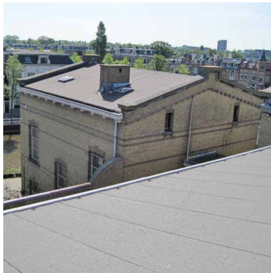
Afbeelding 6. Overzicht van het bovenste gedeelte van de west- en noordgevel. De zuidgevel wordt grotendeels aan het zicht onttrokken door de verbindinggang tussen de bouwdelen G en F. De gevel is blind op twee vensters ter hoogte van de tweede verdieping na. De grote schoorsteen op het noordelijke dakvlak werd in 1957 aangebracht bij het realiseren van een cv-ruimte op de begane grond. Foto: dhr. Bastiaans, Monumentenwacht Overijssel en Flevoland / Drenthe 2009.
