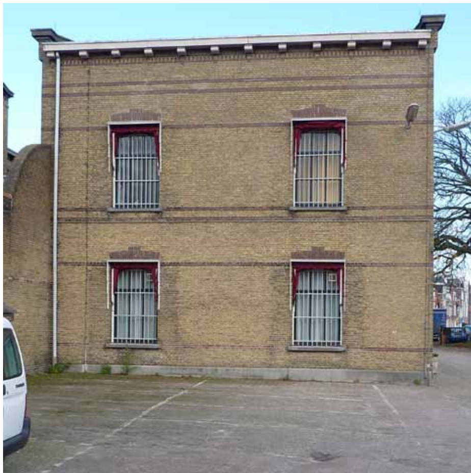
Afbeelding 5. Overzicht van de zuidgevel. De hardstenen goot is hier - in tegenstelling tot de ongeschilderde goten van de andere bouwdelen - wit geschilderd. Links en rechts van de schuifvensters op de begane grond is het metselwerk vervuld.
