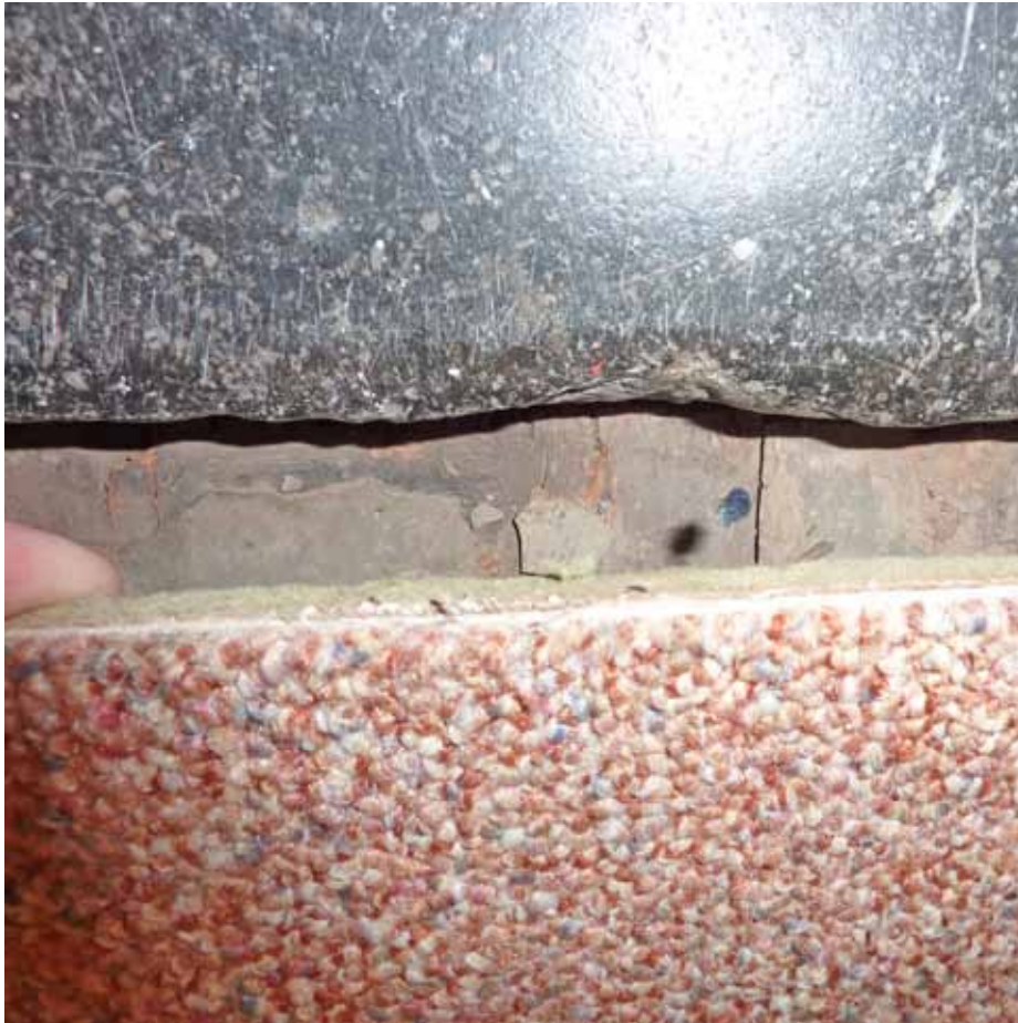
Afbeelding 34. Zicht op de houten vloer onder de huidige vloerafwerkingen ter plaatse van de hardstenen dorpel. De vloerdelen bezitten een werkende breedte van 9 cm en zijn voorzien van zachtboard en vloerbedekking.
