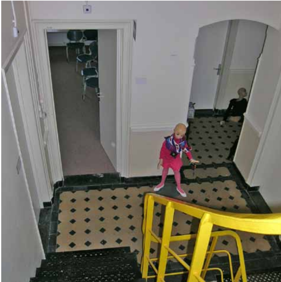
Afbeelding 20. Zicht op de overloop van de eerste verdieping. De tegelvloer is voorzien van een zwarte border en sluit aan op de wanden door middel van een hardstenen plint. Op de wanden zijn lambriseringslijsten (1891, Afbeelding 23) aangebracht en de hoeken van de doorgangen zijn beschermd middels houten gedraaide hoekbeschermers (1891).
