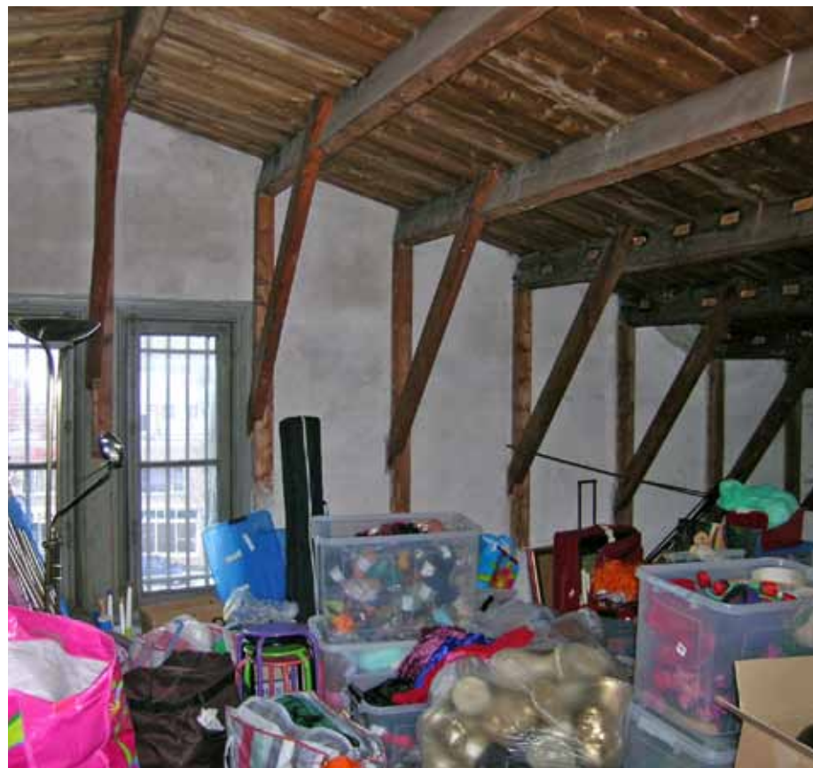
Afbeelding 51. Overzicht van ruimte N2.04 gezien richting het oosten.
