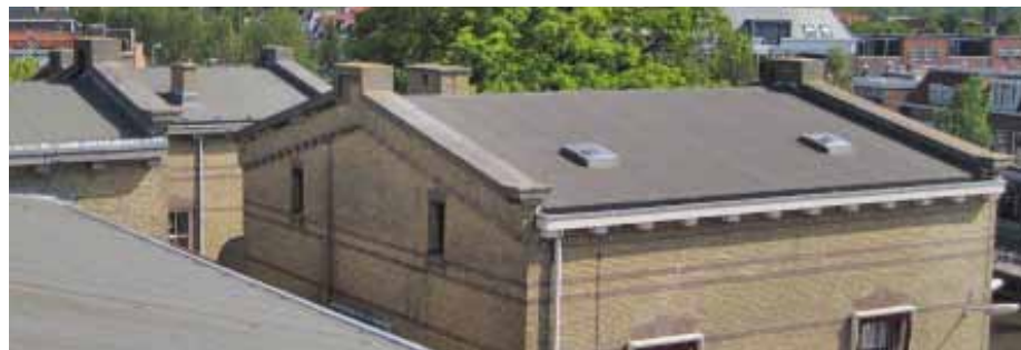
Afbeelding 59. Recente afbeelding van de kap van bouwdeel G. De zinken dakbedekking werd vervangen door bitumen en de zinken dakvensters door kunststof lichtkoepels. Foto: dhr. Bastiaans, Monumentenwacht Overijssel en Flevoland / Drenthe 2009.
