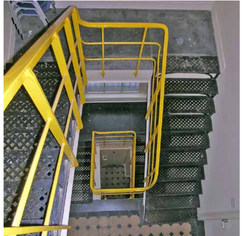
Afbeelding 21. Overzicht van het trappenhuis vanaf de zolder. De vloeren van de begane grond en eerste verdieping bestaan uit tegels, de vloer van de tweede verdieping is gecementeerd. De bordessen zijn opgebouwd uit hardsteen platen. Deze trap is - in tegenstelling tot de gietijzeren trappen in de cellenhallen van de bouwdelen F en I - nog voorzien van de oorspronkelijke leuning (zie Afbeelding 22).
