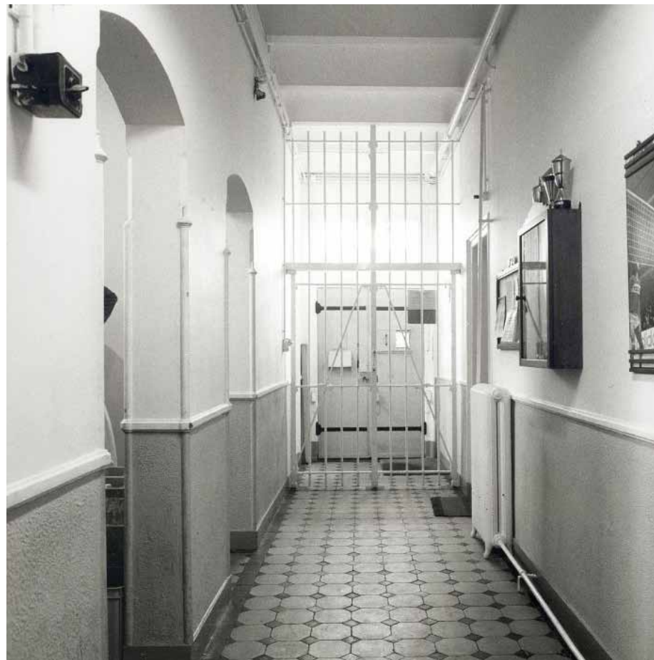
Afbeelding 66. Zicht op de gang ter hoogte van de begane grond in februari 1983, gezien richting het oosten. De achterste twee toiletruimten waren reeds aanwezig, maar de twee doorgangen waren nog open. Foto: Collectie Beeldbank Leeuwarden, documentnr.: FDBLHSP009.
