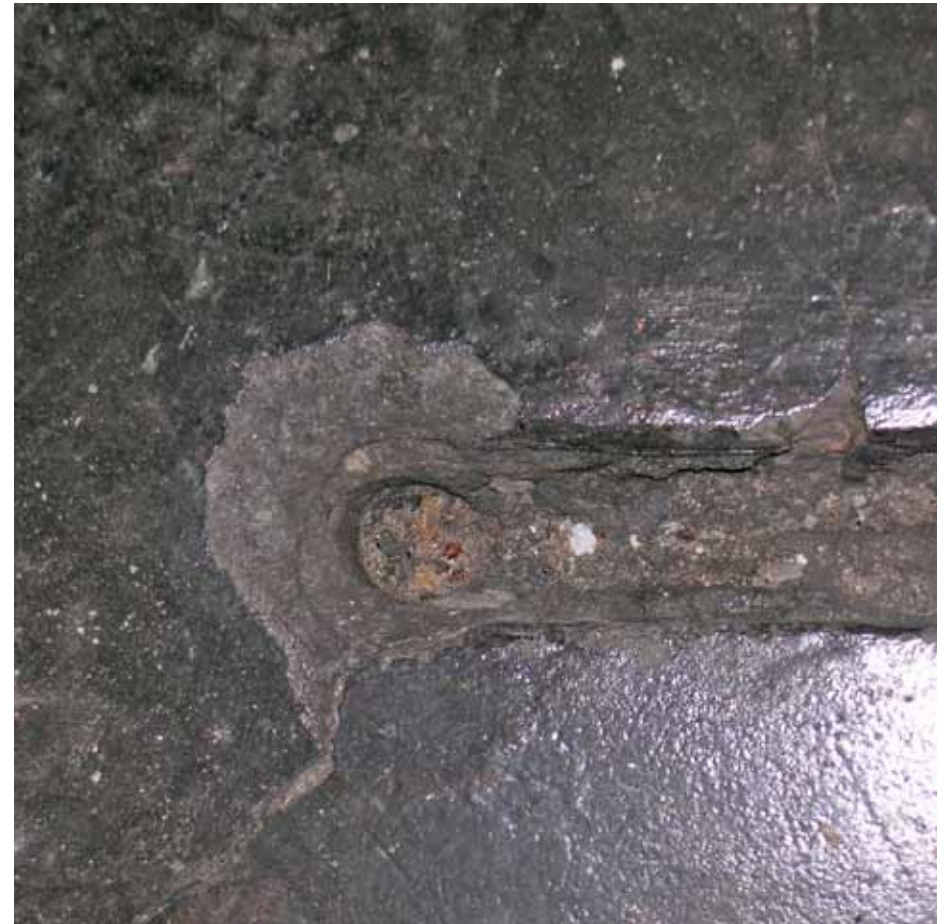
Afbeelding 53. Zicht op één van de sleuven in de cementvloer van de zolder. De sleuven zijn vermoedelijk aangebracht ten behoeve van het bevestigen van schotten of stellages.
