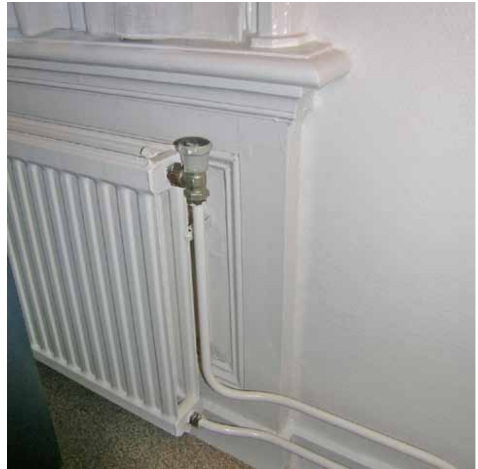
Afbeelding 41. Zicht op de onderzijde van één van de vensters. De vensters zijn voorzien van geprofileerde architraaflijsten die door middel van houten neuten aansluiten op de vensterbanken. Ter hoogte van de borstwering zijn lambriseringen met bossingpanelen aangebracht. Op verschillende plaatsen zijn de bossingpanelen door vlakke platen aan het zicht onttrokken of is de lambrisering geheel verwijderd, maar hier zijn ze nog in het zicht.
