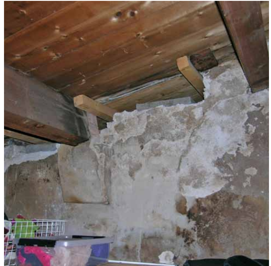
Afbeelding 57. Zicht op de aansluiting van het rookkanaal aan de zuidzijde. De gordingen worden ter plaatse van het kanaal opgevangen door consoles. Het bovendakse gedeelte van de schoorstenen werd verwijderd, waarbij het dakbeschoot werd aangeheeld.
