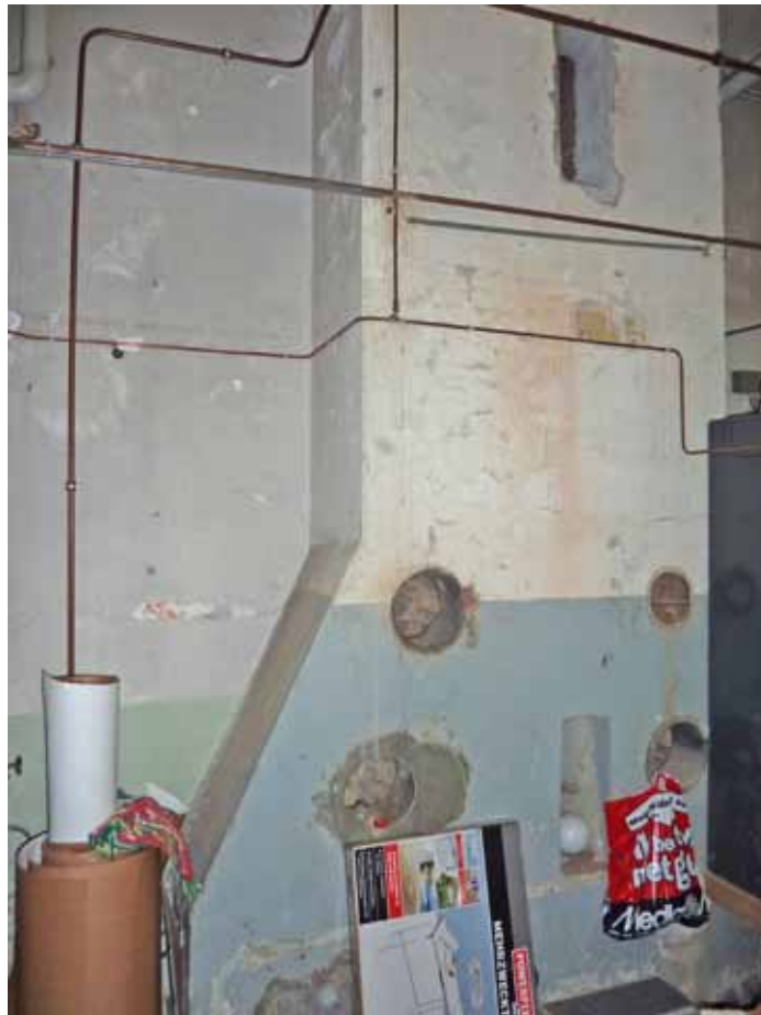
Afbeelding 37. Ten behoeve van de rookgasafvoer werd het rookkanaal aangepast (1957) en werd de grote schoorsteen op het noordelijke dakvlak aangebracht. In het kanaal zijn diverse doorvoeren aangebracht, die bij het wijzigen van de installatievoorzieningen hun functie verloren.
