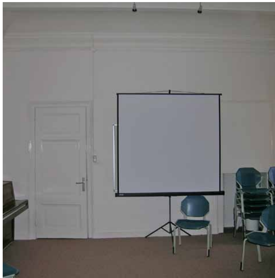
Afbeelding 42. Overzicht van de noordwand van de ruimte. Links bevindt zich de oorspronkelijke paneeldeur, rechts de toegang tot de vaste kast, die tijdens of vrij snel na de bouw werd aangebracht (XIXd). De deur van de kast is verwijderd, maar het kozijn met omlijsting is nog aanwezig.
