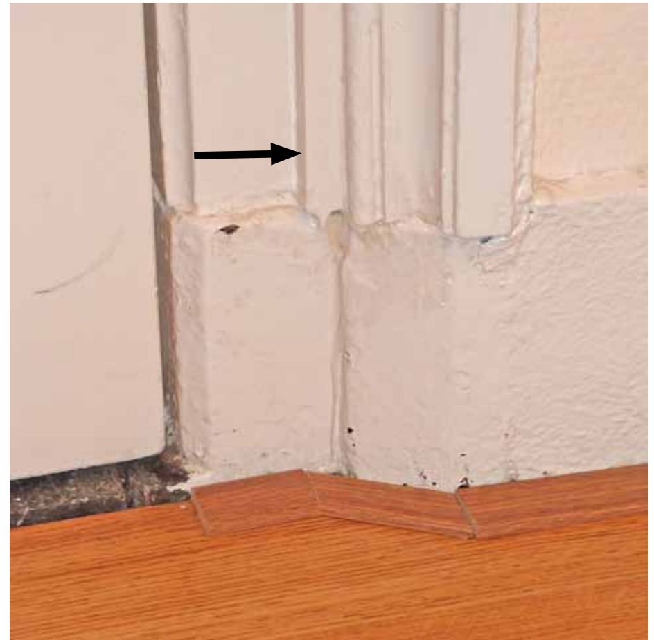
Afbeelding 29. Detail rechter onderhoek van het kozijn op de voorgaande afbeelding. De geprofileerde aftimmerlijsten (1891) werden gedemonteerd en op een extra lat (pijl) herplaatst, waardoor deze niet meer aansluit op de hardstenen neut. Mogelijk hield dit verband met een nieuwe wandafwerking.
