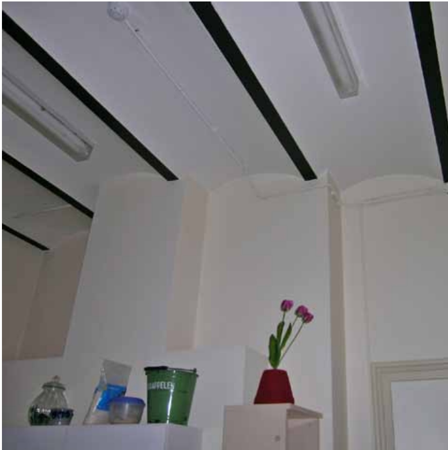
Afbeelding 49. Zicht op het rookkanaal op de oostwand van de ruimte. Het oorspronkelijke kanaal (1891) rechts werd in 1957 uitgebreid (links) ten behoeve van het afvoeren van de rookgassen van de nieuwe cv-installatie. Recent (1988) werd voor de kanalen een keukenblokje geplaatst.
