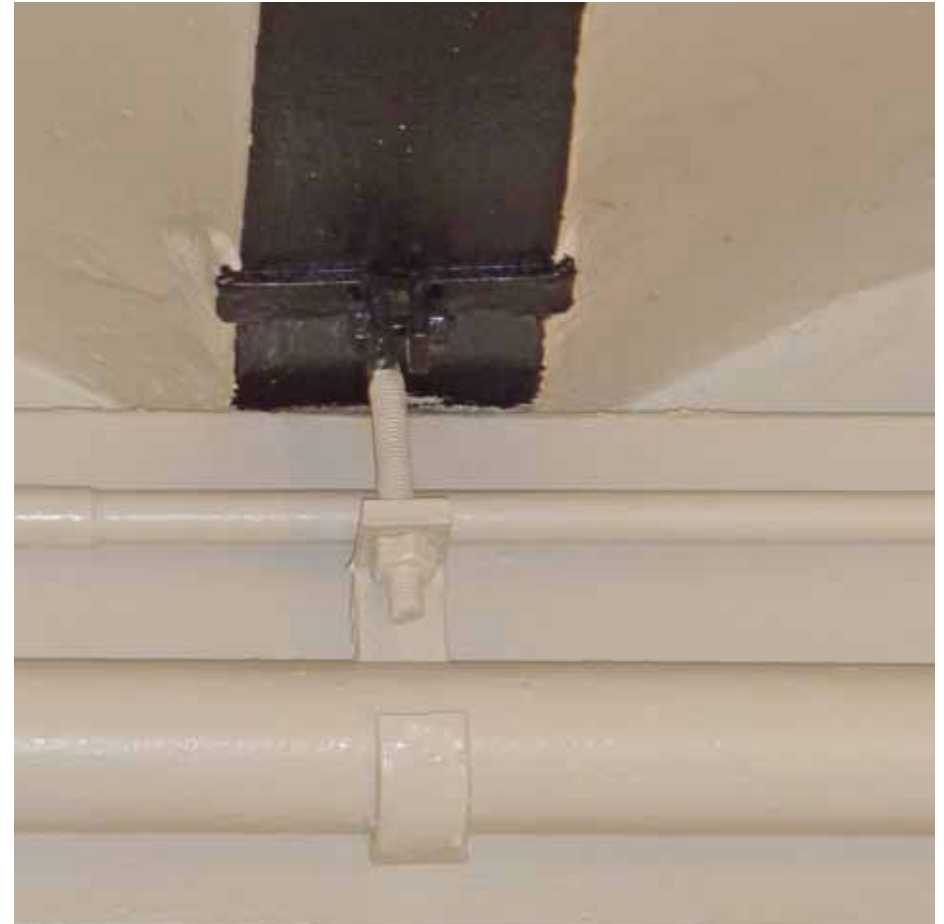
Afbeelding 35. Detail van één van de binten. Op de ligger zijn beugels aangebracht ter bevestiging van de verwarmingsbuizen (1957).
