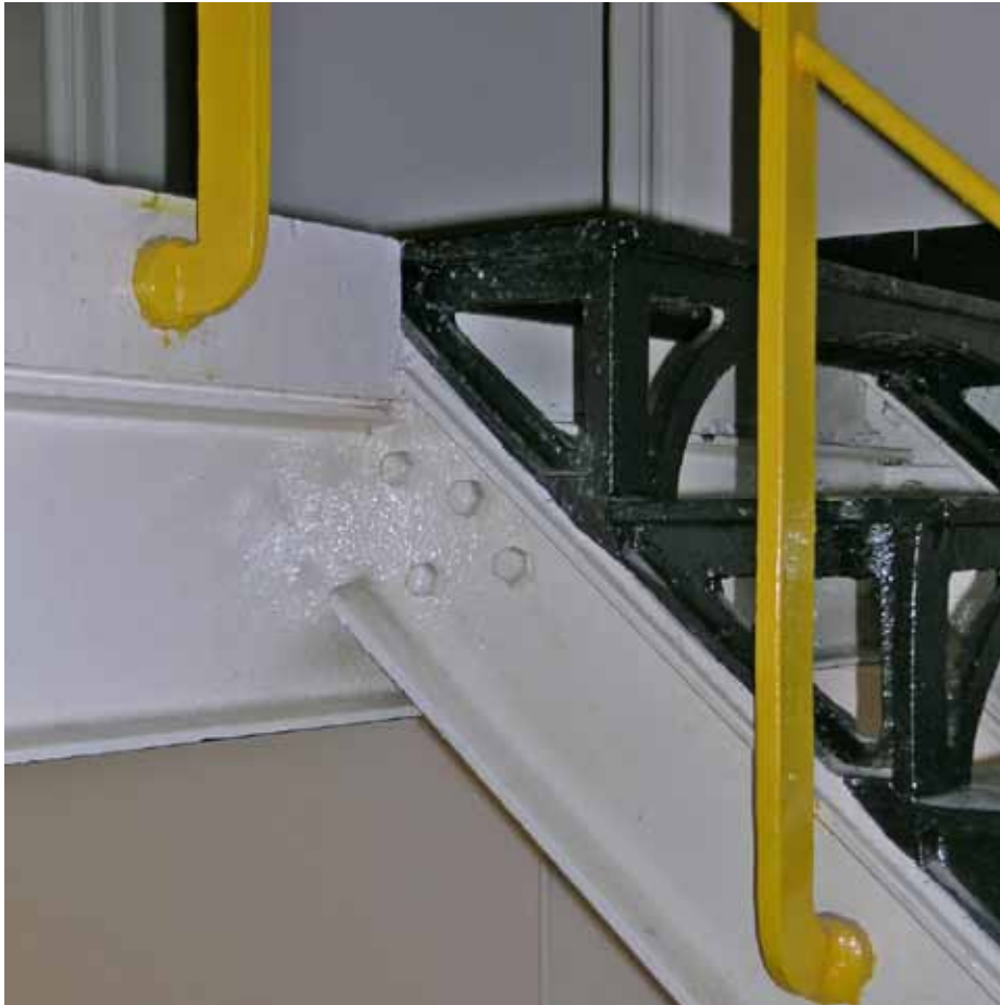
Afbeelding 22. Zicht op de aansluiting van de trap op één van de bordessen. De handlijst bestaat uit een T-ijzer van 35 x 35 x 5 mm, de stijlen uit strips van 45 x 15 mm met bevestigingen van rond 60 mm en de horizontale staven bezitten een doorsnede van 15 mm.
