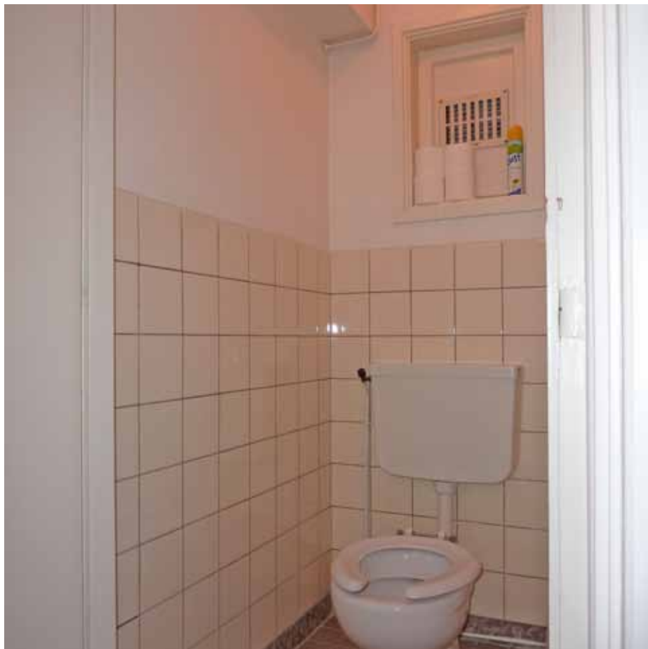
Afbeelding 25. Zicht in het toilet N0.10 met voorruimte, die vermoedelijk in de jaren 1960 werden gerealiseerd ter plaatse van het oorspronkelijke urinoir. Het 1-ruits venster in de noordgevel werd hierbij voorzien van een ventilatierooster. De vloer werd in de jaren '90 vernieuwd, vermoedelijk in verband met het doortrekken van de riolering naar toilet N0.11.
