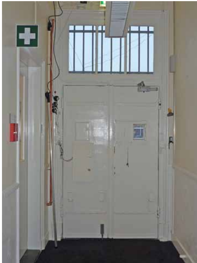
Afbeelding 15. Zicht op de toegangsdeur in de oostgevel. De deuren zijn middels zware gehengen aan de met geprofileerde lijsten afgewerkte kozijnen bevestigd. Het linker kijkluikje is mogelijk oorspronkelijk, het rechter luik werd later voorzien van een schuivende afdekking.
