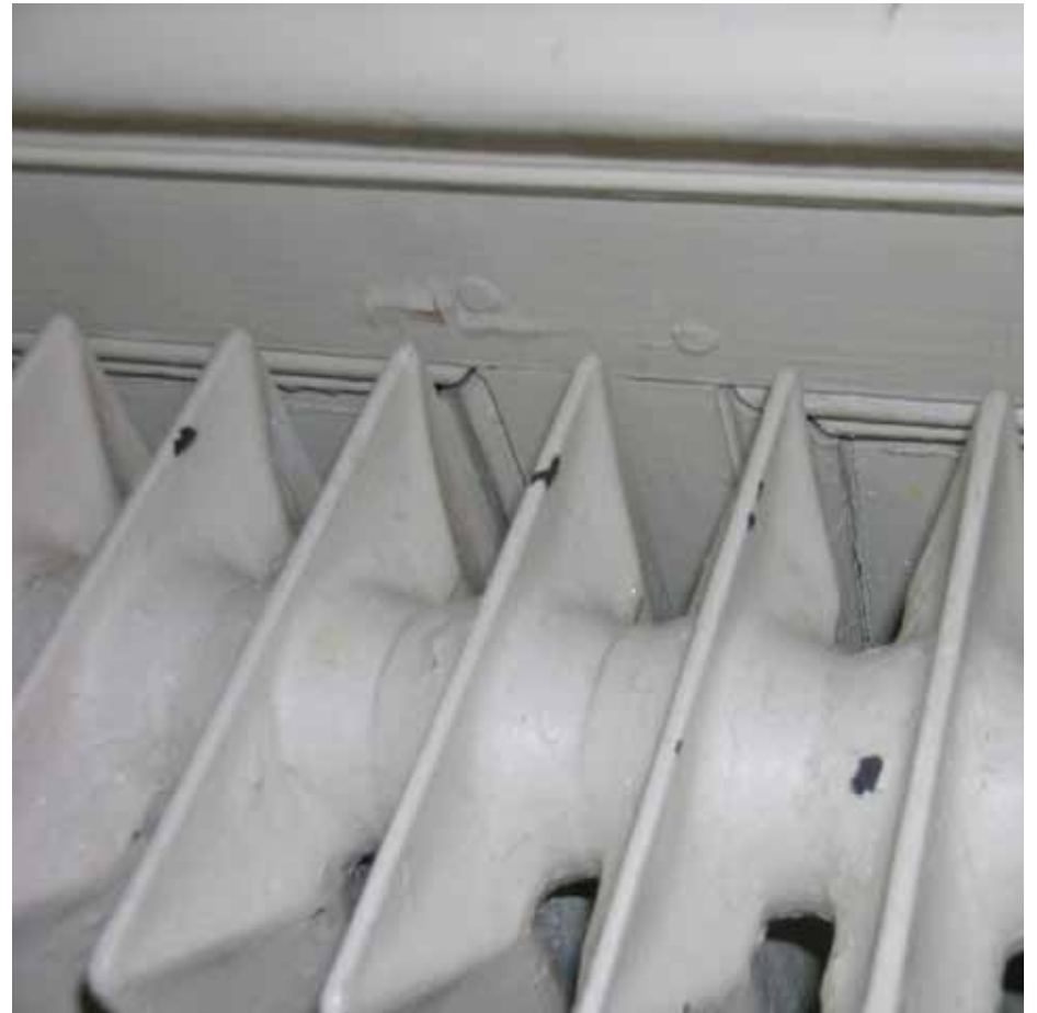
Afbeelding 50. Zicht op de bovenzijde van de lambrisering onder het venster in de noordwand. De lambrisering is voorzien van twee bossingpanelen, die op verschillende plekken aan het zicht zijn onttrokken door secundaire beplating.
