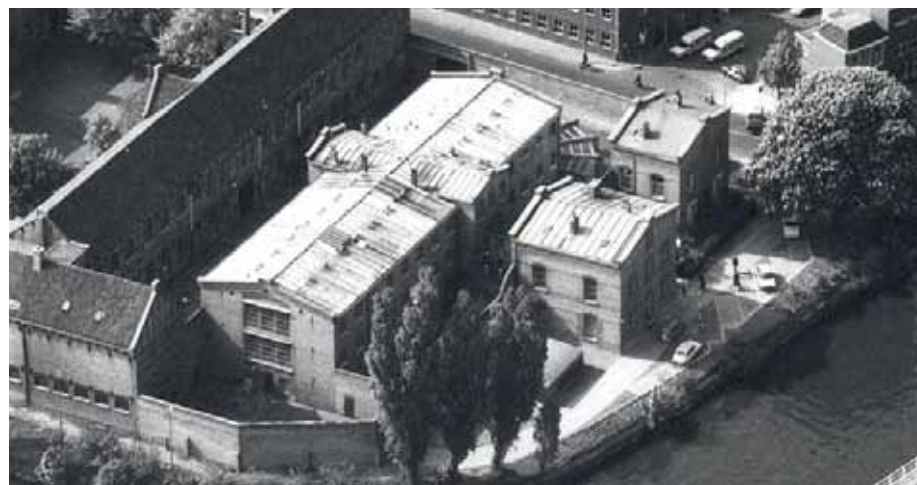
Afbeelding 58. Op deze luchtfoto uit mei 1978 is duidelijk te zien dat zowel de bouwdeelen F als G nog een zinken roevendak bezaten. Het dak van bouwdeel H was reeds vervangen door bitumen. Foto: Collectie Beeldbank Leeuwarden, documentnr.: FDLUCHTFB007.
