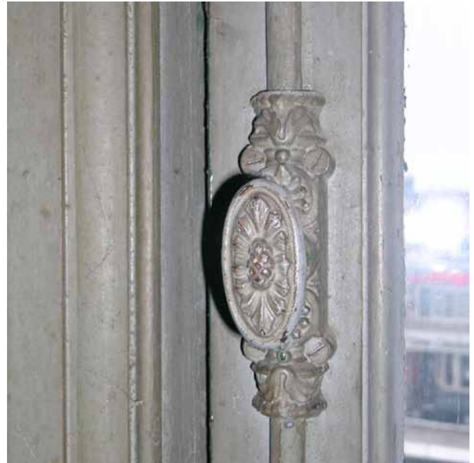
Afbeelding 55. Zicht op de knop van het spanjolet op het venster in de oostwand van ruimte N2.04. De aftimmering van de vensters op de zolder is eenvoudiger uitgevoerd dan op de begane grond en eerste verdieping, maar de vensters zijn wel voorzien van verzorgd vormgegeven hang- en sluitwerk.
