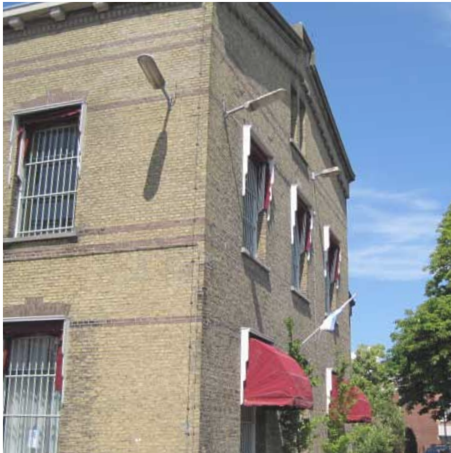
Afbeelding 60. Overzicht van het exterieur van bouwdeel G, gezien vanuit het zuiden. Op zowel de oost- als de zuidgevel zijn grote armaturen aangebracht. Foto: Dhr. Bastiaans, Monumentenwacht Overijssel en Flevoland / Drenthe 2009.
