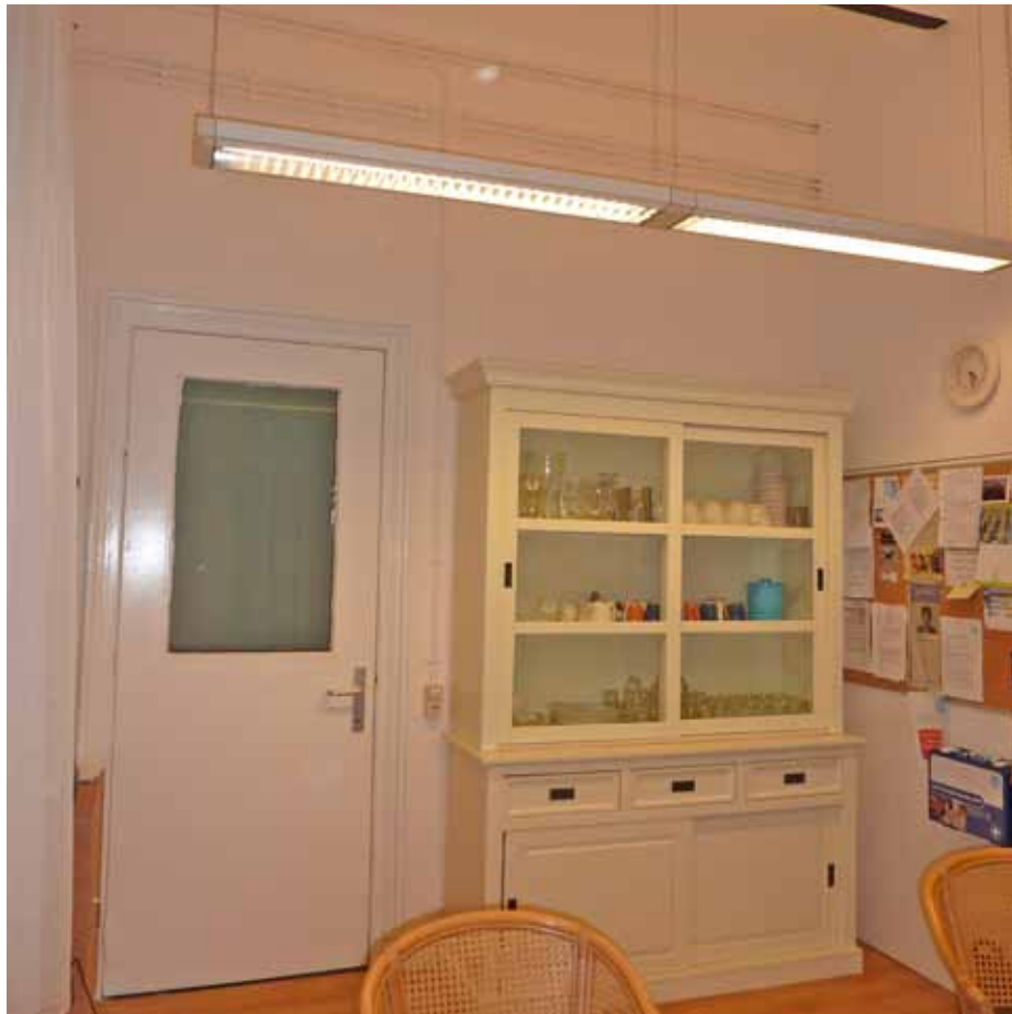
Afbeelding 28. Overzicht van de ruimte gezien richting het zuiden. De linker deur is secundair (XXc) geplaatst in een oudere doorgang. Oorspronkelijk bevond zich ook rechts een doorgang die uitkwam aan de andere zijde van het hek in de gang (Afbeelding 16). Deze doorgang werd tussen 1967 en 1976 dichtgezet.
