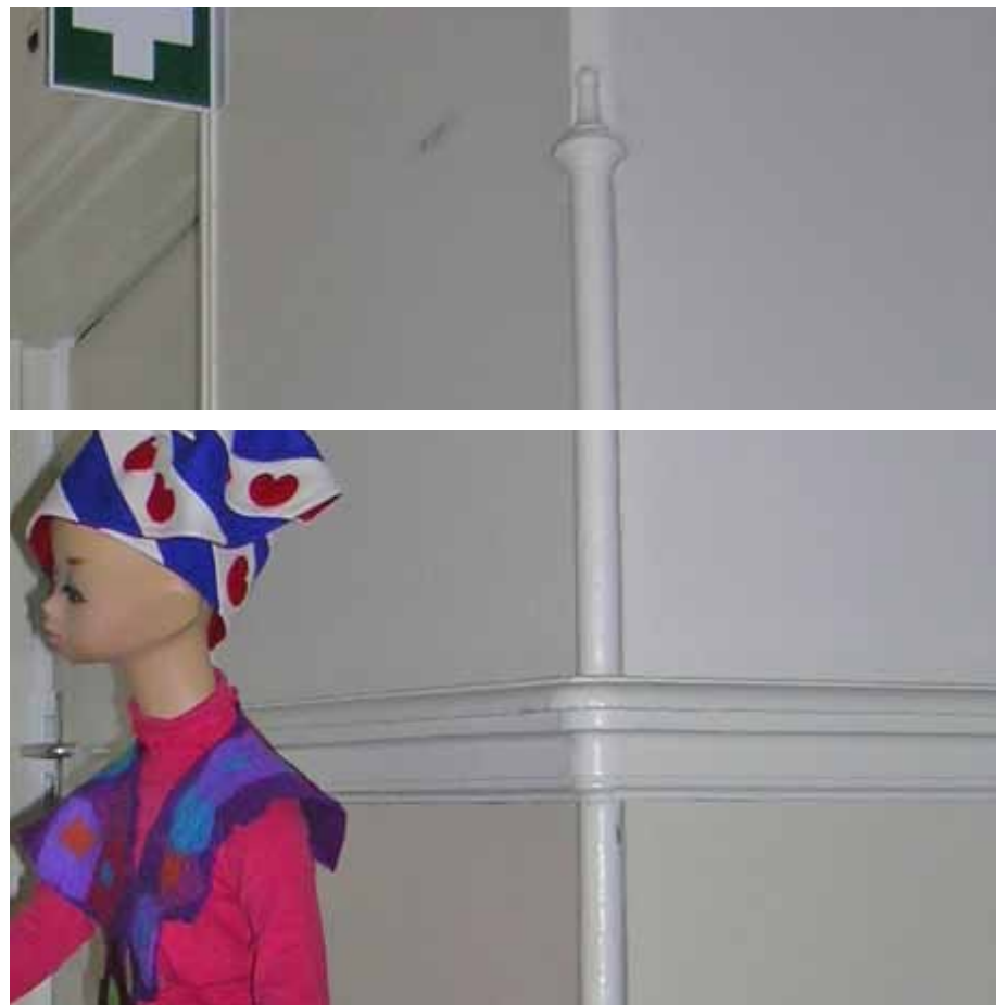
Afbeelding 64. Zicht op de hoek van de doorgang naar het tweede gedeelte van de gang ter hoogte van de eerste verdieping. Langs de wanden werden geprofileerde lambriseringslijsten aangebracht, waarbij de hoeken van de doorgangen werden voorzien van hoekbeschermers.
