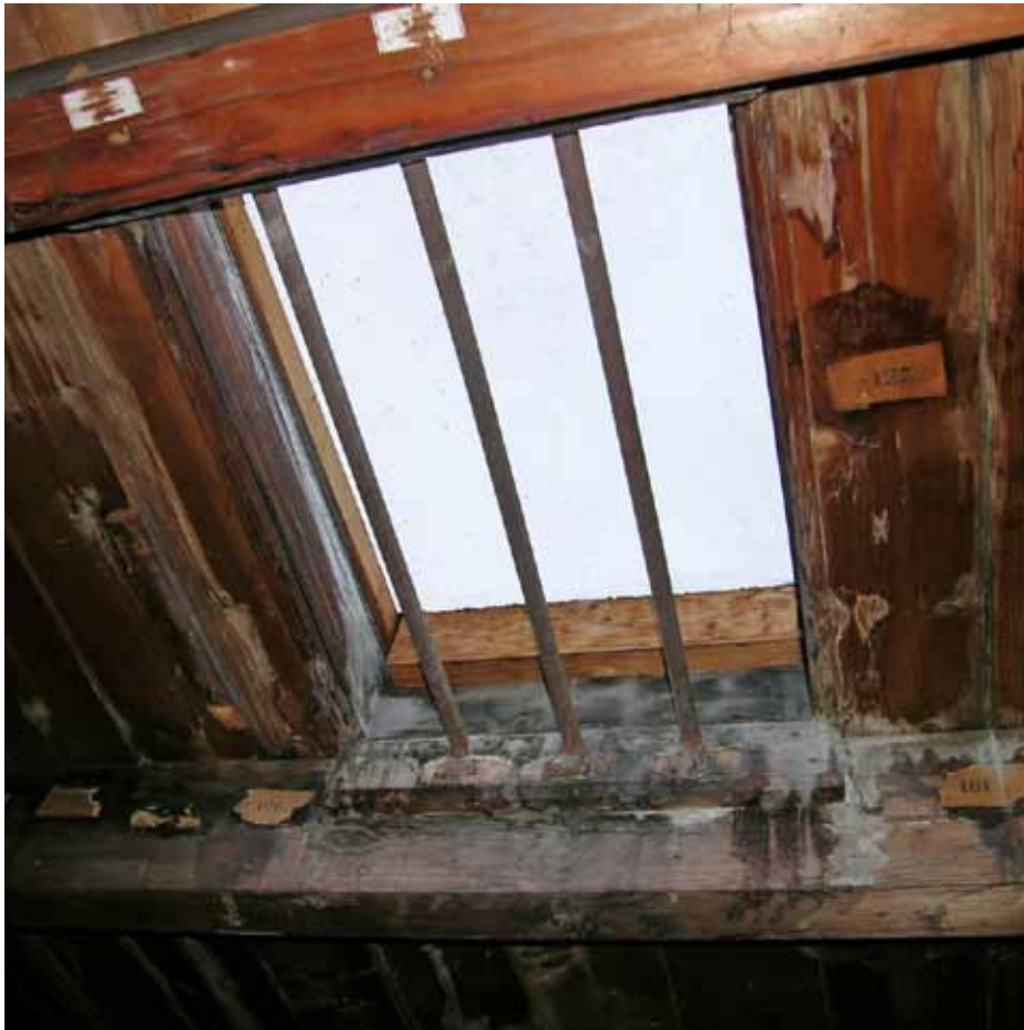
Afbeelding 56. Zicht op één van de dakvensters. De vensters zijn aan de binnenzijde voorzien van tralies en de kunststof koepel aan de buitenzijde is secundair. Op de gordingen en het dakbeschoot zijn nummertjes aangebracht.
