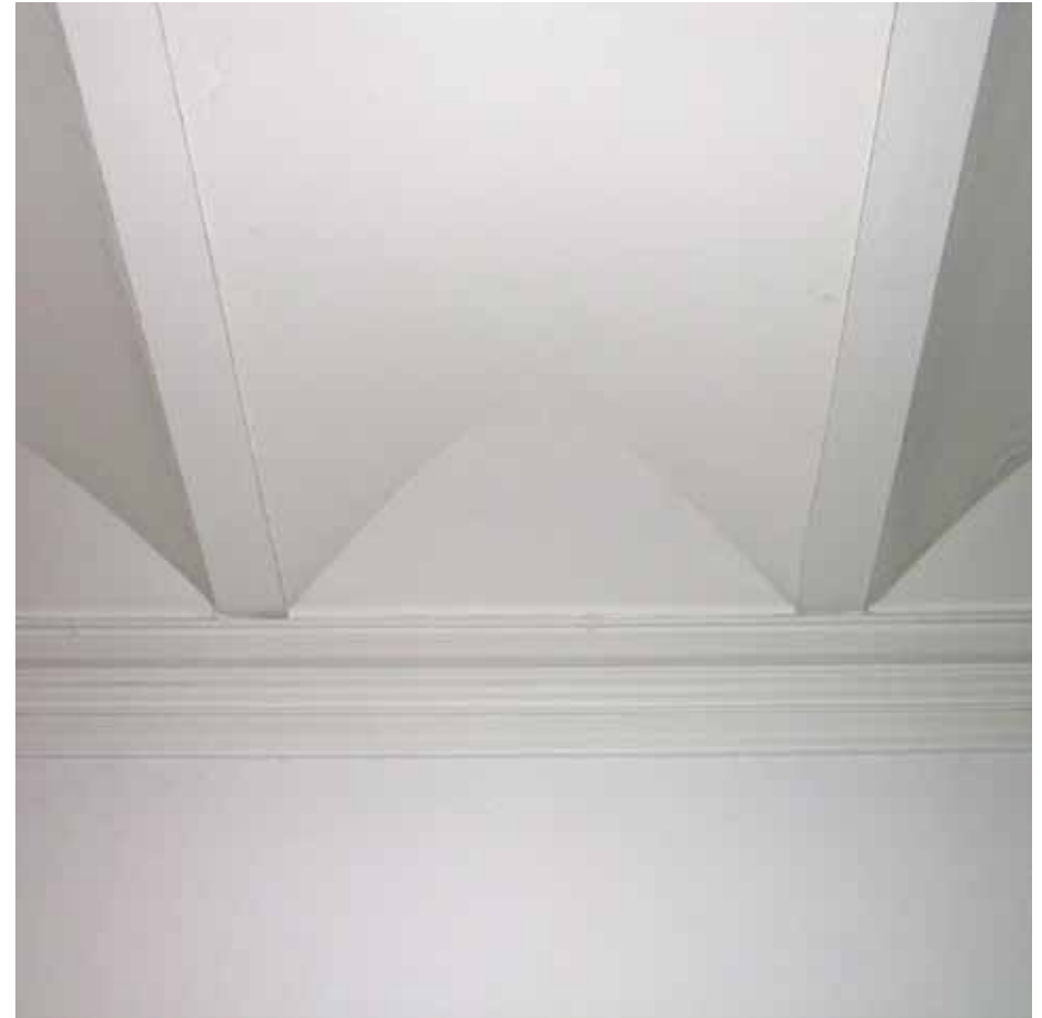
Afbeelding 44. Detail van de aansluiting van het plafond op de wanden.
