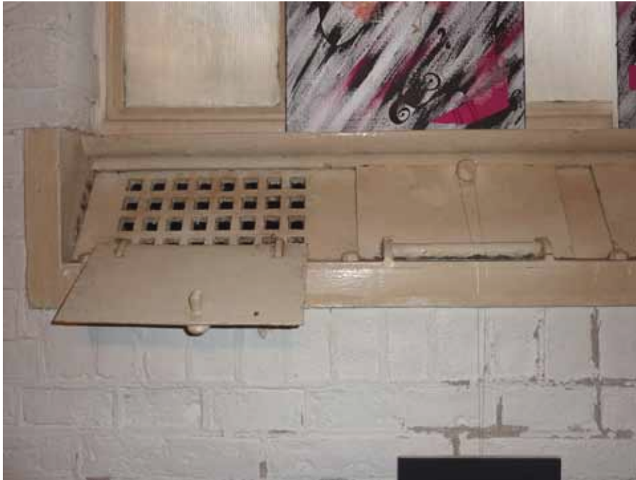
Afbeelding 33. Detail van de onderdorpel van het raam in de voorgevel. De holle gietijzeren onderdorpel is voorzien van een viertal klepjes, die ten behoeve van ventilatie kunnen worden opengezet. In de cellen was eenzelfde systeem aanwezig, maar dit werd bij het vervangen van de vensters afgedekt door een blauwe stalen plaat.
