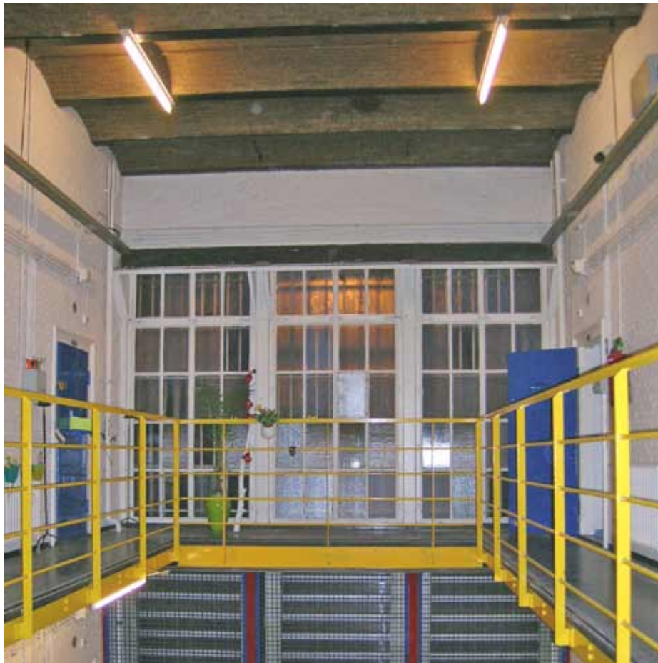
Afbeelding 24. Zicht op de binnenzijde van het venster in de voorgevel (richting het westen) vanaf de loopbrug ter hoogte van de tweede verdieping (B2.38). In het on-derste gedeelte van de pui bevinden zich horizontale lamellen (1988) uit geribt veiligheidsglas, met daarvoor stalen roosters. Ter hoogte van de tweede verdieping bevinden zich de oorspronkelijke stalen ramen. Boven het venster is, ter ondersteuning van het bovenliggende metselwerk, een getoogde ontlastingsboog aangebracht.
