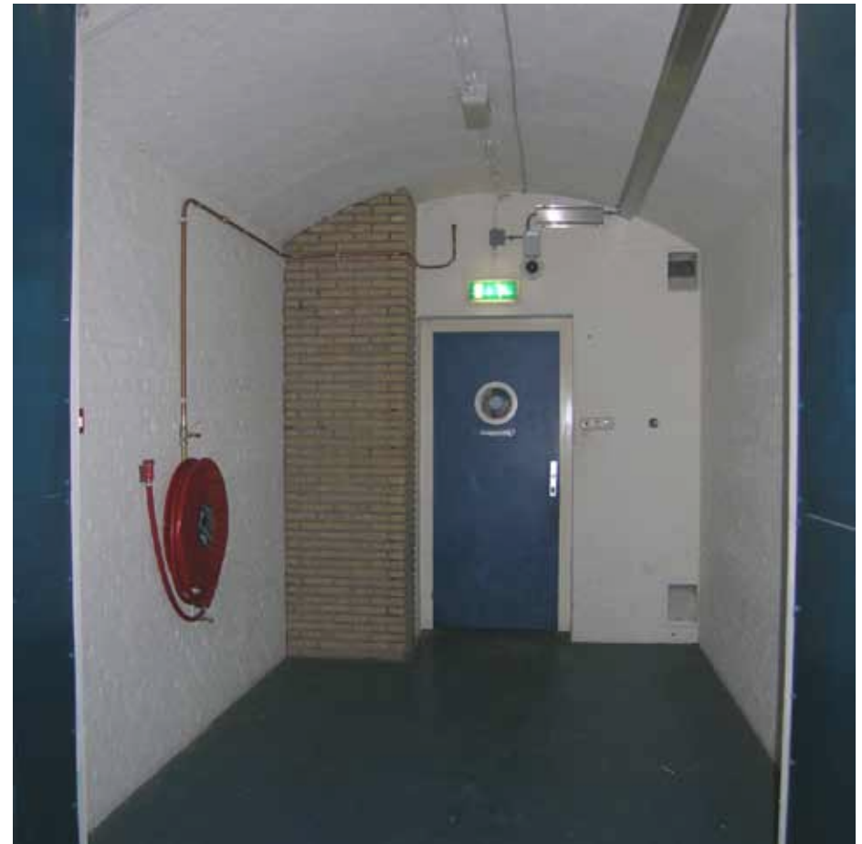
Afbeelding 51. Overzicht van het portaal richting de cellenhal (noorden).
