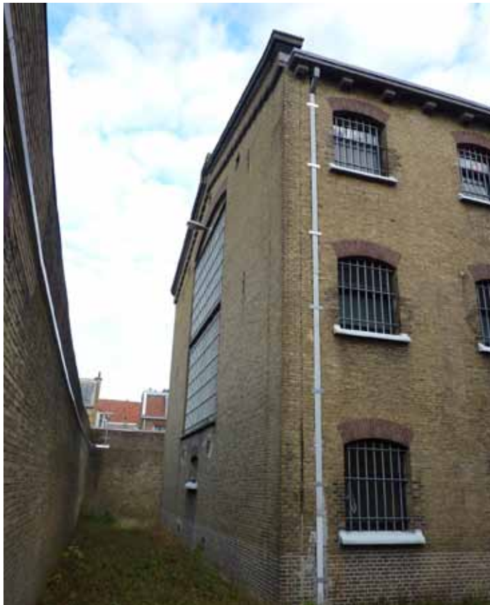
Afbeelding 4. Overzicht van de kopgevel (westgevel) van Bouwdeel I. Tot circa 60 cm boven het uit iets gladdere, hardere steen bestaande trasraam, is het metselwerk voorzien van een afwijkende platvol uitgevoerde cementvoeg (1988). Het venster in de voorgevel ter hoogte van de begane grond bezit als enige nog de oorspronkelijke hoogte van de openingen van bouwdeel I.
