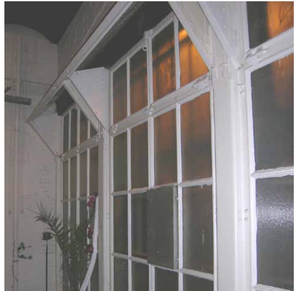
Afbeelding 25. Detail van de binnenzijde van de stalen ramen in het venster ter hoogte van de tweede verdieping (B2.38), bestaand uit 16-ruits vaste onder- en 4-ruits naar binnen vallende bovenramen. De ramen zijn uitgevoerd met een verzwaarde middenstijl, zijn voorzien van een ojief en bezitten ruiten in diverse kleuren en soorten glas.
