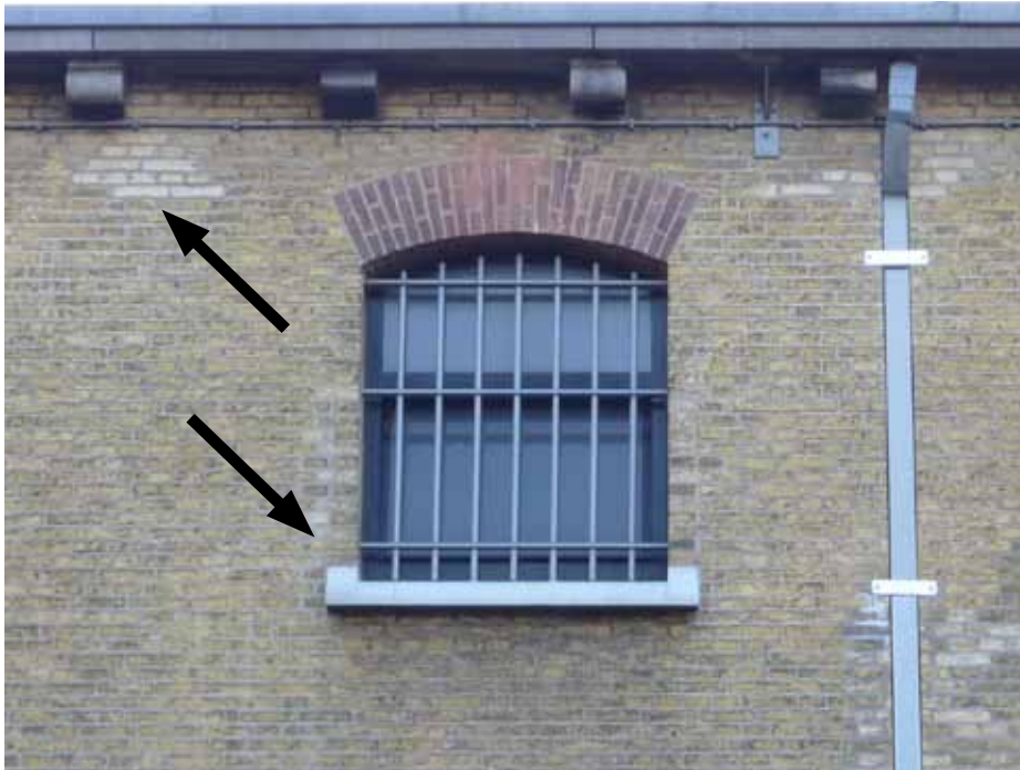
Afbeelding 14. Overzicht van een van de vensters in de zijgevels (noord- en zuidoost) ter hoogte van de eerste verdieping, met daarboven de hardstenen goot op consoles. De vensters zijn voorzien van een in rode baksteen uitgevoerde segmentboog, een gietijzeren onderdorpel en traliewerk. De stalen ramen (1997) bezitten een vast onder- en kleppend bovenraam. Onregelmatig metselwerk in het onderste deel van de dagkanten en aan weerszijden van de onderdorpel geeft aan dat deze vensters later zijn verlengd (XXb). Onder de goot zijn aan weerszijden van de vensters - in de zwikken van de achterliggende gewelven - inboetingen zichtbaar, mogelijk van oude ventilatieopeningen.
