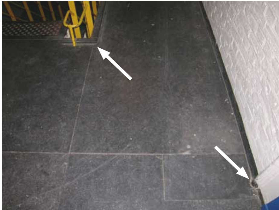
Afbeelding 22. Detail van de hardstenen platen van de galerijen op de vloeren van de eerste en tweede verdieping van de cellenhal. Rondom de vides zijn op de platen hardstenen plintjes van 5 x 2 cm aangebracht. De onderste laag van het aansluitende metselwerk van de wanden op de galerijen is zwart geschilderd. In tegenstelling tot de architraaflijsten van de deuren op de begane grond, lopen de architraaflijsten op de verdiepingen wel door tot de vloer.
