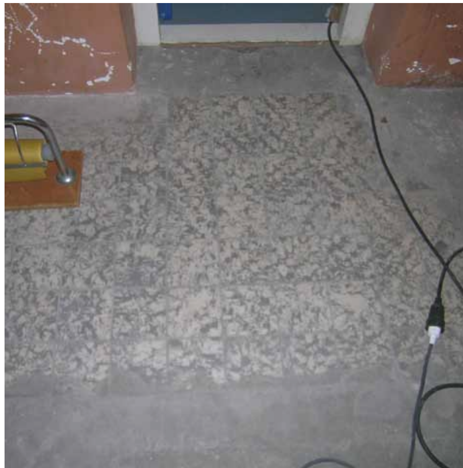
Afbeelding 41. Detail van de vloer ter plaatse van de scheidingswand met de cellenhal.
