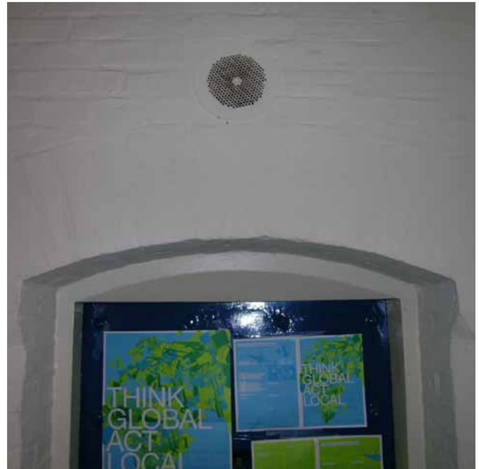
Afbeelding 36. Detail van voorgaande afbeelding. Het houten kozijn van de celdeur bevindt zich in een gemetselde doorgang die wordt overspannen door een strekse boog. De hoeken van het metselwerk zijn voorzien van vellingkanten, beëindigd door kapelletjes. Boven de deur is een ronde (ventilatie)opening aangebracht..
