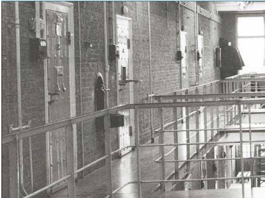
Afbeelding 60. Eén van de fonteintjes in de zuidwand van de cellenhal in februari 1983. Foto: Collectie Beeldbank Leeuwarden, documentnr.: FDBLH-SPLB023
