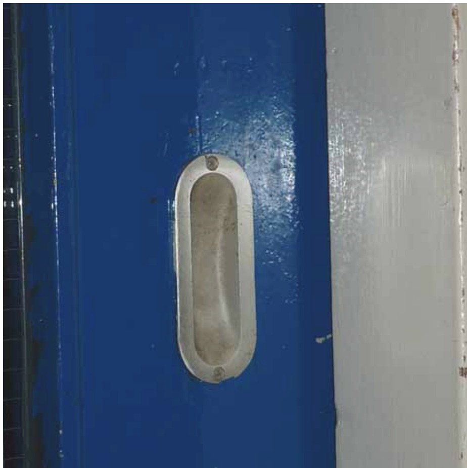
Afbeelding 49. Detail van de schuifdeur naar de bewakerruimte B0.27.
