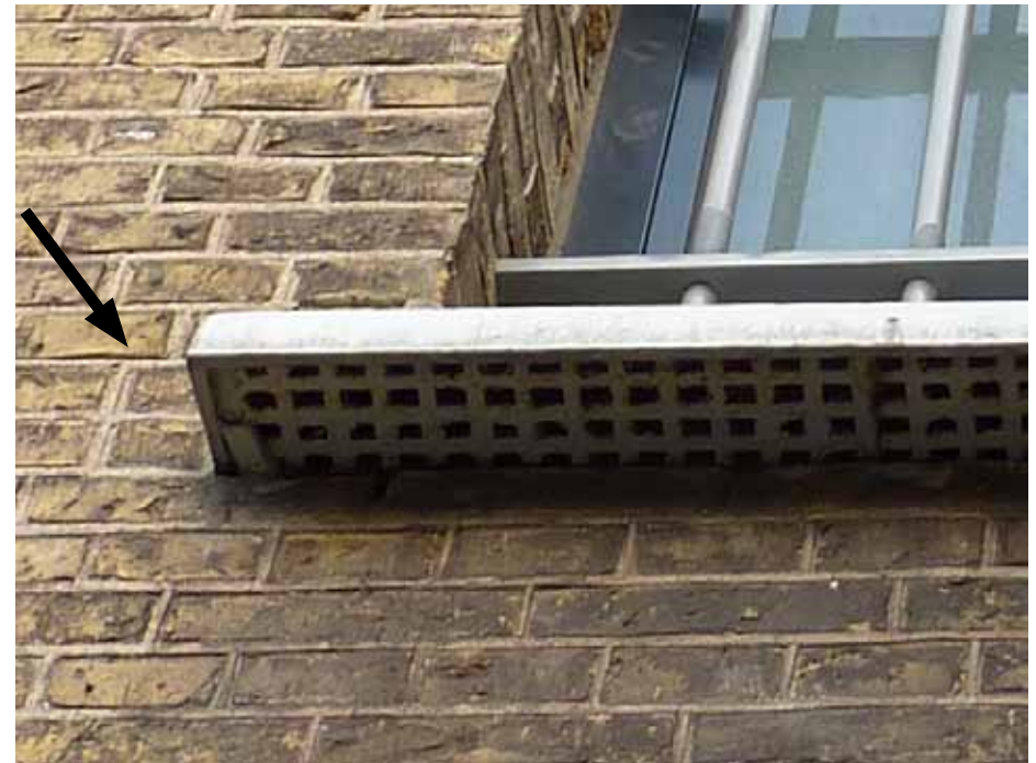
Afbeelding 15. Detail van de onderzijde van één van de onderdorpels. De onderdorpel is hol en aan de onderzijde voorzien van openingen ten behoeve van de ventilatie van de achterliggende cellen. Onregelmatig metselwerk aan weerszijden van de onderdorpel geeft aan dat deze vensters later zijn verlengd (XXb).
