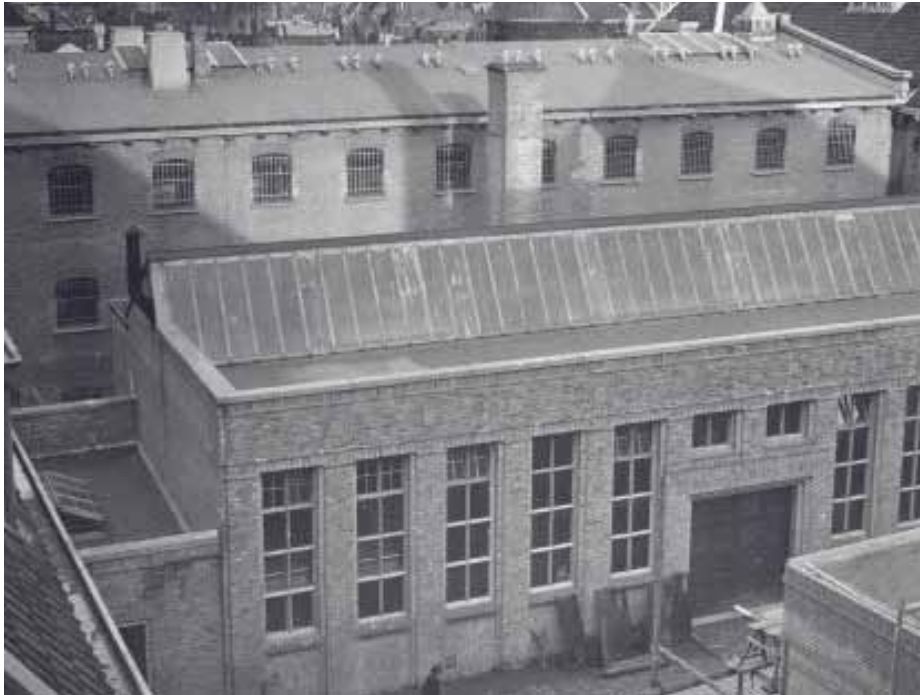
Afbeelding 12. Overzicht van de smederij ter plaatse van de voormalige luchtplaatsen aan de zuidzijde van bouwdeel I in 1948, direct na het gereedkomen van de bouw. De werkplaats rechts op de voorgrond van de foto is getuige de steigers nog in aanbouw. De vensters van de cellen van bouwdeel I waren hier reeds verlengd. Het roevendak heeft hier reeds plaatsgemaakt voor bitumen, waarbij de zinken ventilatiekappen van de cellen behouden werden. Foto: Collectie Beeldbank Leeuwarden, documentnr.: FDBLHSPLA032
