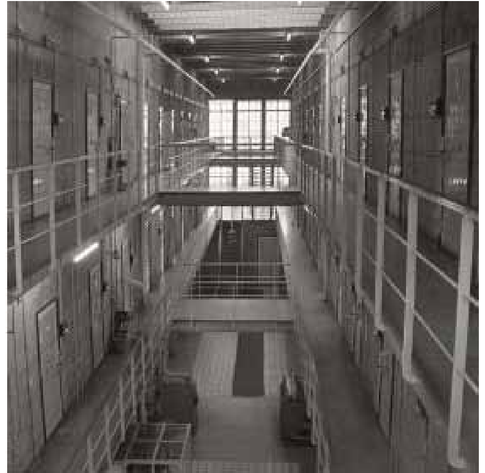
Afbeelding 29. Overzicht van de cellenhal in 1959. Hier is de oorspronkelijk tegelvloer nog in het zicht, evenals de balustrades en de fonteintjes op de eerste en tweede verdieping links van cellen B1.08 en B2.08. Hiervan zijn nu de dichtzettingen zichtbaar met rechts daarvan de sparing ten behoeve van de afvoer. Het onderste deel van het venster in de westgevel was nog niet voorzien van ventilatieschoepen. Foto: Collectie Beeldbank Leeuwarden, documentnr.: BDO0421
