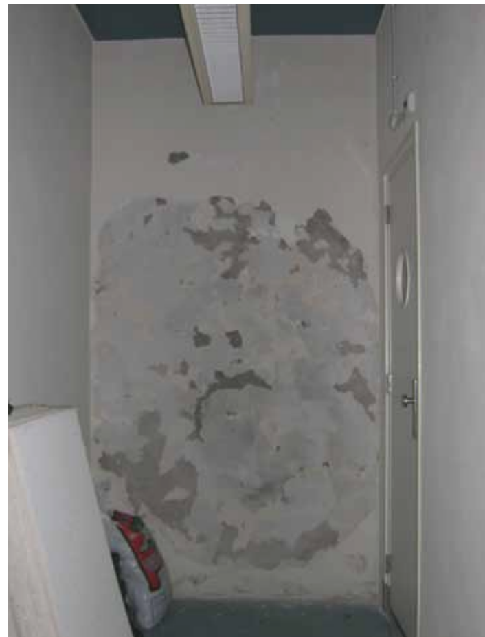
Afbeelding 44. Overzicht van ruimte B07.4 gezien richting het westen.
