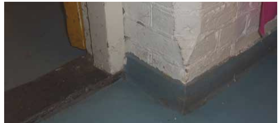
Afbeelding 32. Onder- en bovendetail van de deur naar de cellenhal B0.32. De gemetselde deuropening is voorzien van vellingkanten - beëindigd door kapelletjes - en wordt overspannen door een segmentboog. De getoogde bovendeur van het kozijn is aan de binnenzijde afgeschuind.
