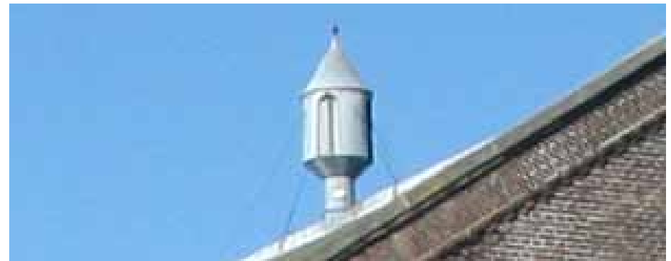
Afbeelding 58. Detail van een vergelijkbare ventilatiekap op één van de vleugels van de gevangenis aan het Wolvenplein te Utrecht.
