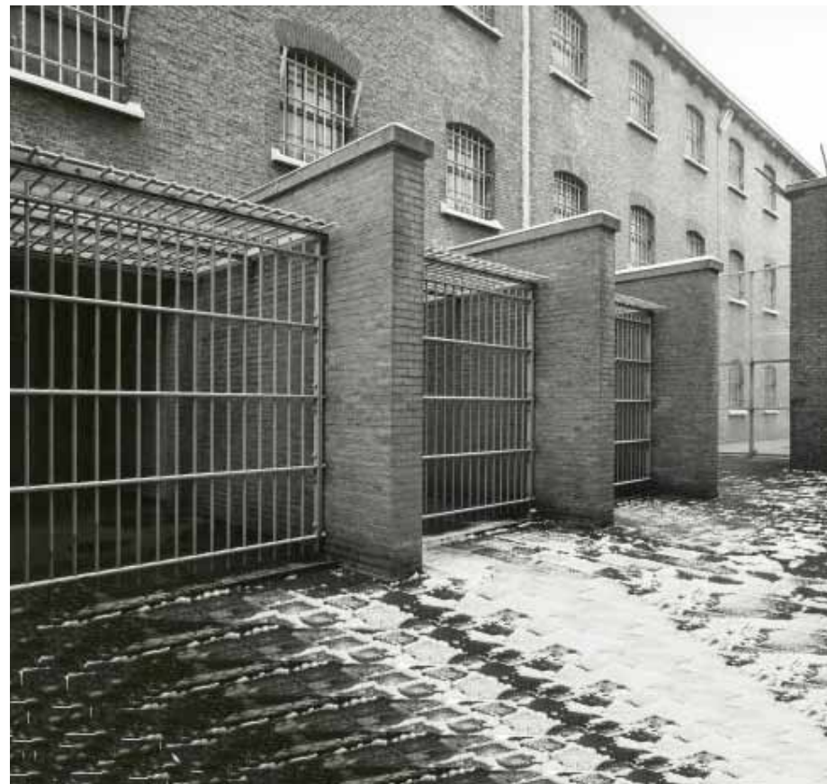
Afbeelding 7. Linker gedeelte van de zuidgevel in februari 1983. De meest linker luchtkooi is op dit moment nog aanwezig, de middelste herbergt de containerruimte en de rechter is opgenomen in de verbindingsgang naar bouwdeel B. Foto: Collectie Beeldbank Leeuwarden, documentnr.: FDBLHSPB089
