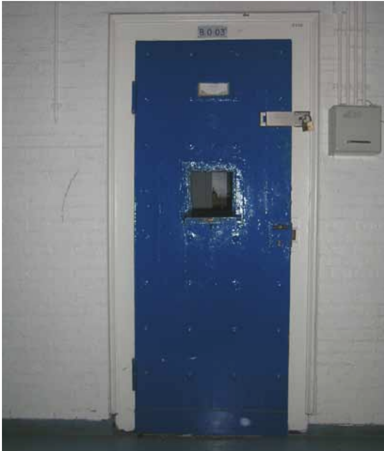
Afbeelding 26. Aanzicht vanuit de hal van één van de deuren naar de cellen. Op de begane grond zijn de architraaflossen op onregelmatige hoogte (ongeveer 6 cm) boven de vloer afgezaagd. De houten celdeuren zijn voorzien van een kijkgat, schaftklep en (naam)plaatje. Boven het oorspronkelijke rechthoekige opdekslot is zeer recent (2007) een tweede slot aangebracht. Elke cel bezit een eigen stoppenkastje.
