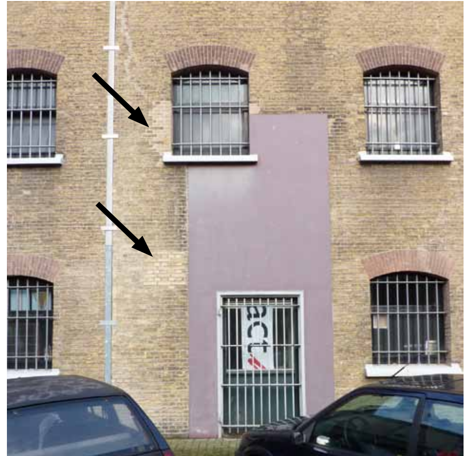
Afbeelding 11. Detail van de zuidgevel rechts van het midden. Hier bevond zich tot 1948 de doorgang naar de luchtkooien en tot 1976 naar de smederij op de binnenplaats. Links van het pleisterwerk bevindt zich een dichtzetting van een ronde ventilatieopening. De deels in het pleisterwerk uitgespaarde venster-opening bezit duidelijk lichtere sporen van inboetwerk dan de overige vensters. Dit zou verklaard kunnen worden door het feit dat de overige vensters in het tweede kwart van de twintigste eeuw werden verlengd.
