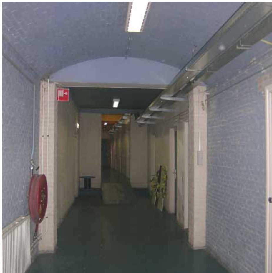
Afbeelding 43. Overzicht van ruimte B0.28 gezien richting bouwdeel B (zuiden).
