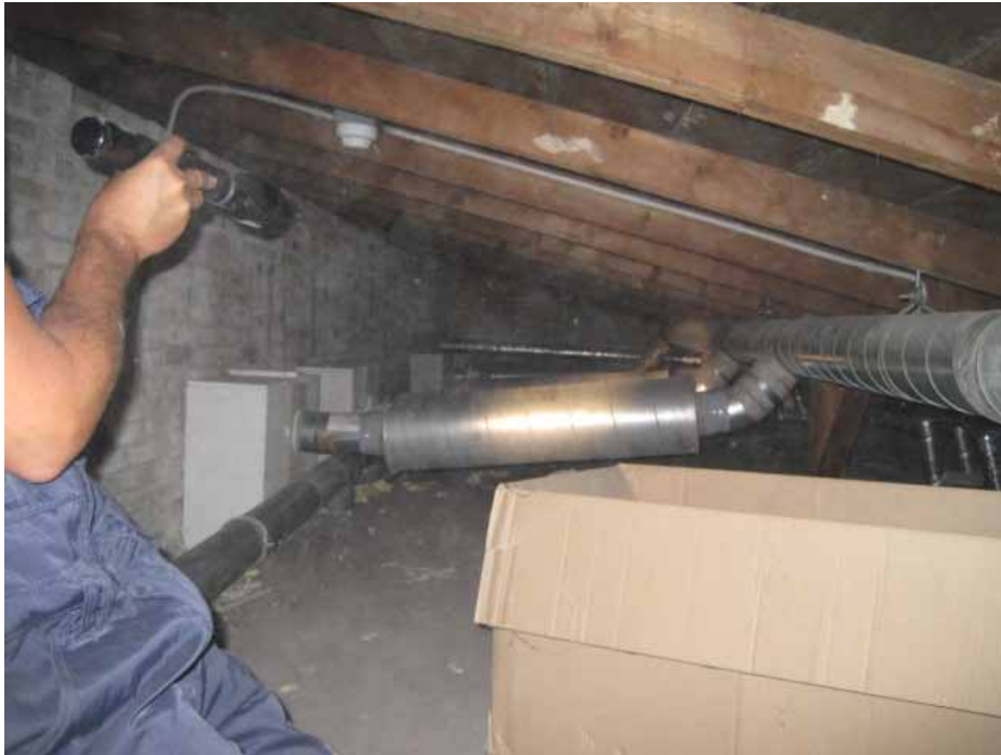
Afbeelding 55. Zicht in de kapconstructie boven de cellen met een moderne ventilatie-installatie. Foto: dhr. Bastiaans, Monumentenwacht Overijssel en Flevoland / Drenthe 2009.
