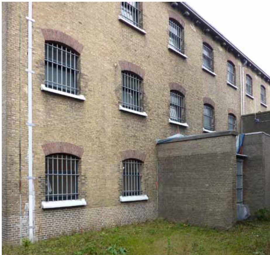
Afbeelding 6. Overzicht van het linker deel van de zuidgevel. Ter plaatse van de derde tot en met de vijfde gevelas van links zijn diverse aanbouwen gerealiseerd. Rechts nog een fragment van de luchtplaats (1965).
