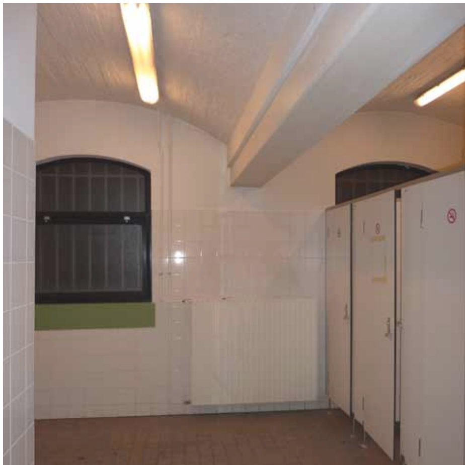
Afbeelding 46. Overzicht van ruimte B0.35, gezien richting de noordgevel.
