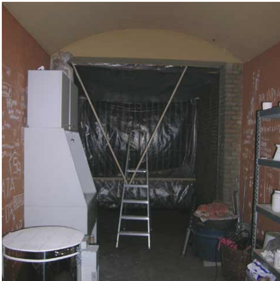
Afbeelding 40. Overzicht van ruimte B0.30 gezien richting de buitengevel (zuidzijde).
