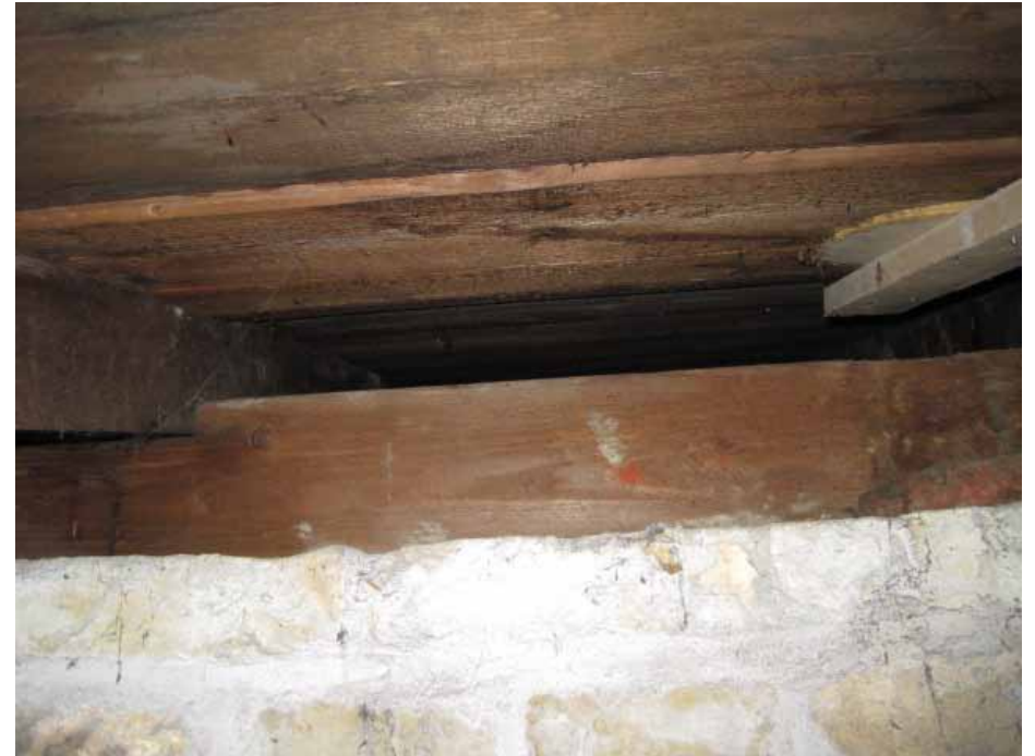
Afbeelding 56. Zicht vanuit de zolderruimte boven de cellen naar de ruimte boven de cellenhal. Detail van de muurplaat op de bouwmuur van de cellenhal, die de daksporen halverwege het zadeldak ondersteunt. Foto: Dhr. Bastiaans, Monumentenwacht Overijssel en Flevoland / Drenthe 2009.
