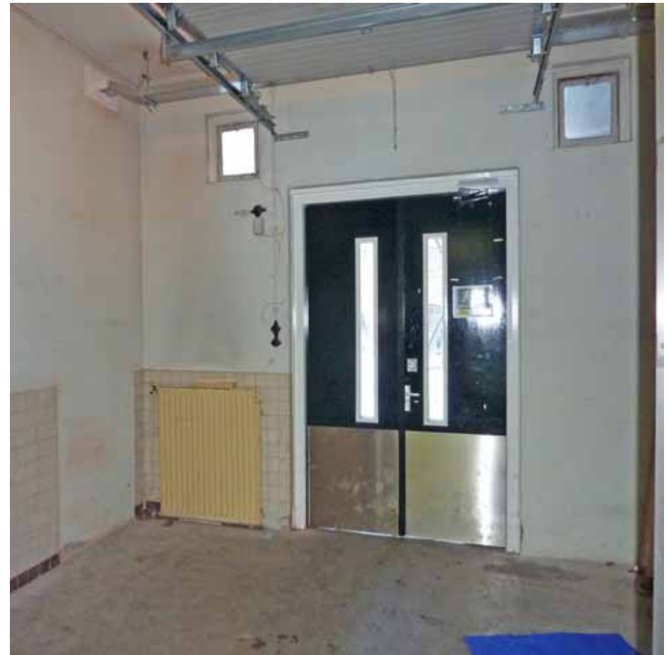
Afbeelding 15. Overzicht van het interieur van de hal K0.15, gezien naar het noorden. Links is het bouwspoor in het tegellambris uit 1957 zichtbaar met een vroegere doorgang naar de aangrenzende bezoekersruimte.
