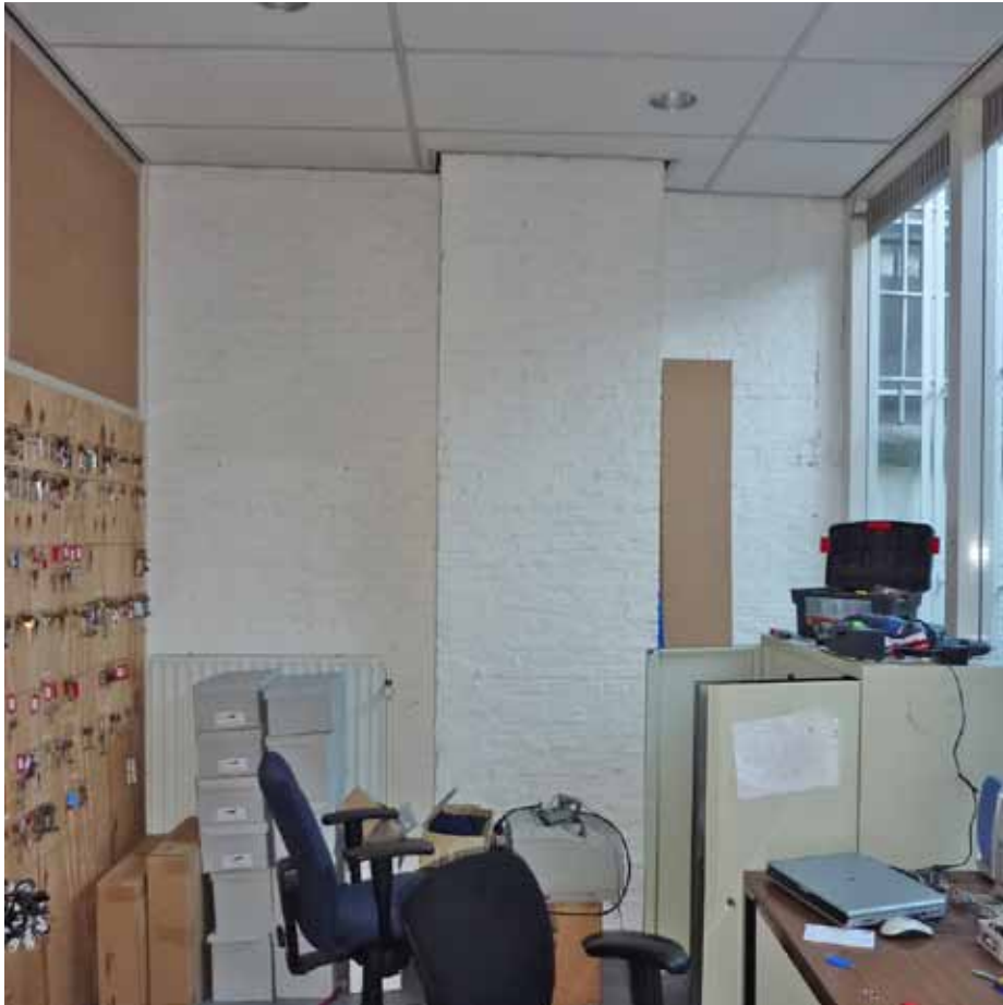
Afbeelding 19. Zicht in de wachtruimte L0.14 naar het zuiden met de bouwmuur van bouwdeel C, die nog als buitenmuur met gesneden voegen herkenbaar is (1870).
