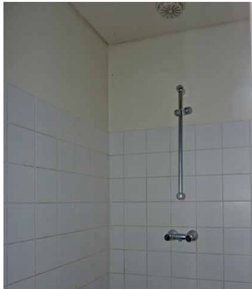
Afbeelding 12. Zicht in één van de douches (L0.19 en L0.20). De ruimten zijn middels witte wandtegels en dubbelhardgebakken vloertegels van 15 x 15 cm elementair afgewerkt en van de zogenaamde blauwe 'patrijspoortdeuren' voorzien (1988).
