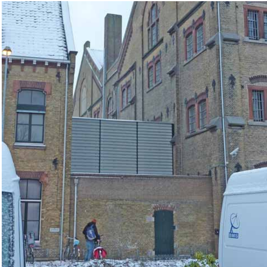
Afbeelding 6. Zicht op de blinde buitenmuur uit 1870 met de getoogde opgeklampte deur, die oorspronkelijk tot de tuin van de kommandantswoning toegang gaf (1870). De muur werd later opgehoogd. De bovenbouw met de golfplaten gevelbekleding is recent (2000).
