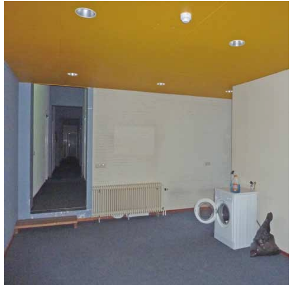
Afbeelding 21. De noordwand van ruimte L1.08 is ongepleisterd en betreft de oorspronkelijke zijgevel van bouwdeel B, bestaande uit metselwerk in kruisverband met gesneden voegen (1870).
