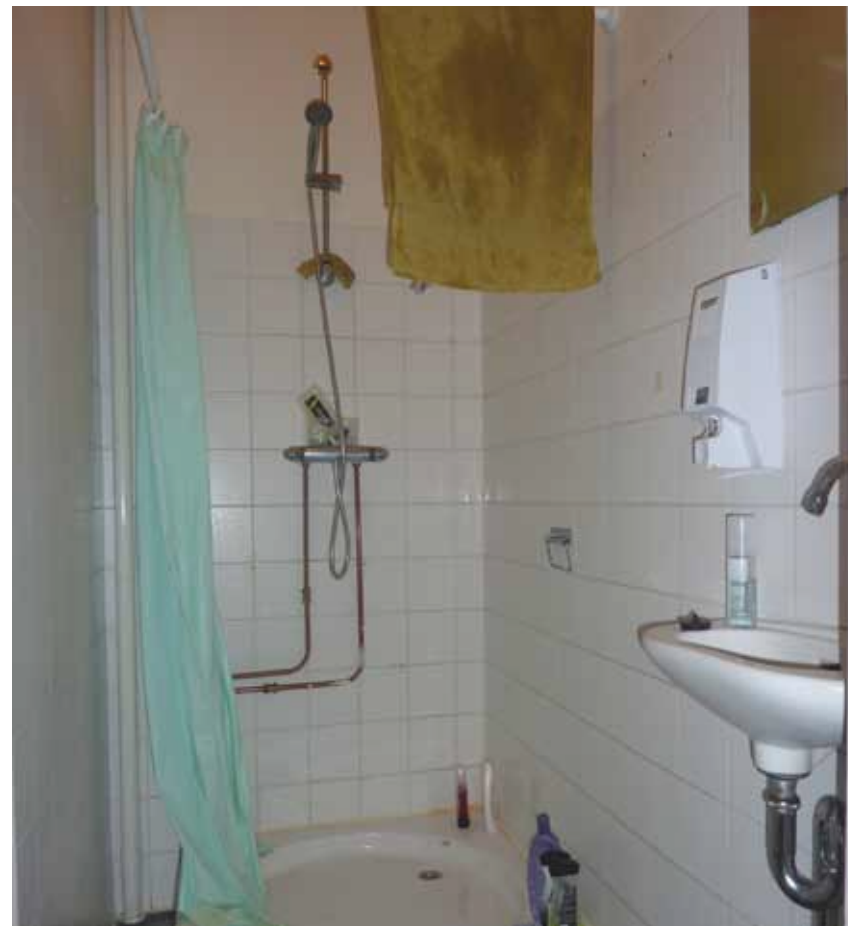
Afbeelding 23. Detailopname van de eenvoudige betegelde douche in ruimte L1.09.
