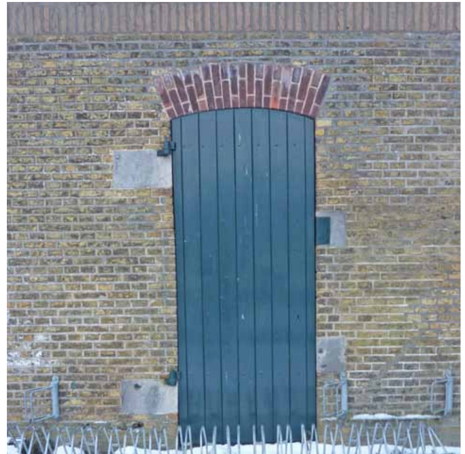
Afbeelding 7. Detail van de westgevel met de uit de bouwtijd daterende opgeklampte deur, voorzien van kraaldelen, gehengen en hardstenen duimblokken.
