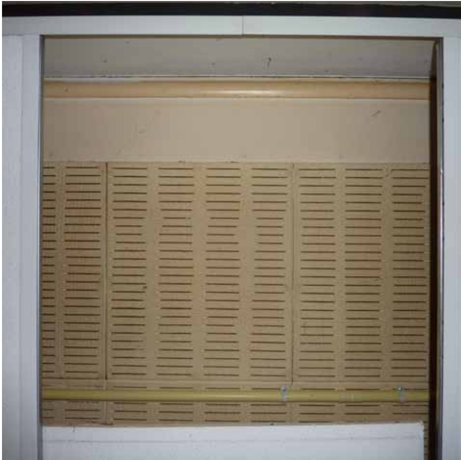
Afbeelding 13. Detail van het plafond in de voormalige bezoekersruimte. Het plafond bestaat uit een systeemplafond (1988), waarboven zich nog de uit de bouwtijd daterende akoestische zachtboardplaten bevinden (1957).
