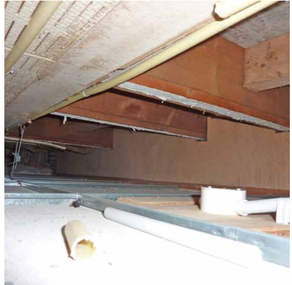
Afbeelding 14. Zicht op het plafond boven de gang L0.12. Het plafond bestaat uit een systeemplafond (1988), waarboven zich aan de linkerkzijde de uit de bouwtijd daterende akoestische zachtboardplaten bevinden (1957). Rechts is de nieuwere balklaag van de in 1988 aan de westzijde aangebouwde gang en bezoekersruimte zichtbaar.
