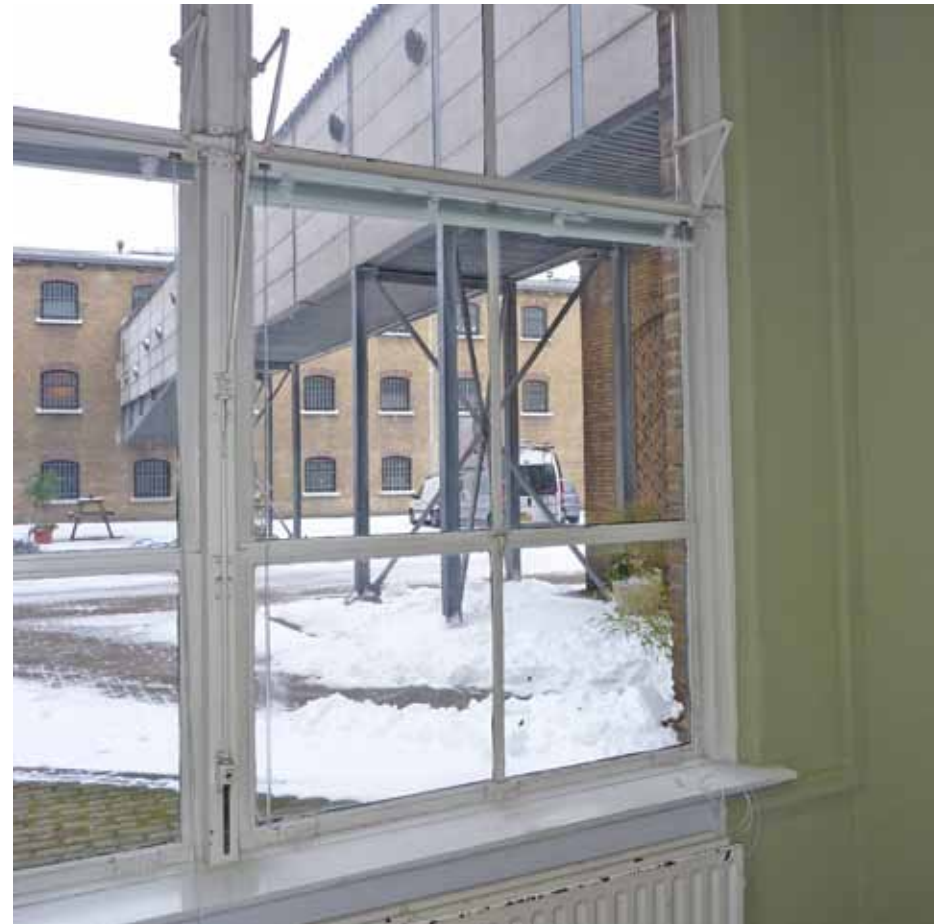
Afbeelding 10. Detail van de ramen in de noordgevel. De stalen ramen bezitten nog de karakteristieke uit de bouwtijd daterende uitzetramen en het bijbehorende bedieningsmechanisme (1957). De ramen zijn aan de onderzijde afgewerkt met een strakke, doch verzorgd gedetailleerde vensterbank.
